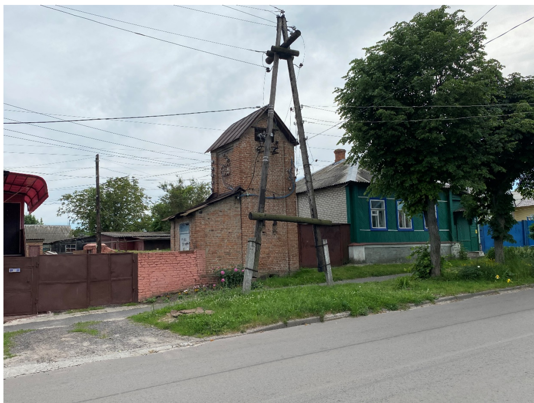
Фотография № 8. Вид с северо-востока на Объект.
