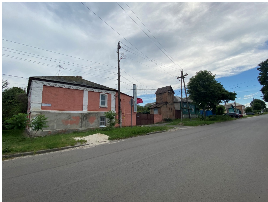
Фотография № 10. Вид с северо-востока на Объект.
