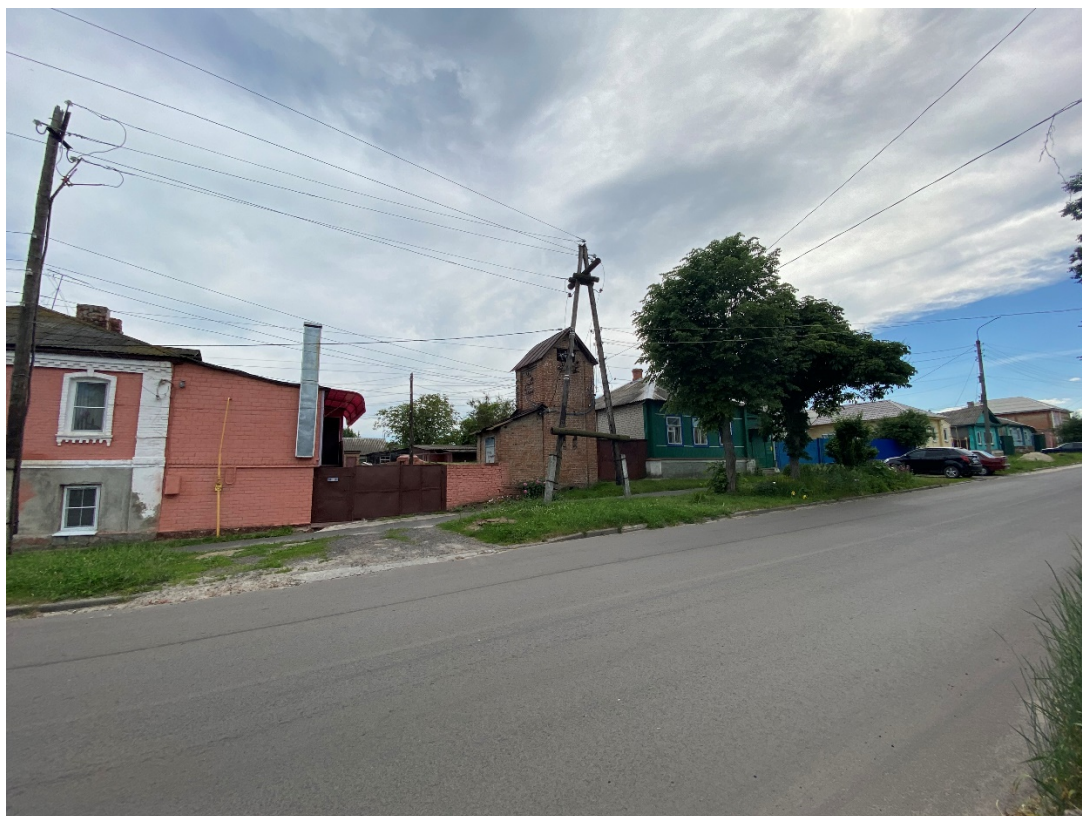
Фотография № 9. Вид с северо-востока на Объект.
