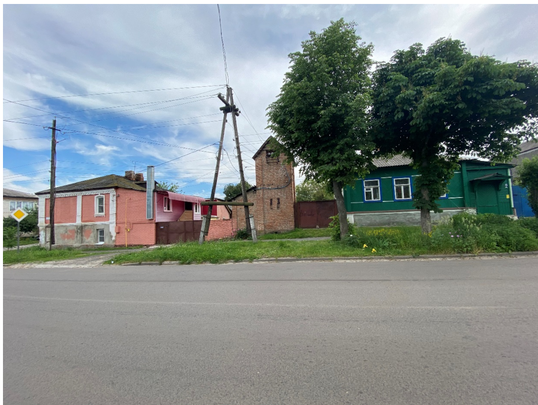
Фотография № 5. Вид с севера на Объект.
