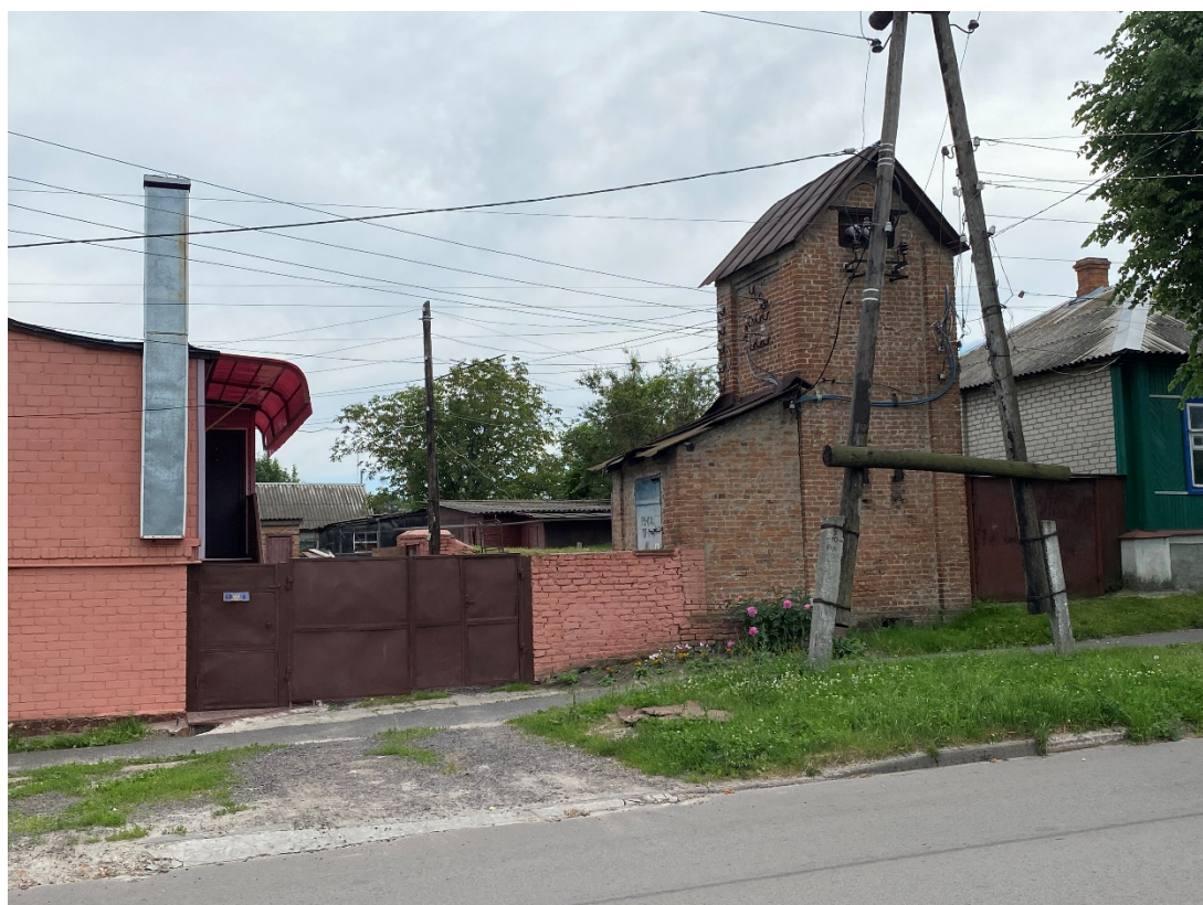
Фотография № 6. Вид с севера на Объект.
