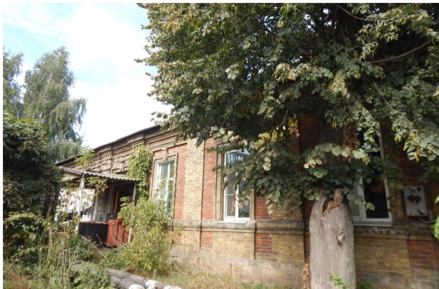
Точка 17. Вид с юго-востока на фрагмент южного фасада.
