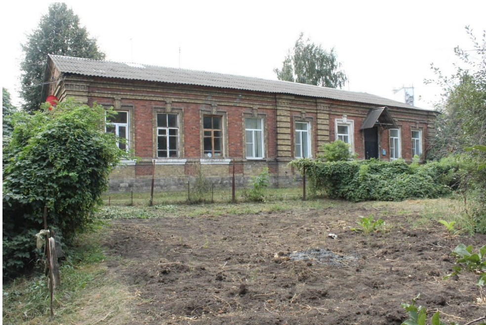
Вид на северный фасад.
