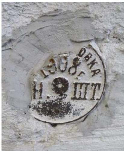
Фотография. Геодезический кованный репер, установленный внизу угловой югозападной лопатки южного фасада «Нивелировка 1908 г. Н. ШТ.».
