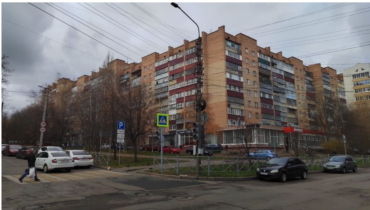
Фотография № 8. Вид с юго-востока на территорию расположения Объекта (с пересечения ул. Горького и ул. Кати Зеленко)
