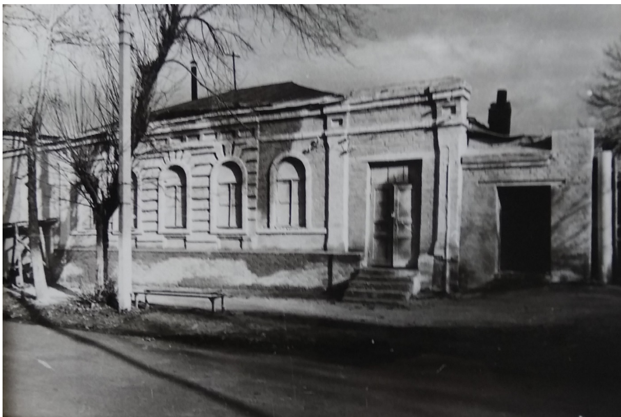
16. Дом по ул. Урицкого, 55.
