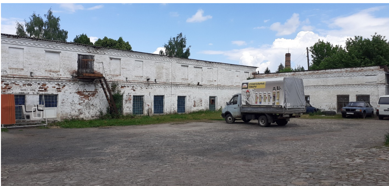
Фотография № 8. Вид с юго-запада на Объект.
