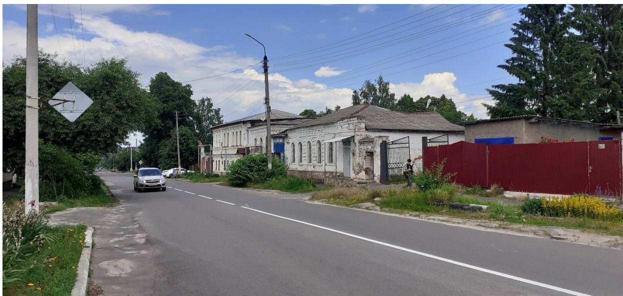
Фотография № 13. Вид с юго-запада на Объект.
