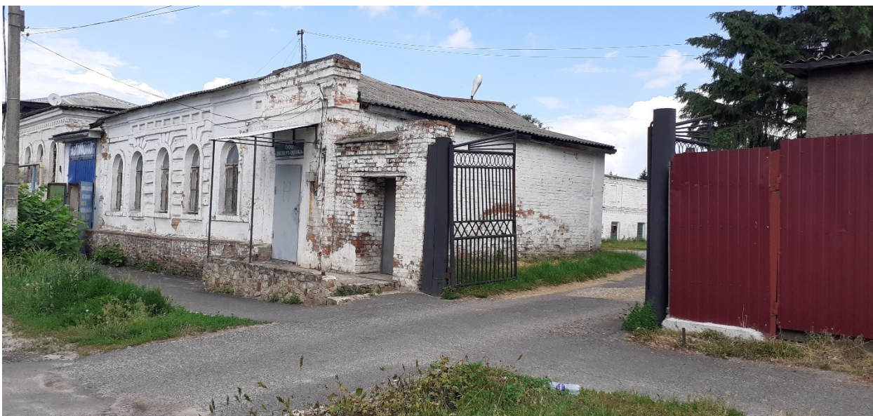
Фотография № 7. Вид с юго-запада на Объект.
