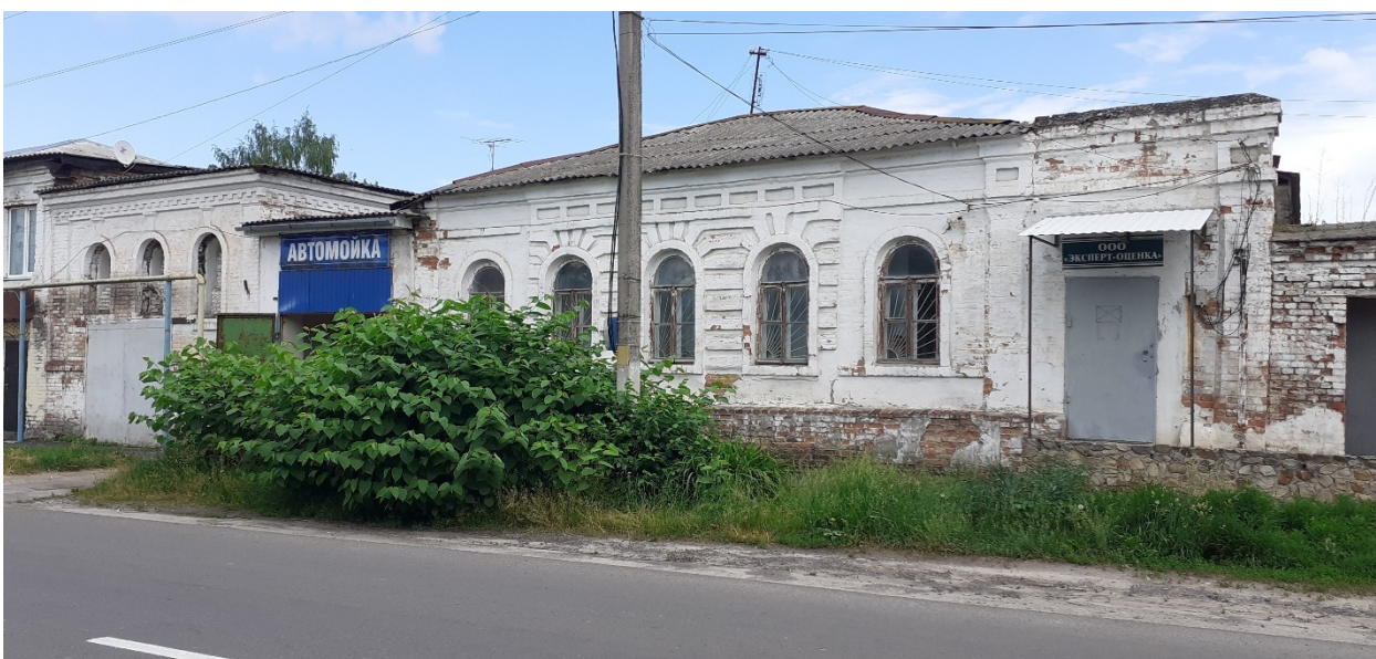
Фотография № 6. Вид с юго-запада на Объект.
