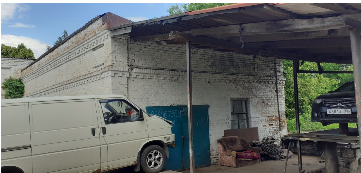
Фотография № 10. Вид с юго-запада на Объект.
