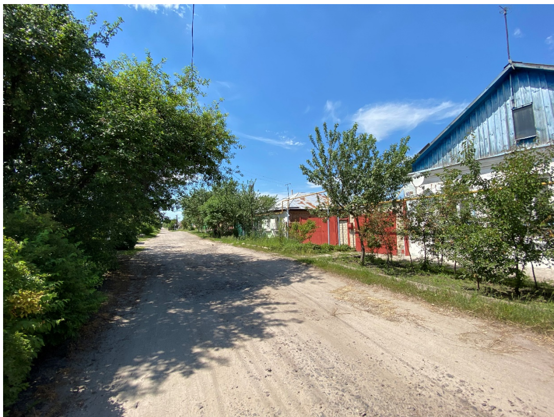
Фотография № 1. Вид с юго-востока на Объект.
