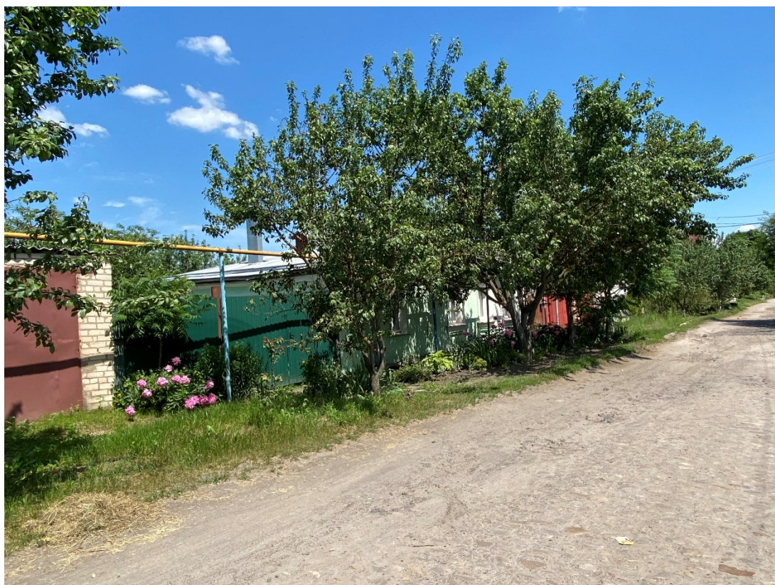
Фотография № 10. Вид с юго-запада на Объект.
