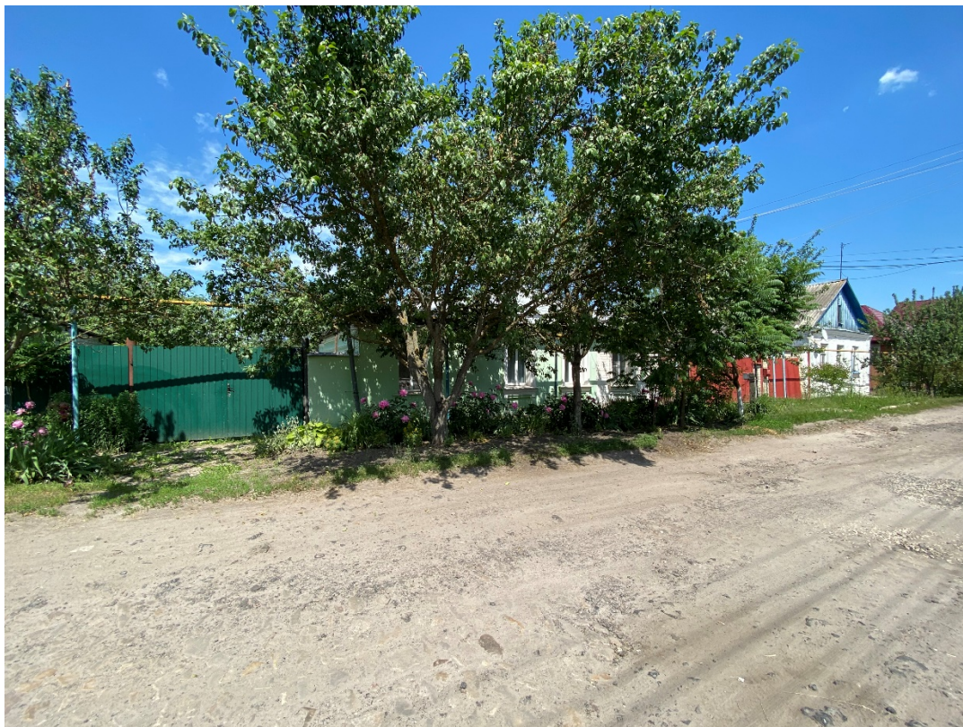
Фотография № 9. Вид с юго-запада на Объект.
