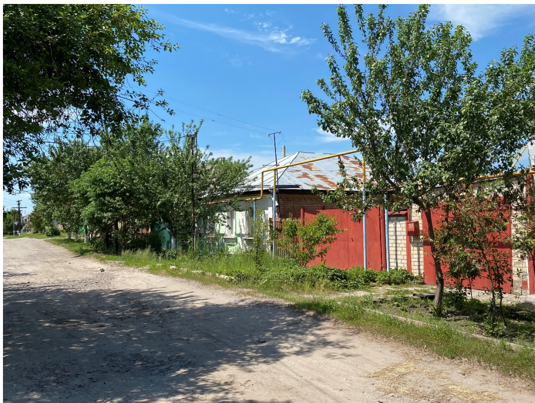
Фотография № 2. Вид с юго-востока на Объект.
