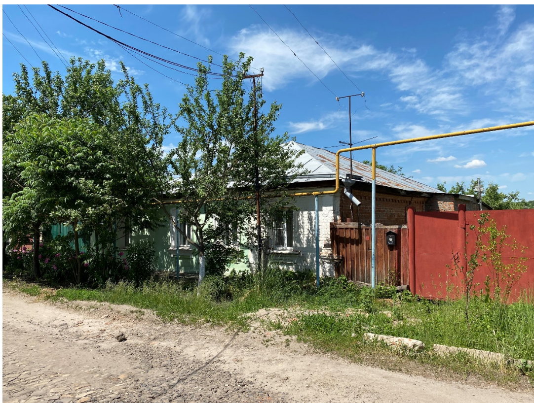
Фотография № 4. Вид с юго-востока на Объект.
