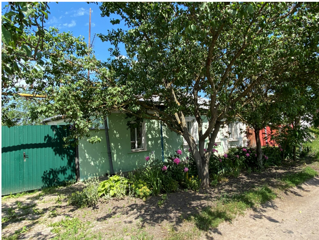
Фотография № 7. Вид с юго-запада на Объект.
