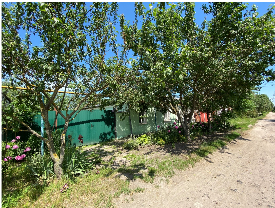
Фотография № 8. Вид с юго-запада на Объект.
