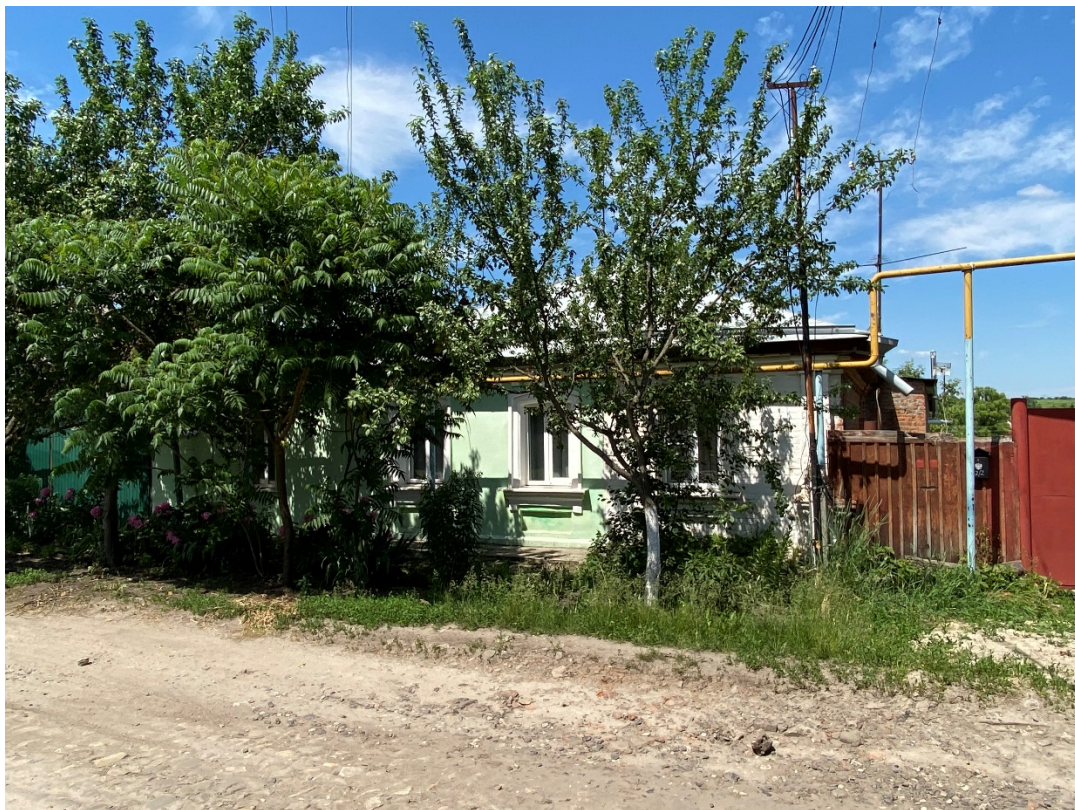
Фотография № 5. Вид с юго-востока на Объект.
