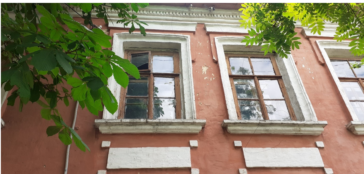
Фотография № 10. Вид с севера на Объект. Центральный фасад. Фрагмент.
