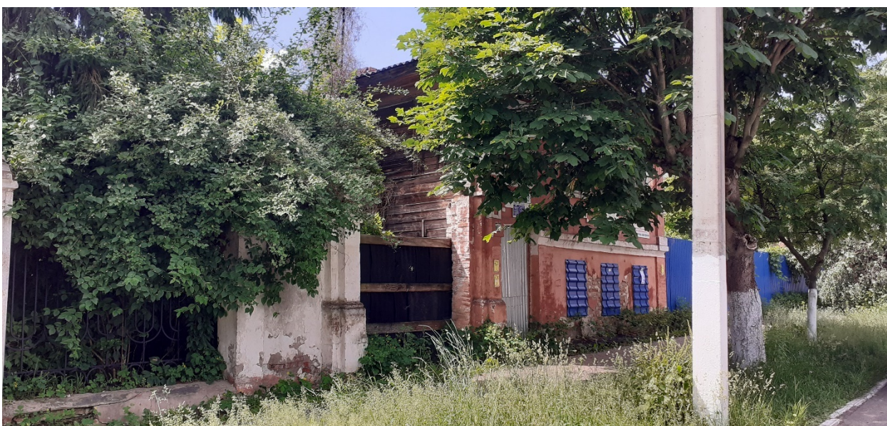
Фотография № 4. Вид с северо-востока на Объект.
