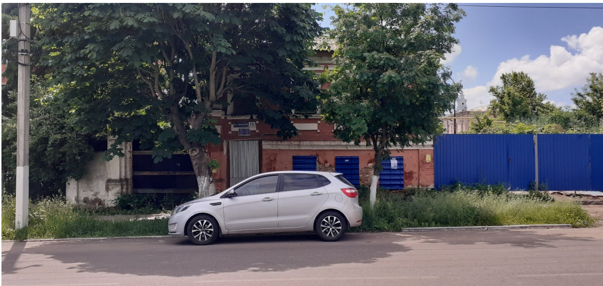
Фотография № 5. Вид с севера на Объект.
