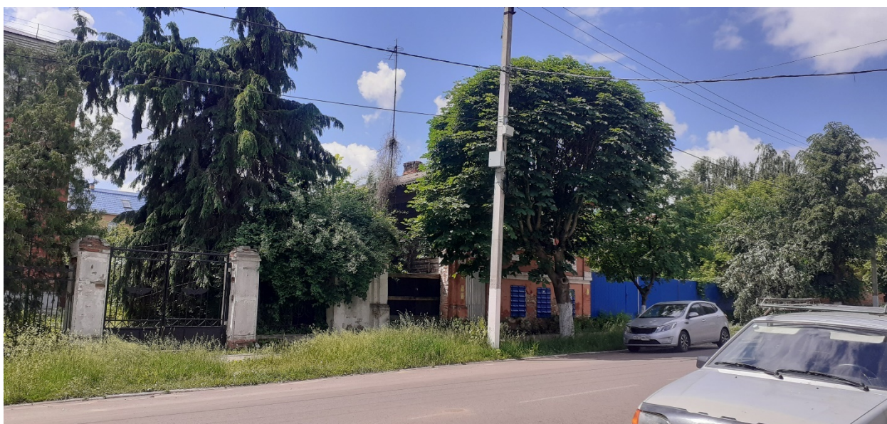
Фотография № 2. Вид с северо-востока на Объект.
