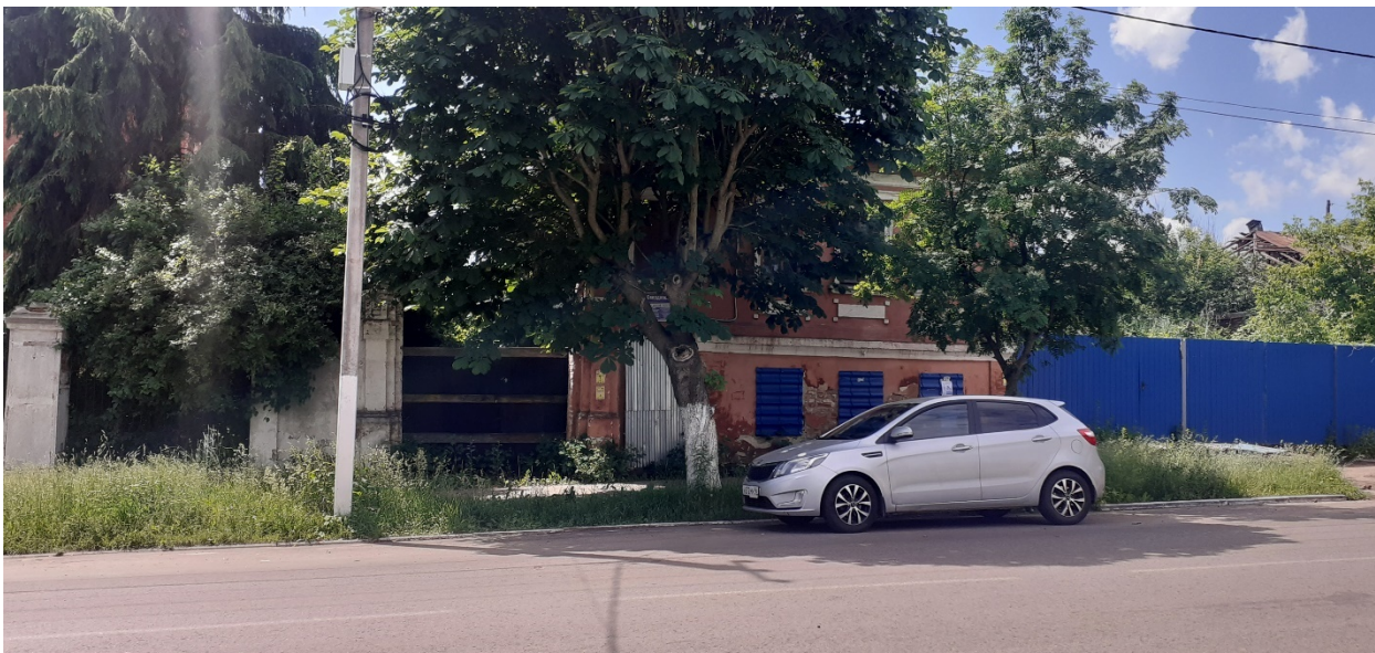
Фотография № 3. Вид с северо-востока на Объект.
