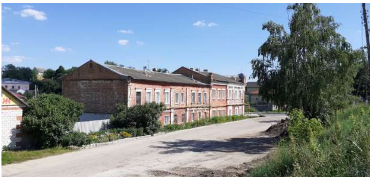
Фотография № 10. Вид с северо-запада на Объект.
