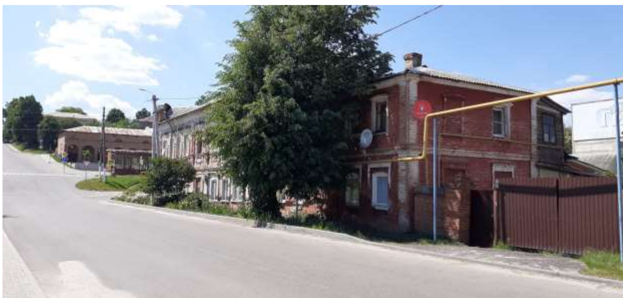
Фотография № 2. Вид с юго-востока на Объект.
