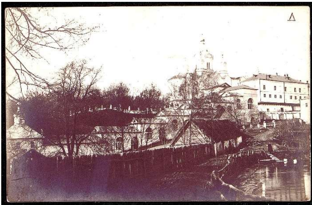
19. Коренная пустынь. Вид с северо-восточной стороны.
