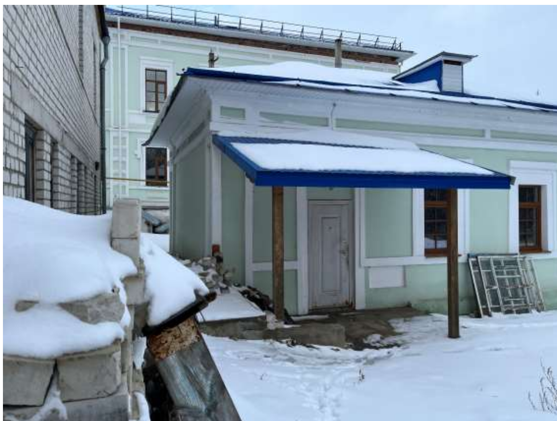
Т.ф. 2. Общий вид на входную группу со стороны южного фасада Объекта
