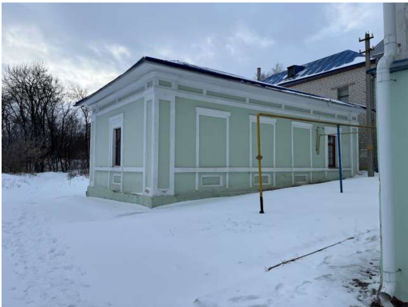
Т.ф. 5. Общий вид восточного и северного фасадов Объекта
