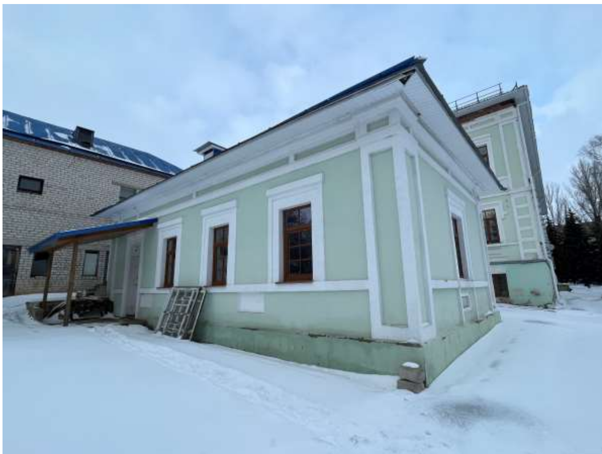
Т.ф. 3. Общий вид на южный и восточный фасады Объекта
