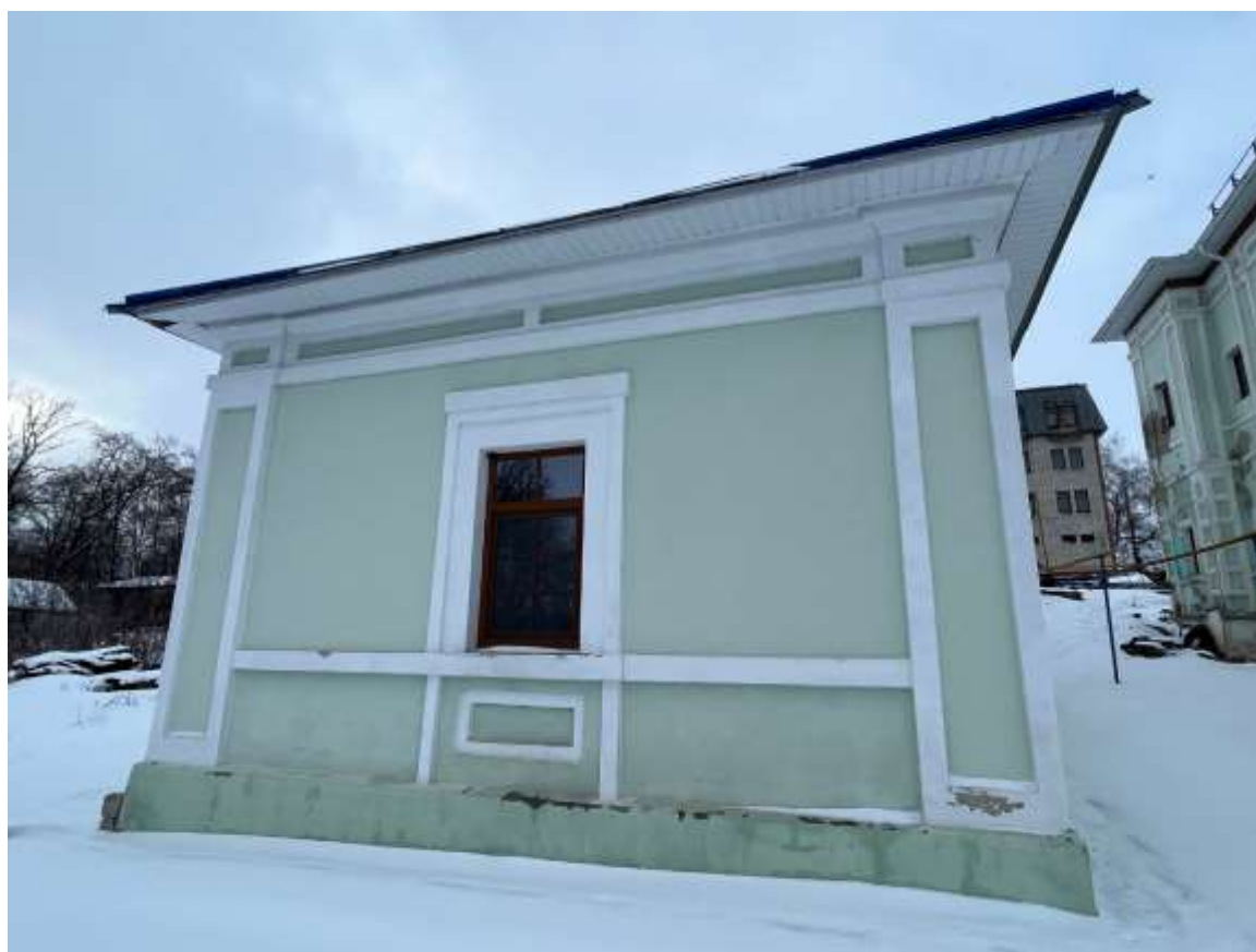
Т.ф. 4. Общий вид восточного фасада Объекта
