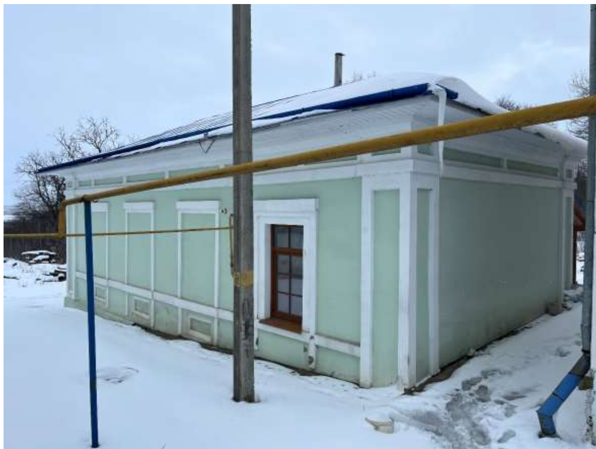
Т.ф. 7. Общий вид северного и западного фасадов Объекта.
