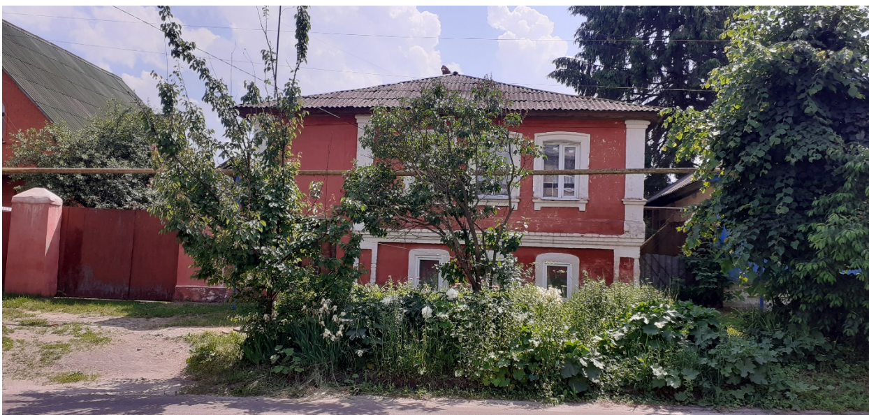
Фотография № 6. Вид с севера на Объект.
