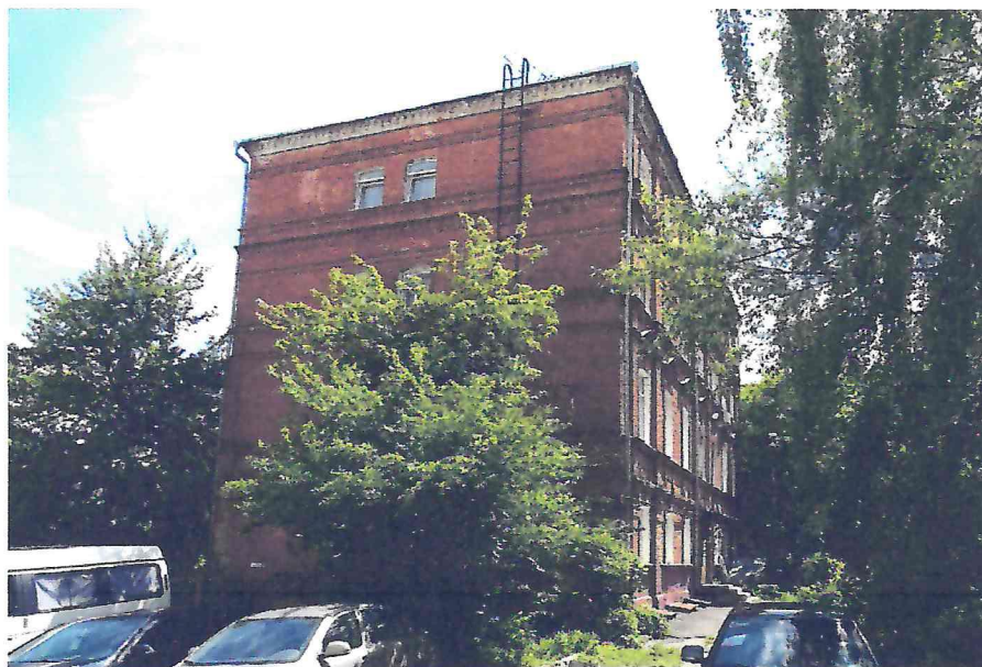
Общий вид северного и западного фасадов
