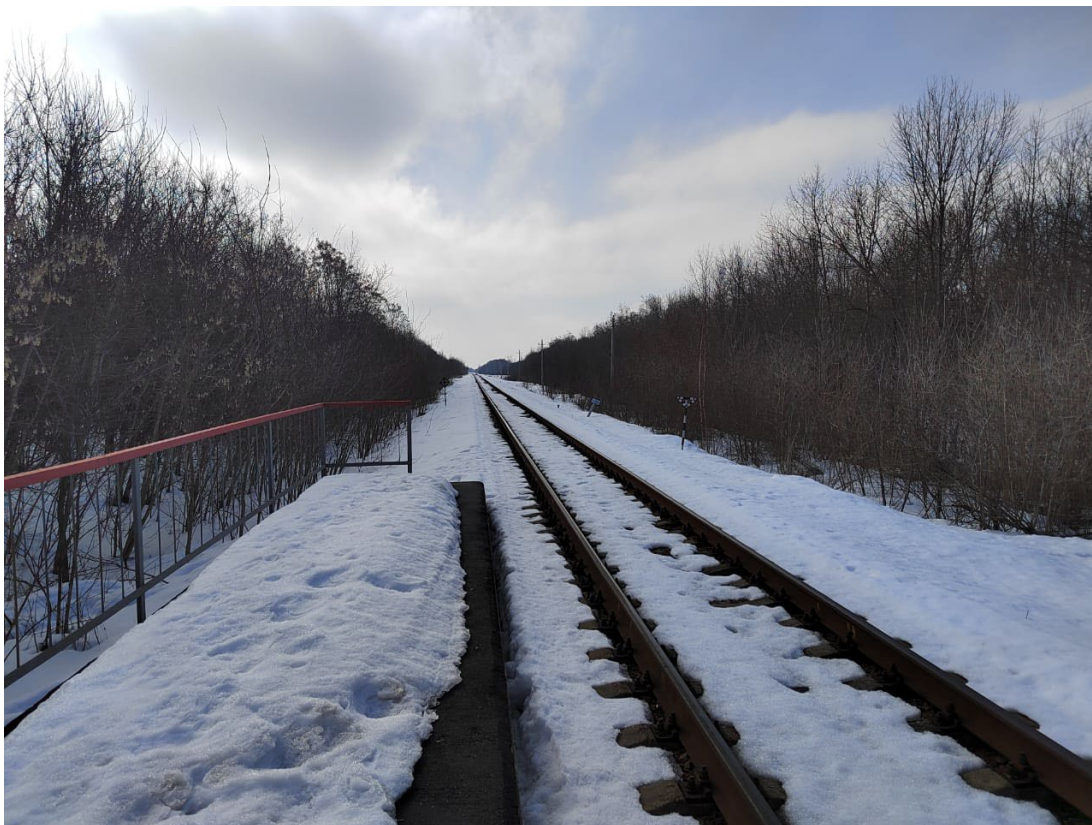
Т.ф. 9. Вид с севера со ст. Rogozinskaya в сторону ст. 125 км
