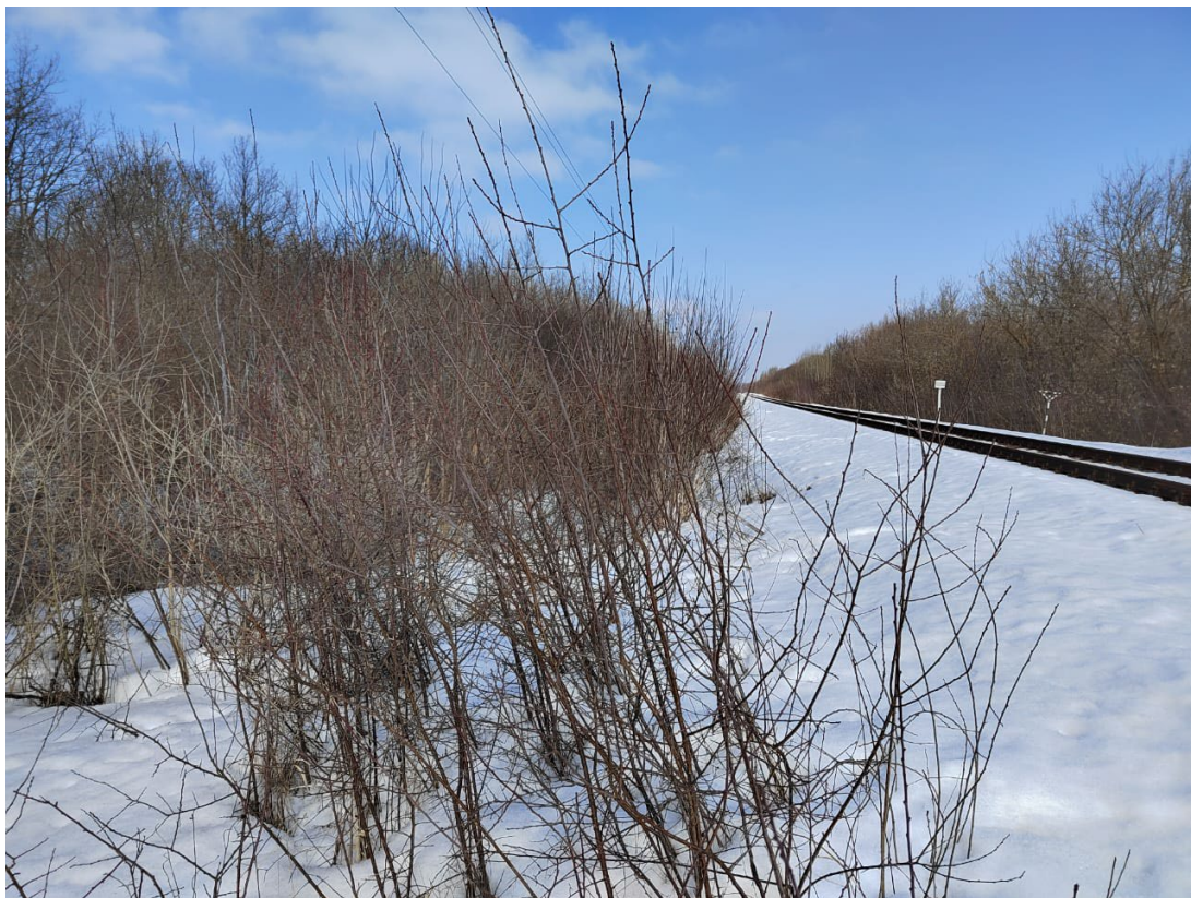
Т.ф. 5. Вид с юга на железнодорожные пути в сторону ст. Долгая
