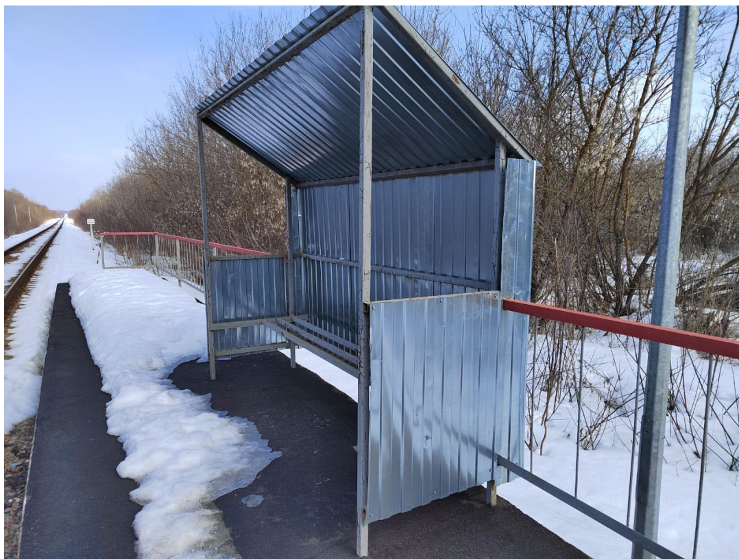
Т.ф. 7. Вид с юго-запада на ст. Rogozinskaya
