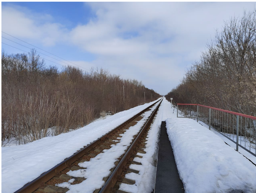
Т.ф. 6. Вид с юга на железнодорожные пути с платформы в сторону ст. Долгая
