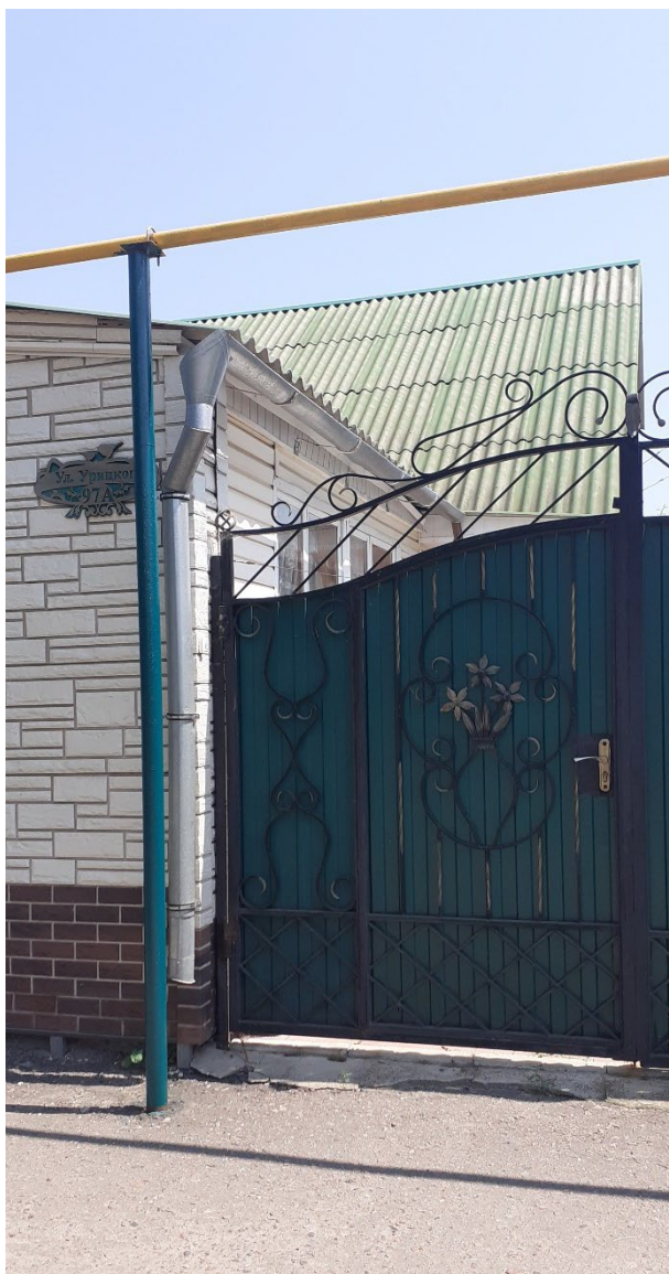
Фотография № 6. Фрагмент фасада.
