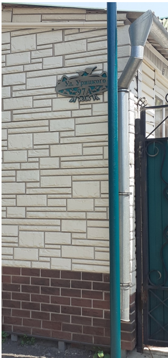
Фотография № 7. Фрагмент фасада.
