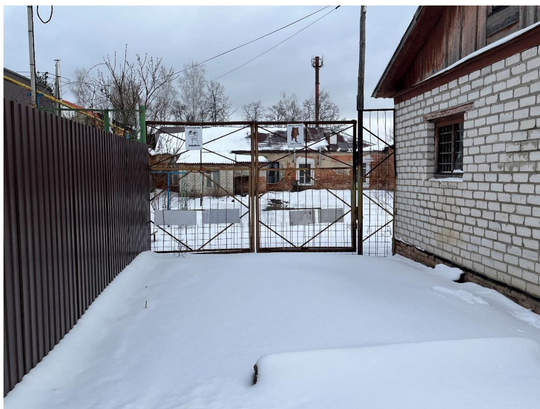
Фотография № 8. Вид с юго-запада на Объект.
