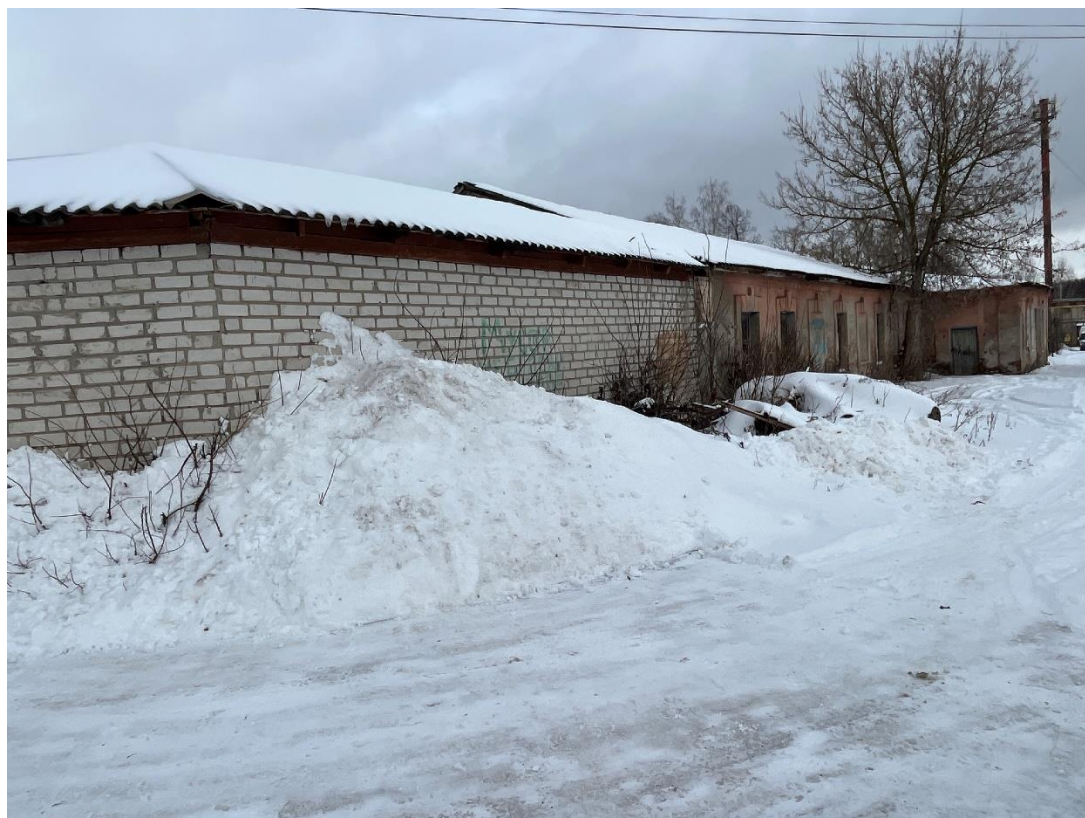
Фотография № 6. Вид с юго-запада на Объект.
