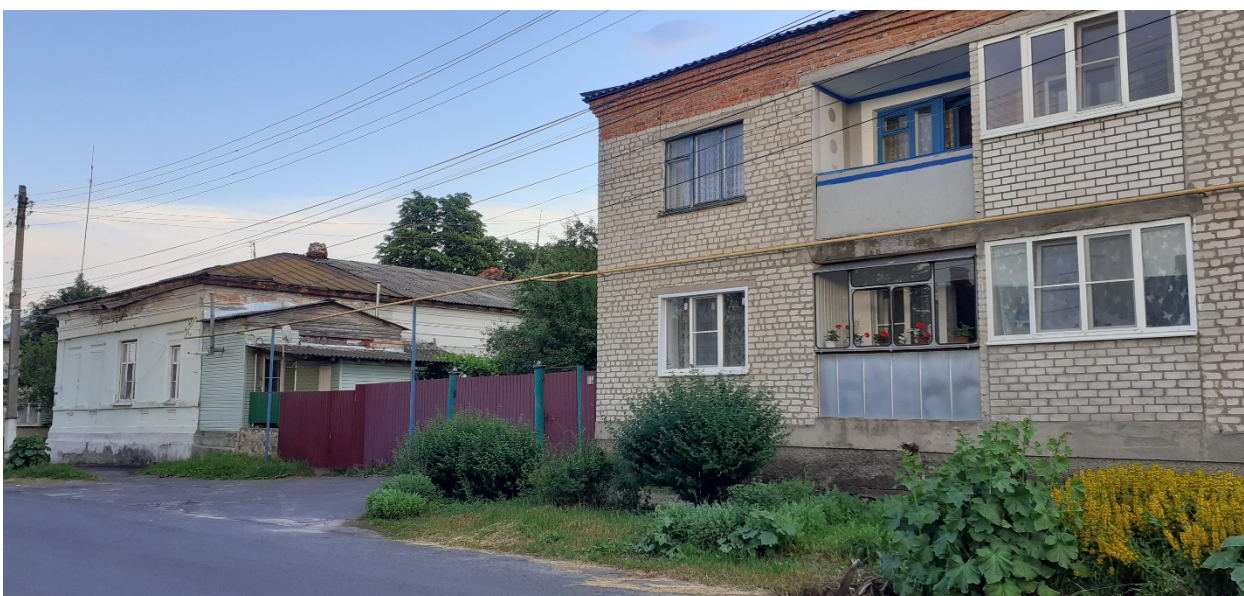
Фотография № 6. Вид с северо-запада на Объект.
