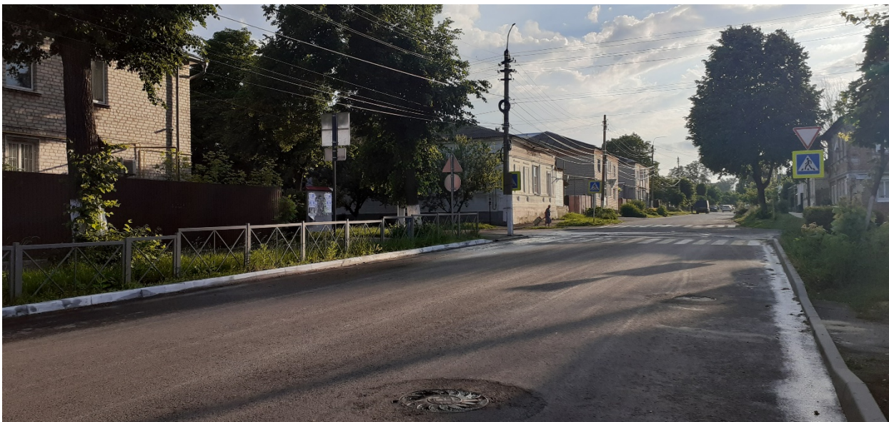
Фотография № 1. Вид с север-востока на Объект.
