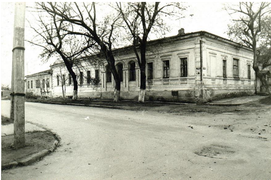
17. Дом по на углу улиц Урицкого и Луначарского, 18/21. Номер дома проставлен с ошибкой, подразумевался дом на углу улиц Урицкого и Луначарского, 78/21. Здание Объекта на фотографии в «Проекте охранных зон г. Рыльска Курской обл.» 1990 года.
