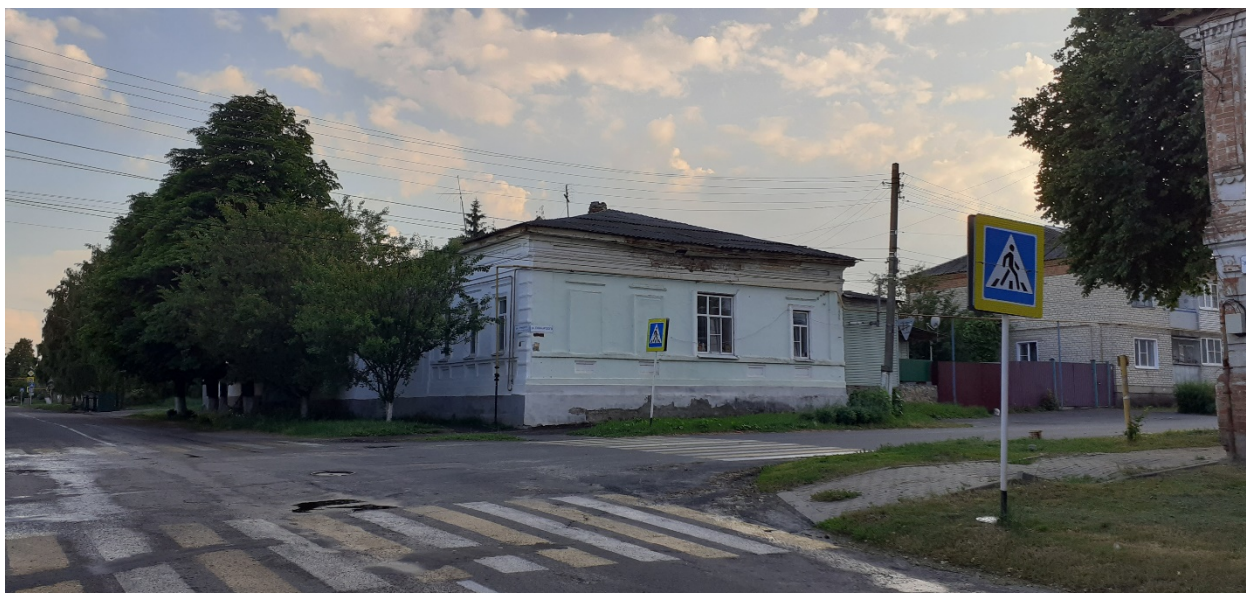
Фотография № 3. Вид с северо-востока на Объект.
