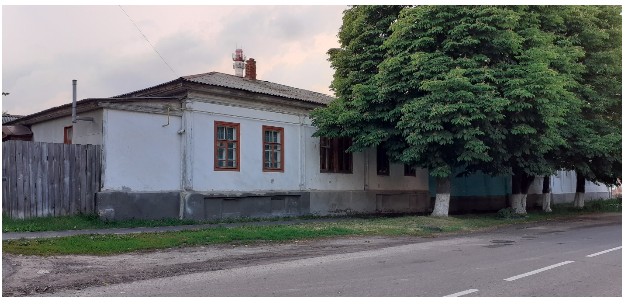
Фотография № 10. Вид с юго-востока на Объект.
