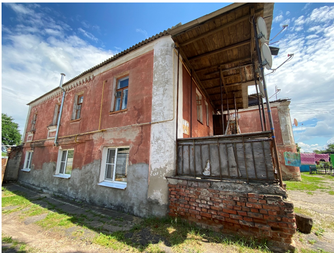
Фотография № 7. Вид с юго-запада на Объект.
