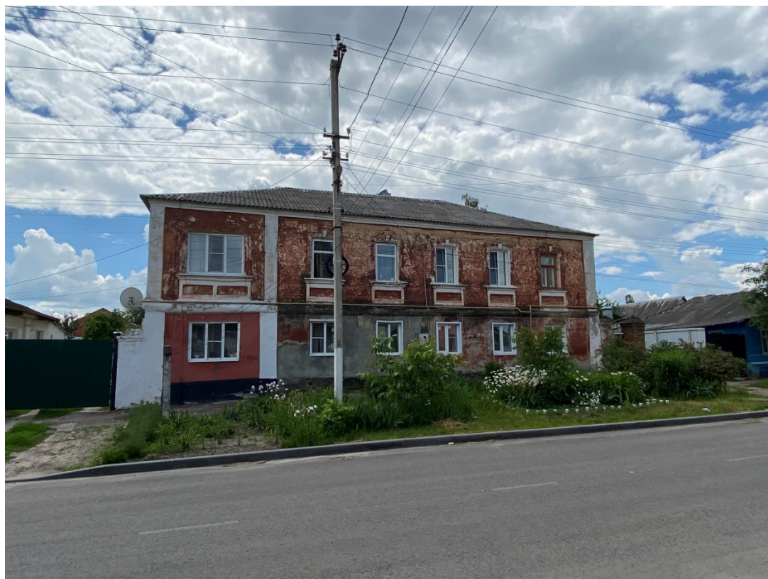
Фотография № 3. Вид с севера на Объект.
