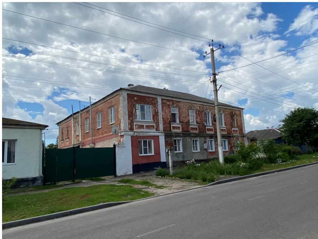
Фотография № 2. Вид с северо-востока на Объект.
