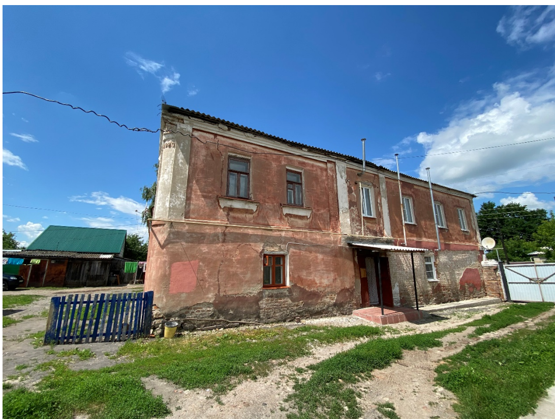
Фотография № 10. Вид с юго-востока на Объект.
