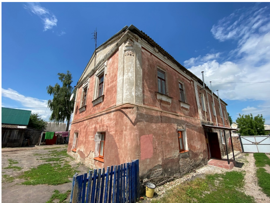
Фотография № 9. Вид с юго-востока на Объект.
