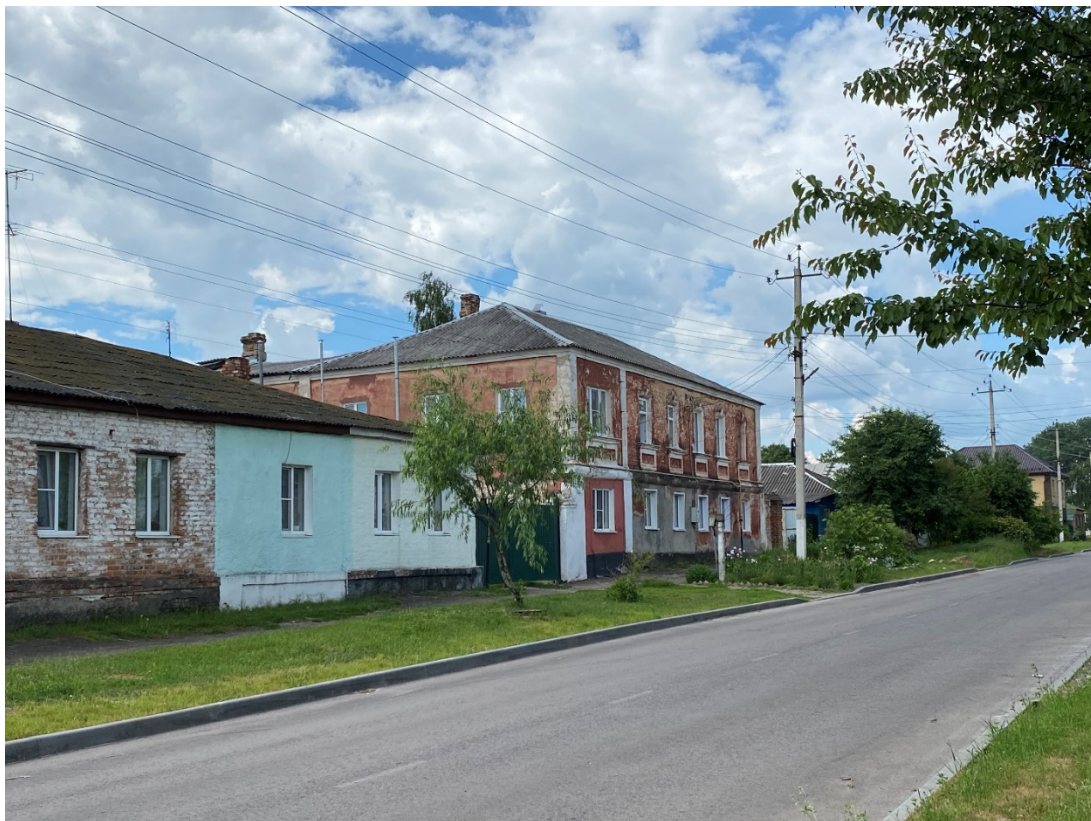
Фотография № 1. Вид с северо-востока на Объект.
