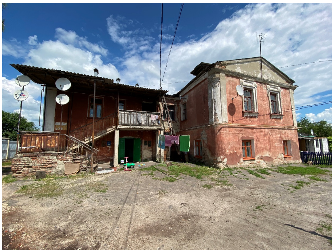
Фотография № 8. Вид с юга на Объект.
