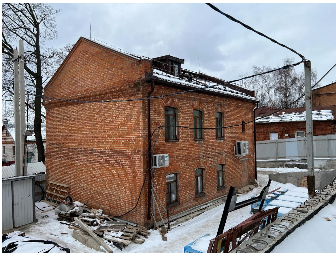
Фотография № 10. Вид с юго-востока на Объект.
