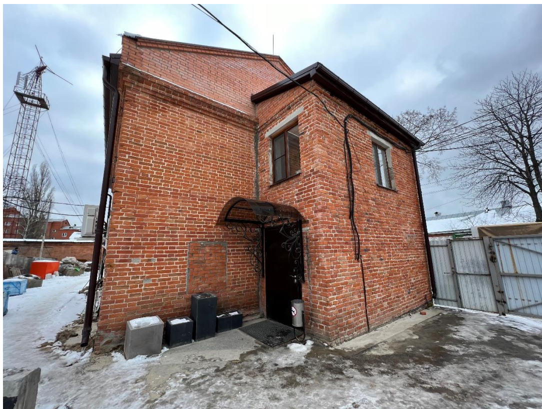
Фотография № 7. Вид с северо-востока на Объект.
