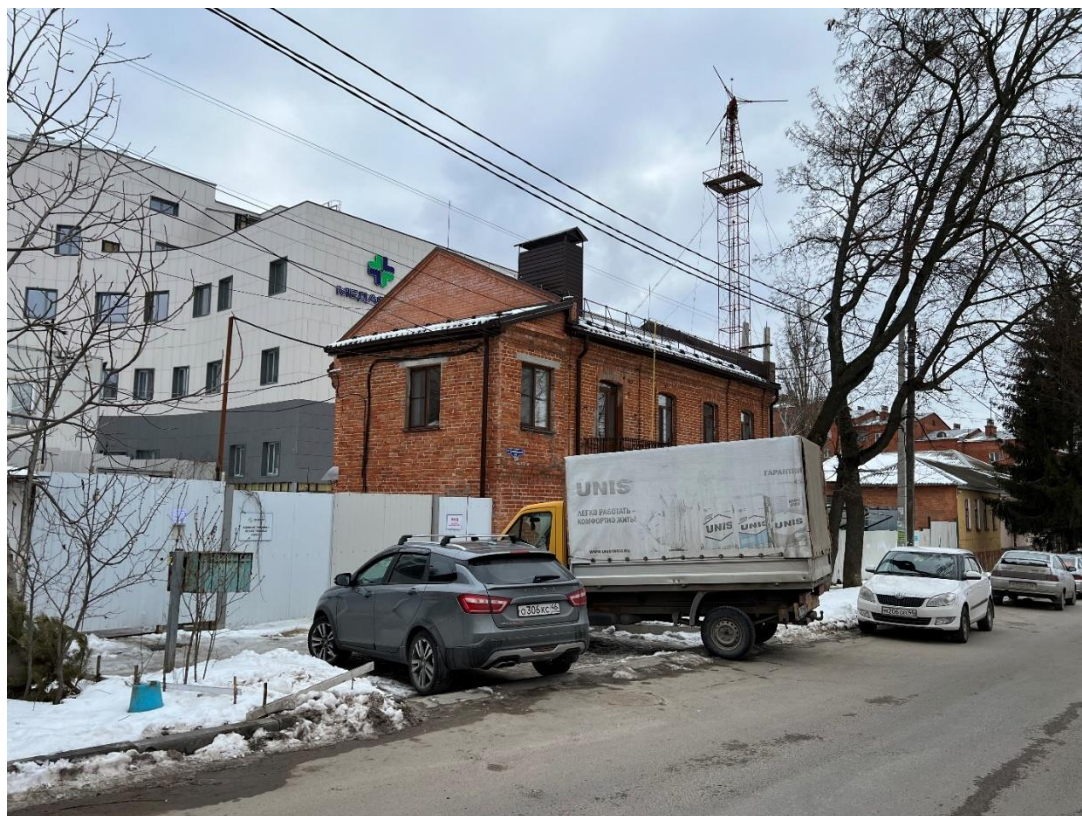
Фотография № 11. Вид с северо-запада на Объект.
