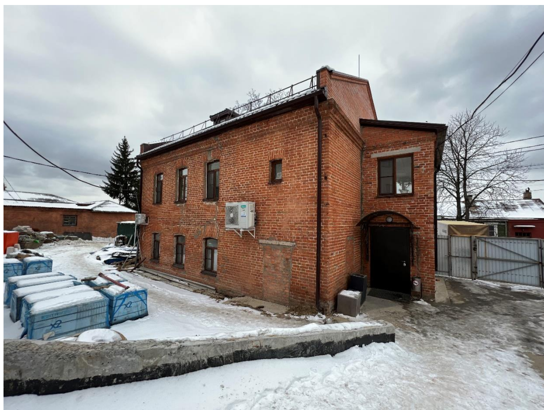
Фотография № 8. Вид с северо-востока на Объект.
