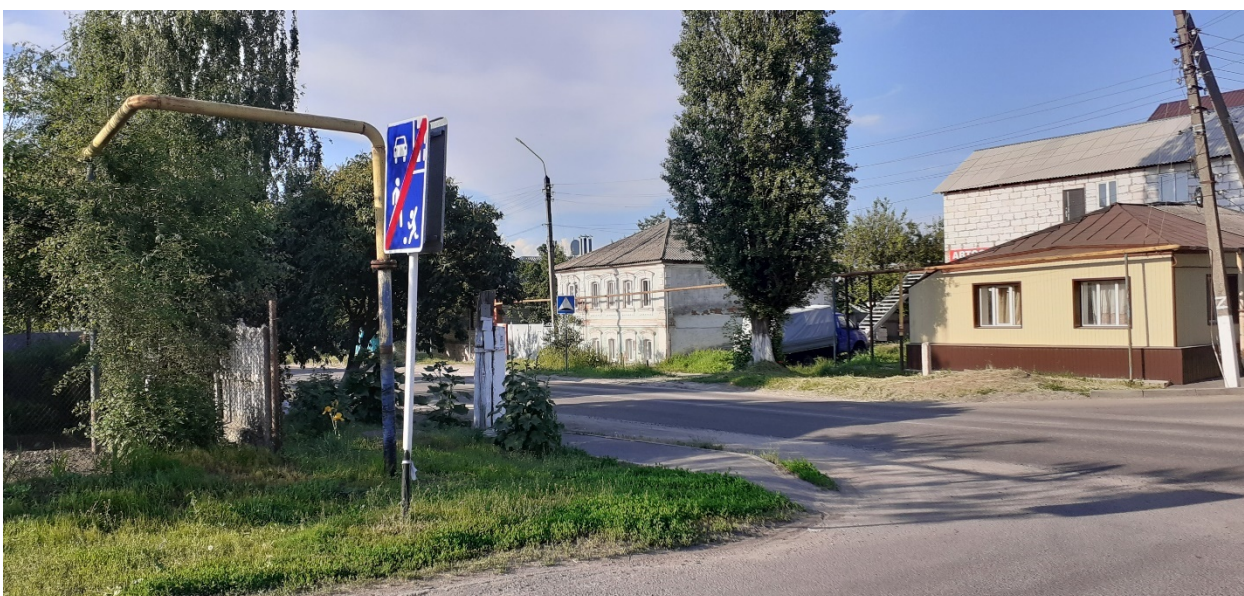
Фотография № 2. Вид с юго-запада на Объект.
