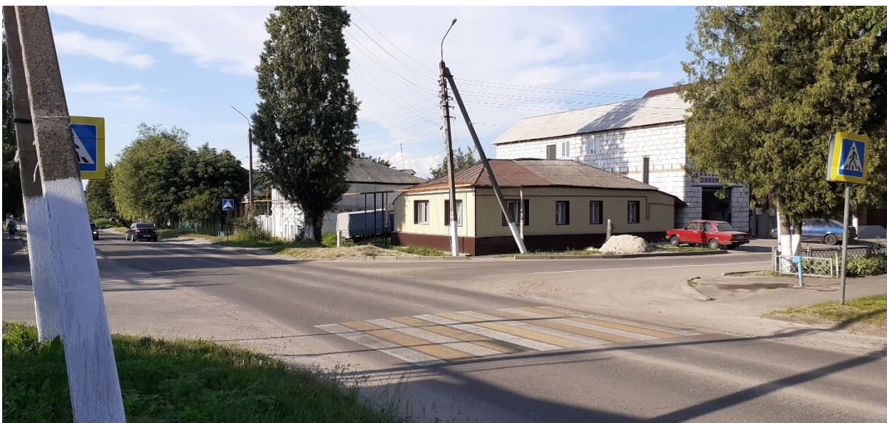
Фотография № 1. Вид с юго-запада на Объект.
