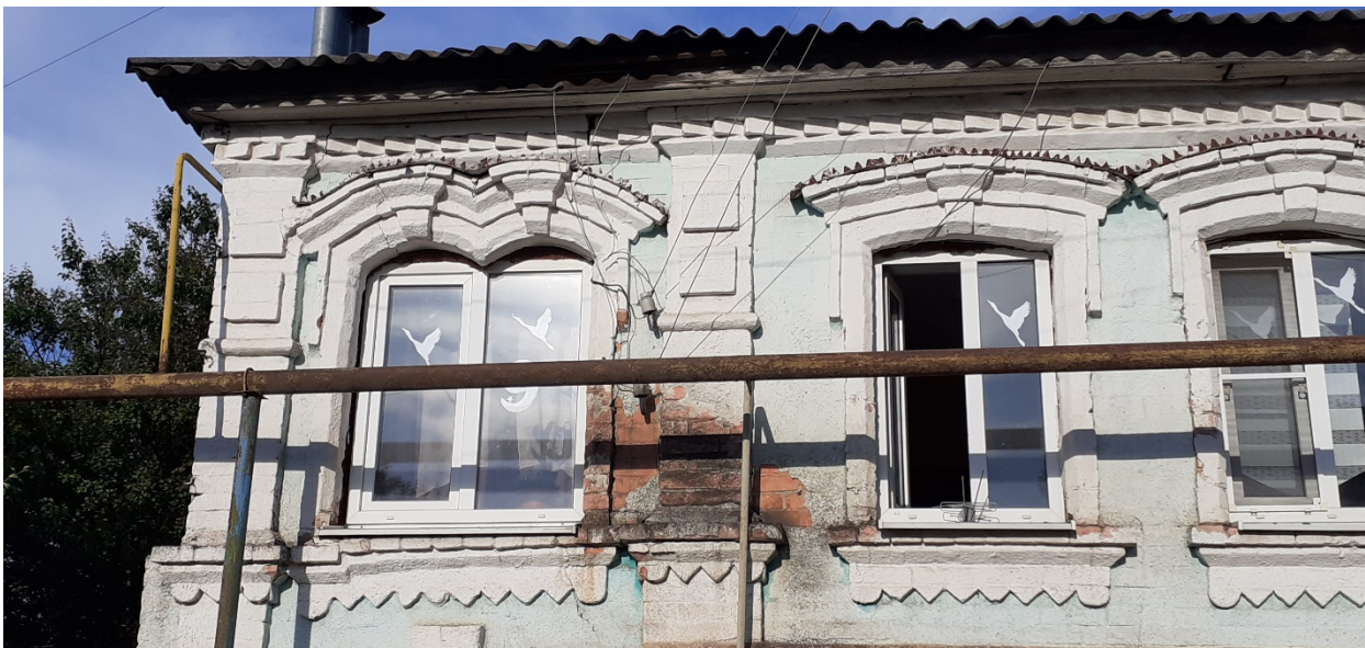
Фотография № 9. Вид с запада на Объект. Центральный фасад. Фрагмент.
