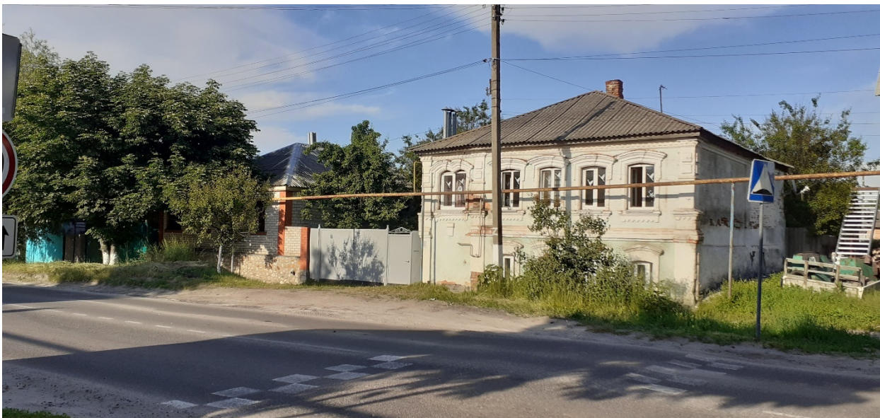
Фотография № 3. Вид с юго-запада на Объект.
