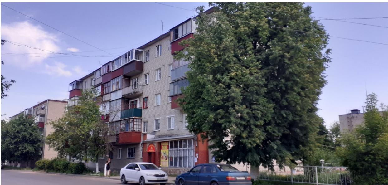
Фотография № 4. Вид с юго-запада на Объект.
