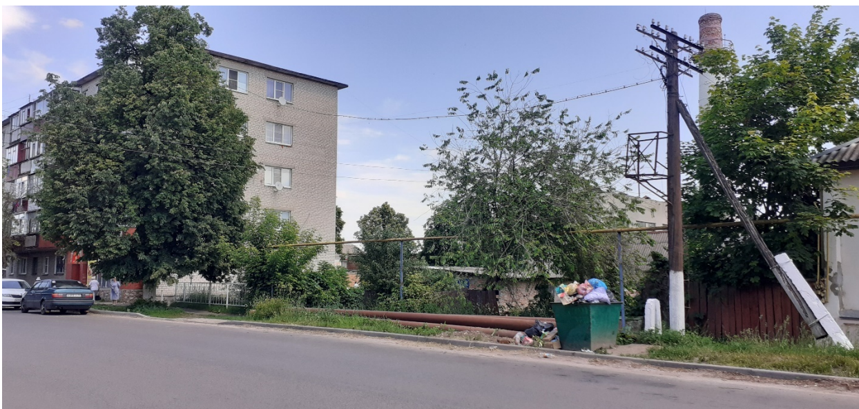
Фотография № 1. Вид с юго-запада на Объект.
