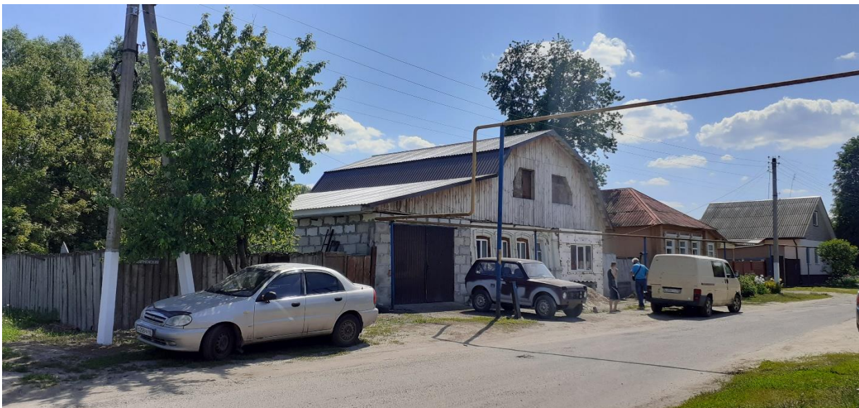
Фотография № 3. Вид с севера на Объект.
