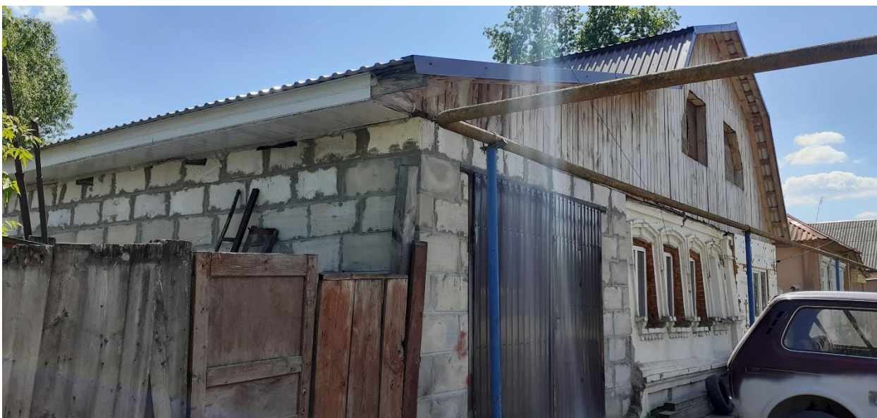
Фотография № 7. Вид с северо-востока на Объект.
