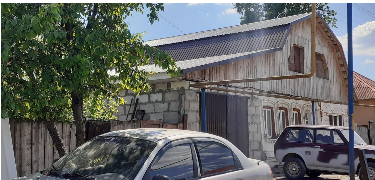
Фотография № 6. Вид с северо-востока на Объект.
