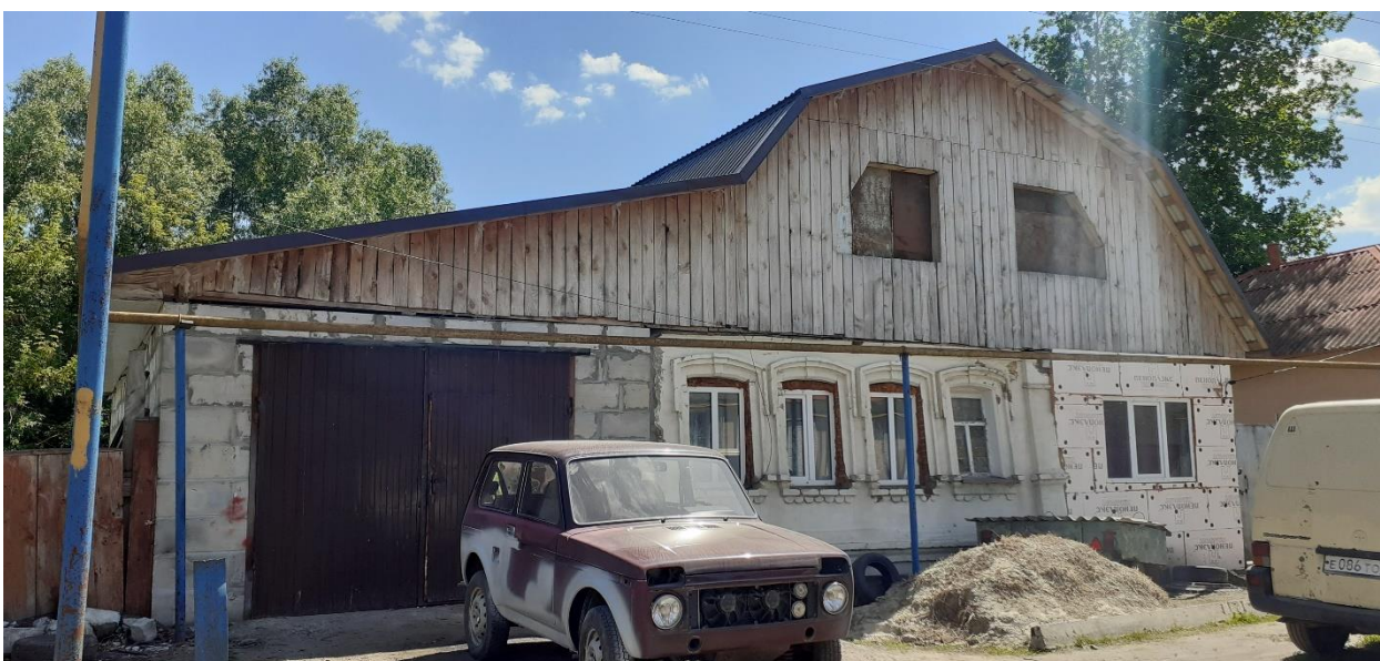
Фотография № 8. Вид с севера на Объект.
