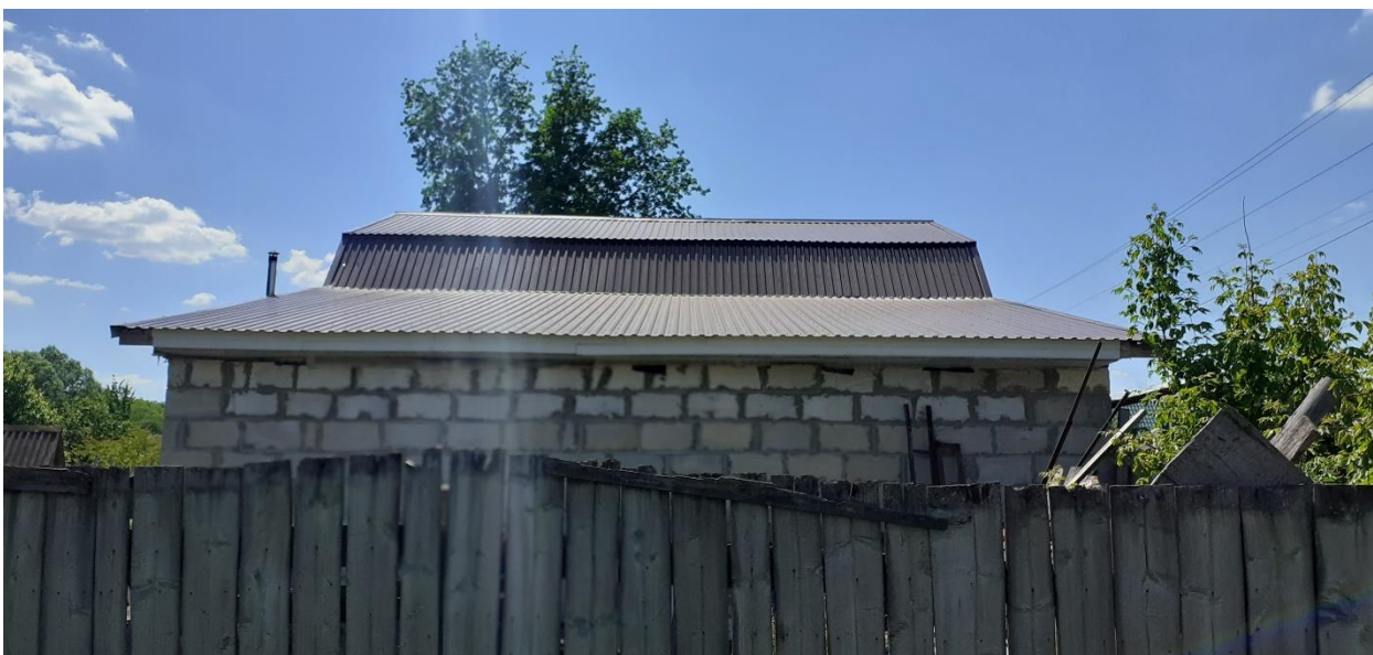
Фотография № 4. Вид с северо-востока на Объект.
