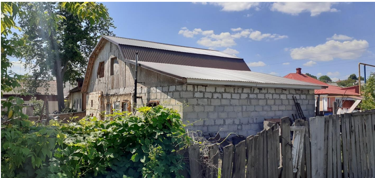
Фотография № 5. Вид с юго-востока на Объект.
