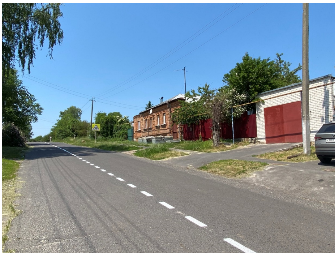
Фотография № 2. Вид с юго-востока на Объект.
