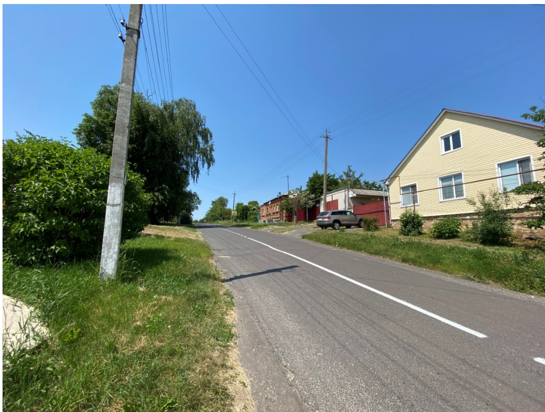
Фотография № 1. Вид с юго-востока на Объект.
