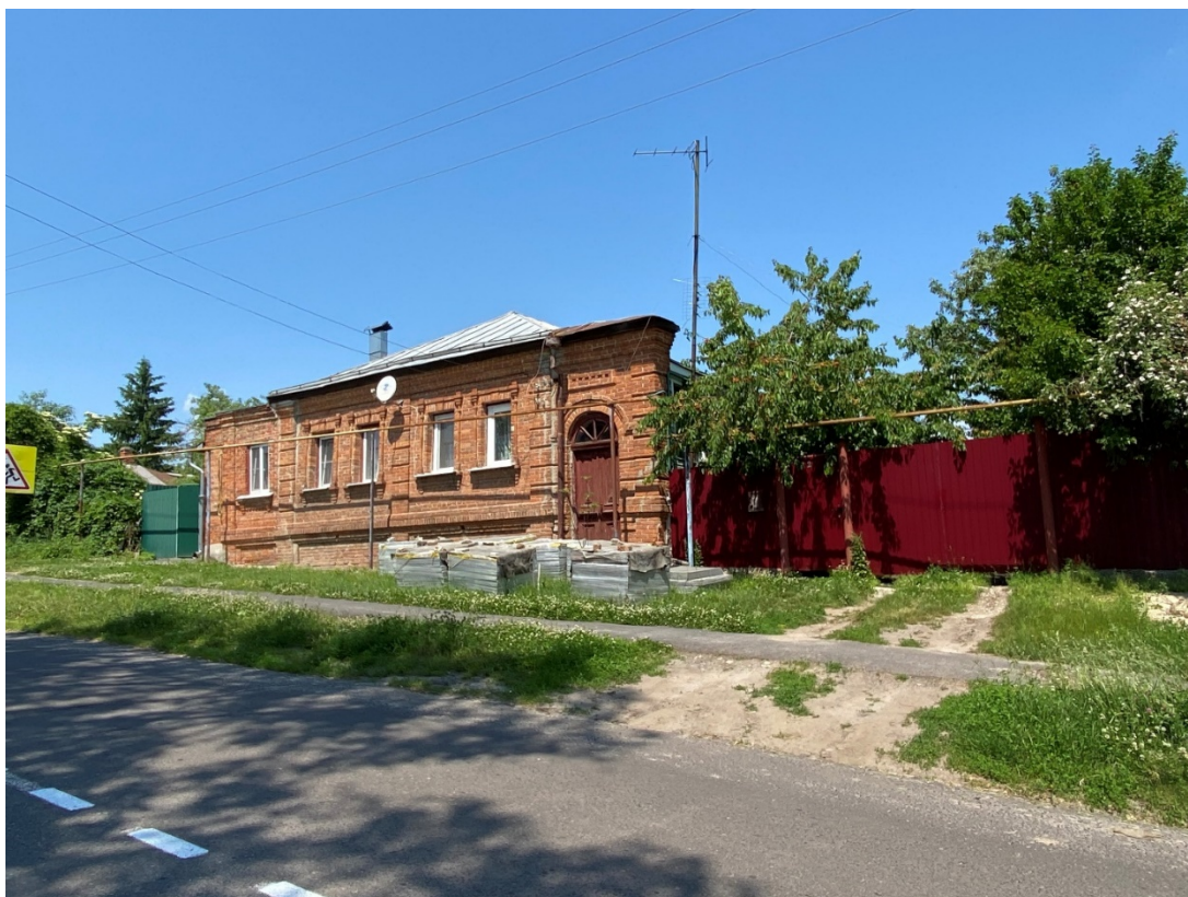
Фотография № 5. Вид с юго-востока на Объект.
