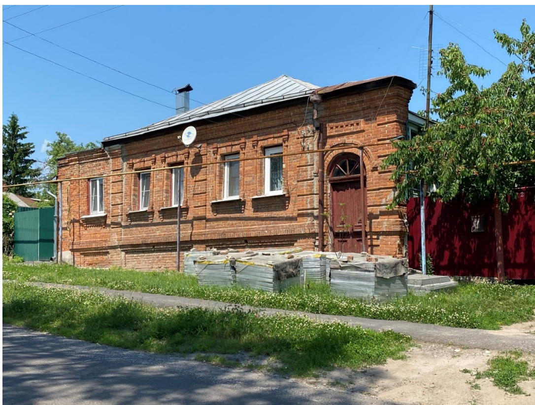
Фотография № 6. Вид с юго-востока на Объект.
