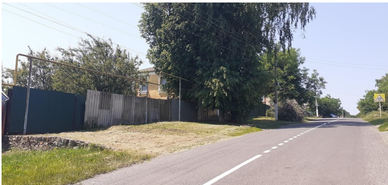
Фотография № 1. Вид с северо-востока на Объект.
