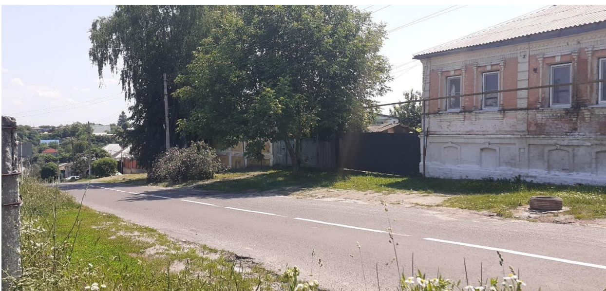
Фотография № 8. Вид с северо-запада на Объект.
