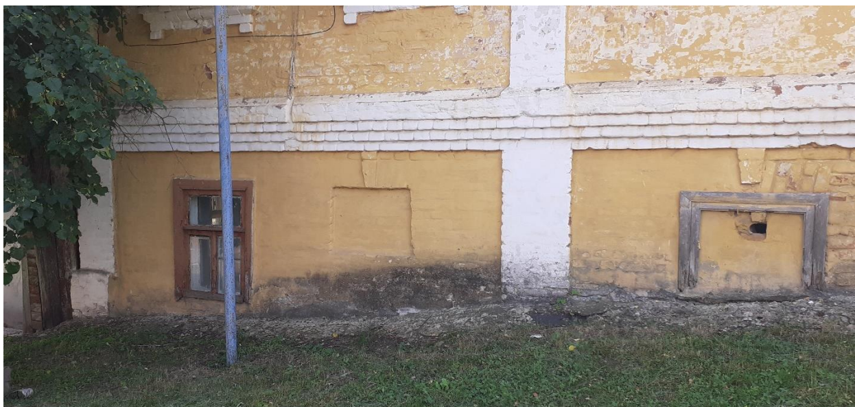
Фотография № 10. Вид с севера на Объект. Центральный (северный) фасад. Фрагмент.
