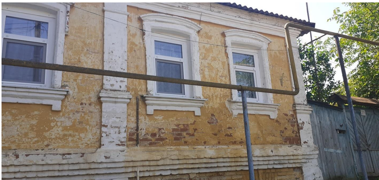
Фотография № 9. Вид с севера на Объект. Центральный (северный) фасад. Фрагмент.
