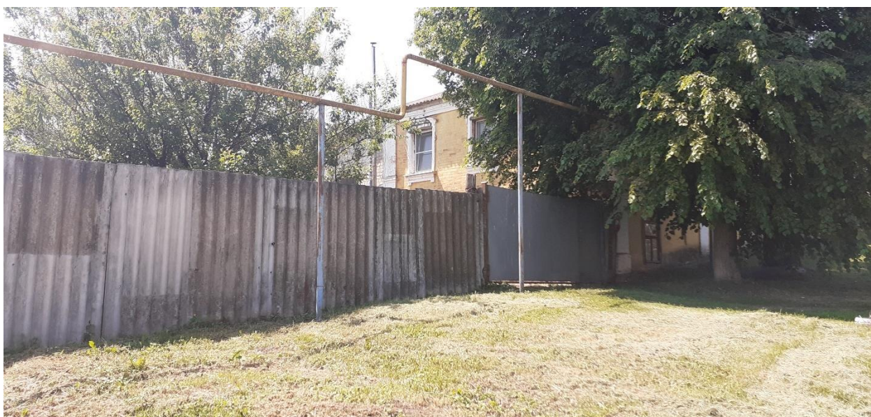
Фотография № 2. Вид с северо-востока на Объект.
