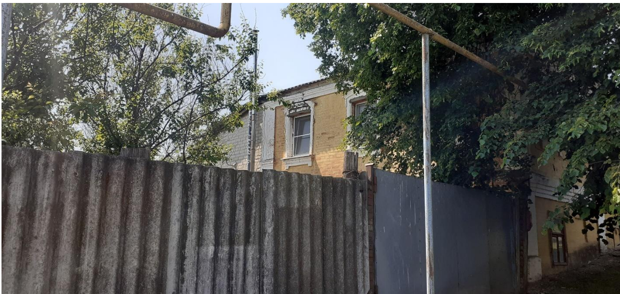
Фотография № 3. Вид с северо-востока на Объект.
