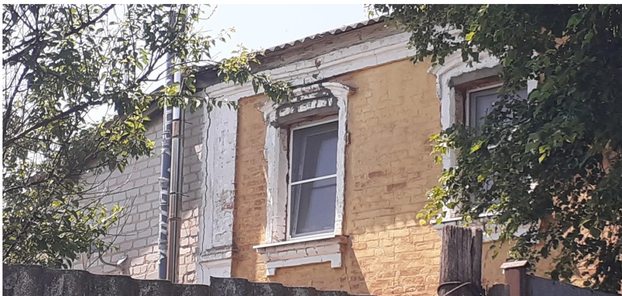
Фотография № 11. Вид с запада на Объект. Западный фасад. Фрагмент.
