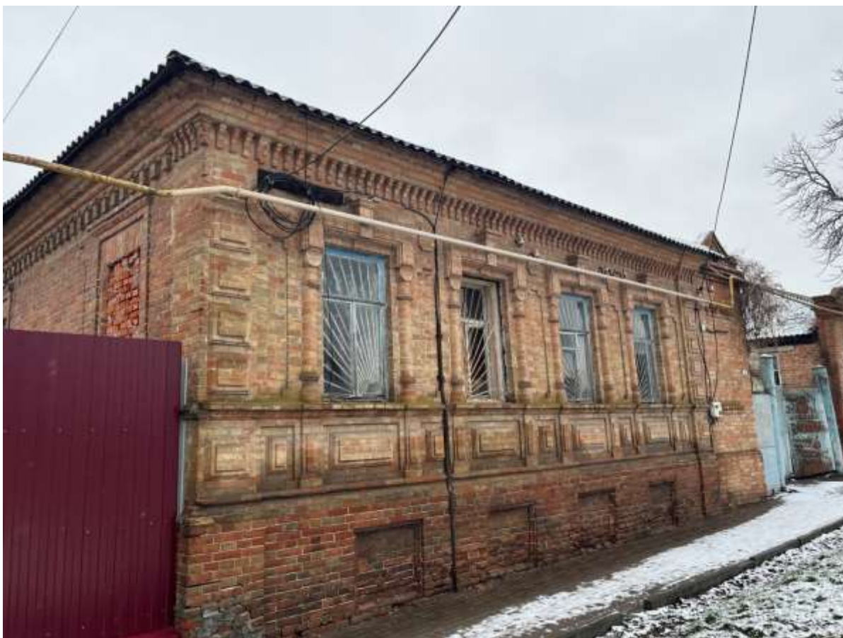
Т.ф. 3. Отдельные элементы декора главного фасада Объекта со стороны ул. Комсомольской.
