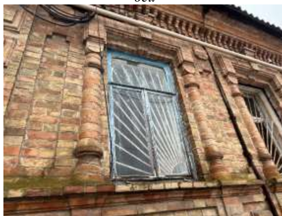
Оформление оконных проемов и простенков
