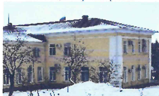
композиция дворового фасада
