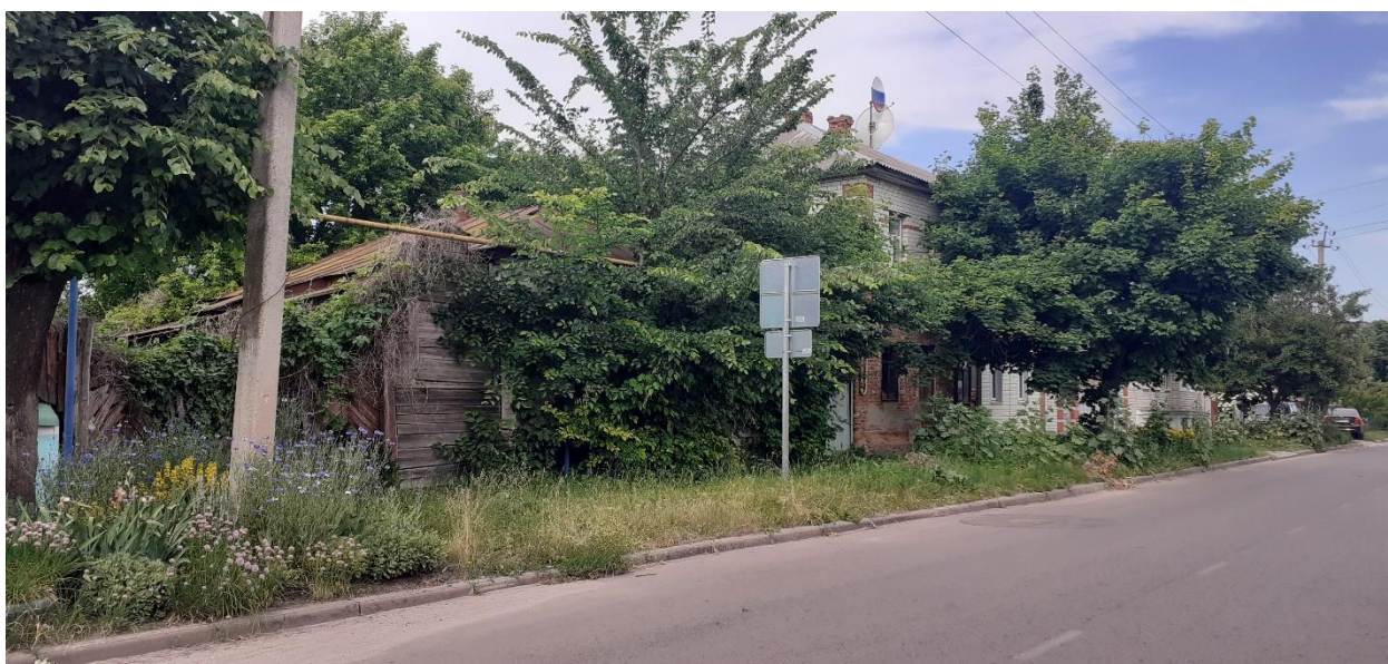
Фотография № 2. Вид с юго-запада на Объект.
