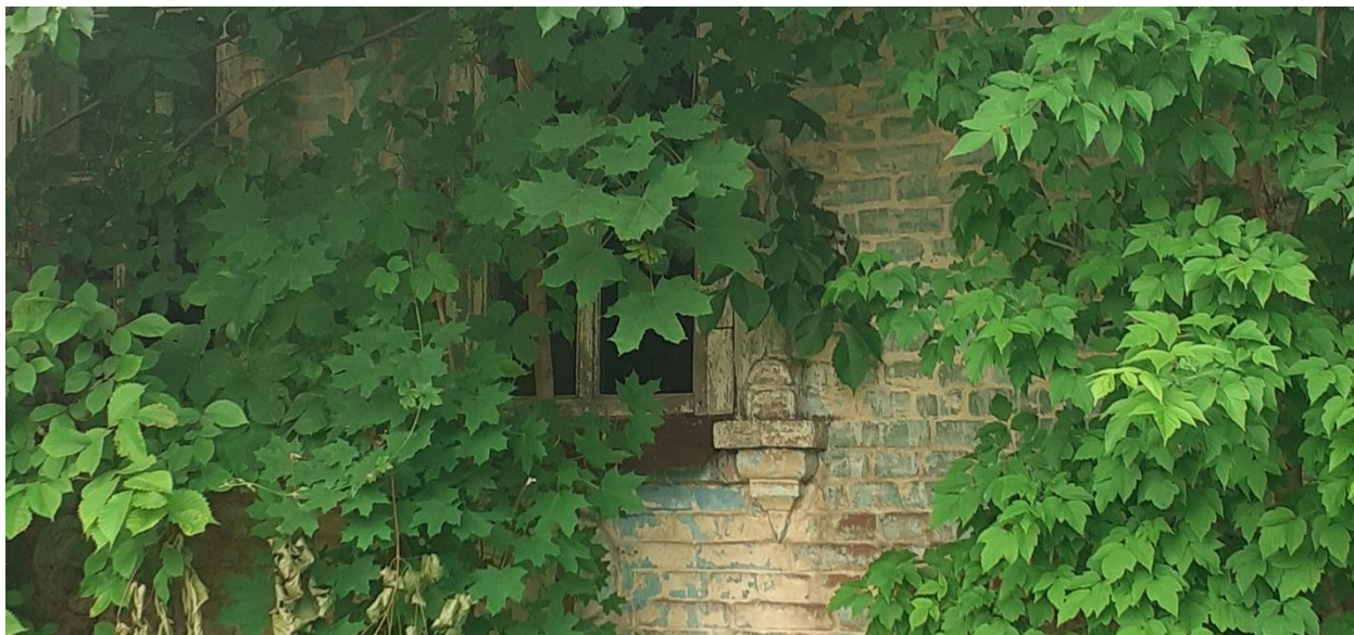
Фотография № 9. Вид с юга на Объект. Центральный фасад. Фрагмент.
