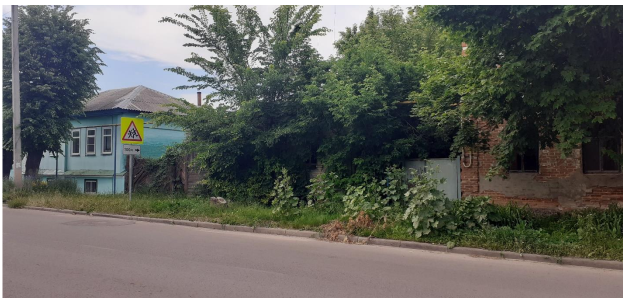
Фотография № 6. Вид с юго-востока на Объект.
