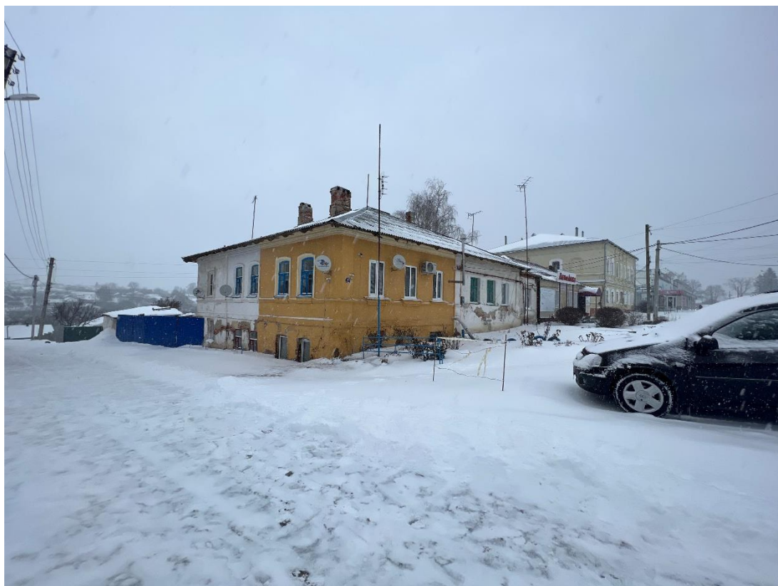
Фотография № 5. Вид с юго-запада на Объект.
