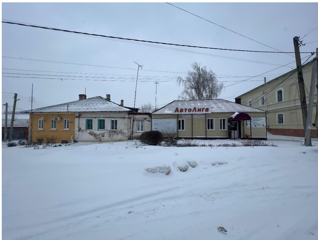
Фотография № 3. Вид с юго-востока на Объект.
