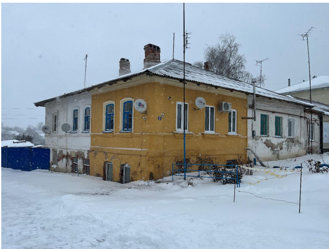
Фотография № 6. Вид с юго-запада на Объект.
