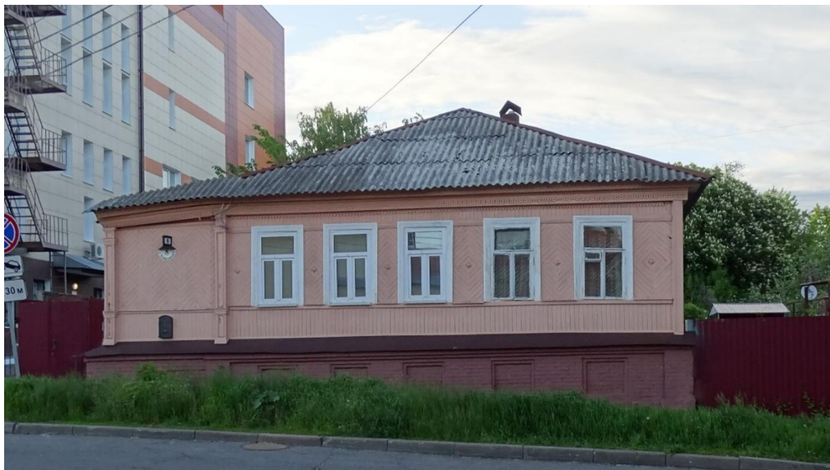
Уличный фасад Объекта
