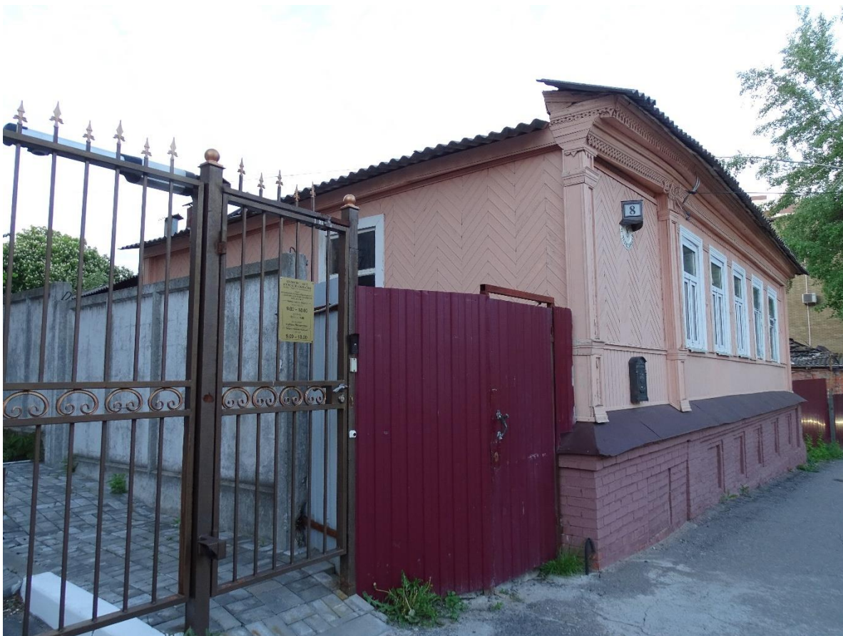
Фото 7. Фрагмент западного и южного фасадов Объекта
