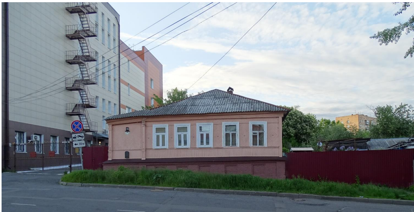
Фото 2. Южный уличный фасад Объекта
