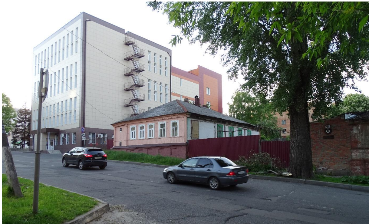
Фото 1. Общий вид Объекта
