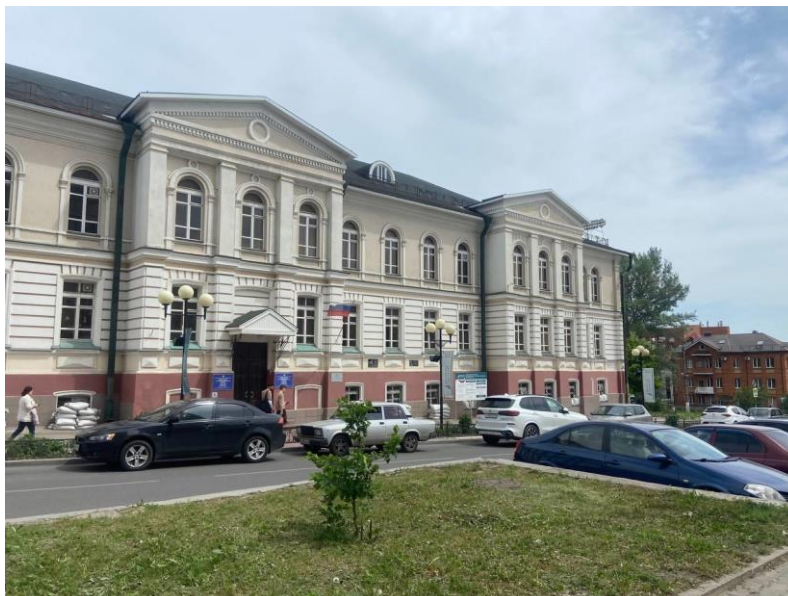
Фрагмент главного фасада объекта по ул. Ломоносова. Фото - сентябрь 2025 г.
