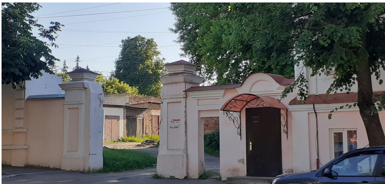
Фотография № 15. Общий вид с северо-востока на ограду с калиткой и воротами.
