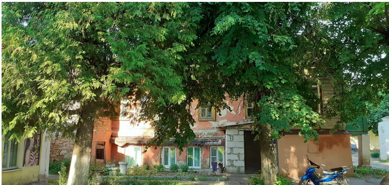
Фотография № 6. Дворовый (западный) фасад Объекта «Дом усадебный». Общий вид.
