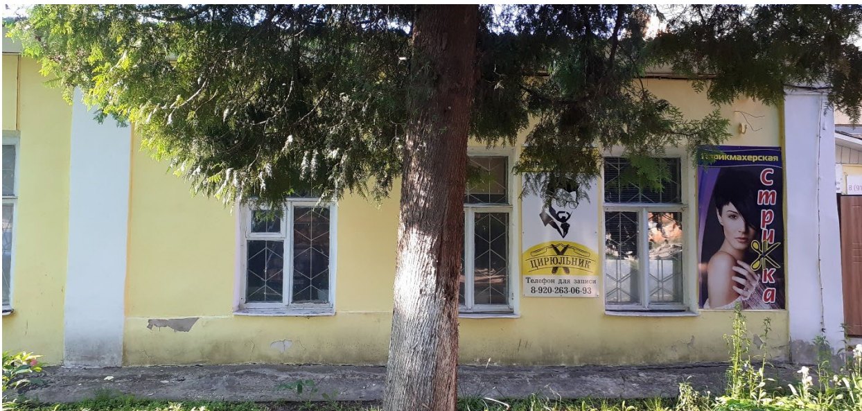
Фотография № 12. Фрагмент Объекта «Флигель»
