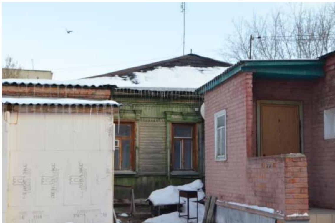
Т.ф. №8. Выявленный объект культурного наследия «Дом жилой», кон. XIX в. (Курская область, г. Курск, ул. Халтурина, д. 18а). Южный фасад. Фрагмент.
