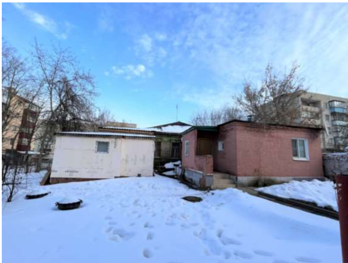
Т.ф. №7. Выявленный объект культурного наследия «Дом жилой», кон. XIX в. (Курская область, г. Курск, ул. Халтурина, д. 18а). Южный фасад.
