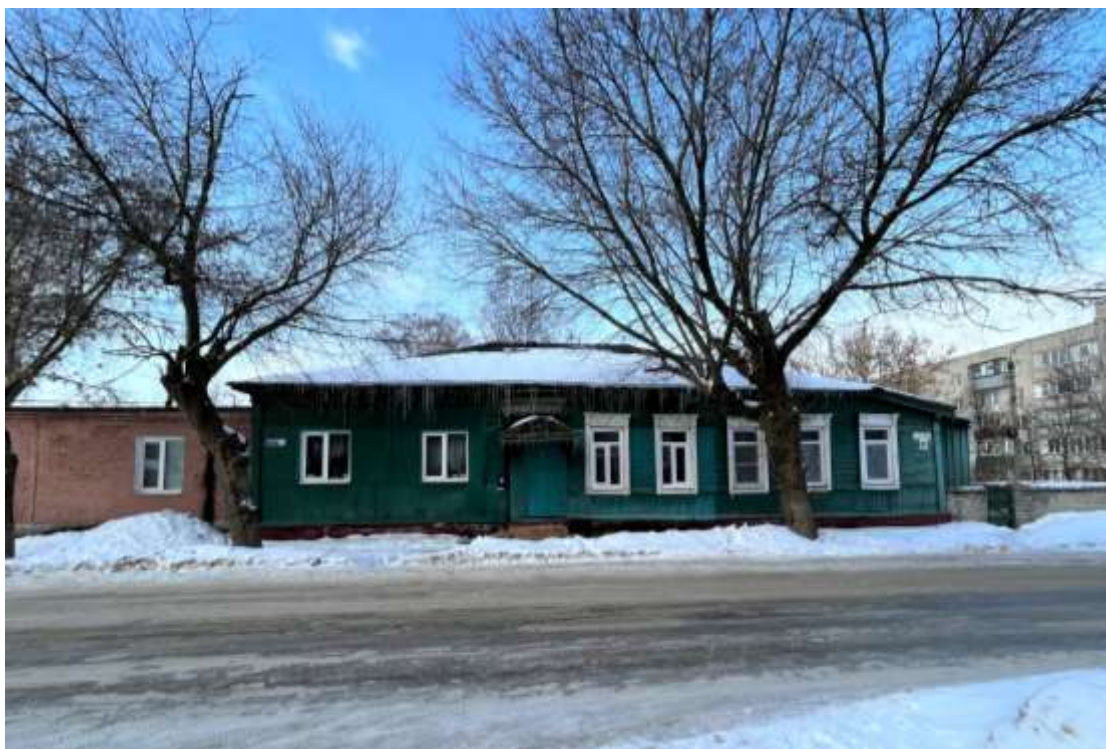
Т.ф. №3. Выявленный объект культурного наследия «Дом жилой», кон. XIX в. (Курская область, г. Курск, ул. Халтурина, д. 18а). Восточный фасад.
