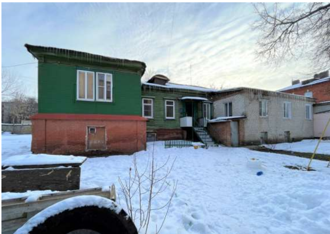
Т.ф. №5. Выявленный объект культурного наследия «Дом жилой», кон. XIX в. (Курская область, г. Курск, ул. Халтурина, д. 18а). Западный фасад.
