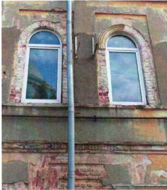
Перемычки – кирпичные арочные в уровне 2 этажа, оштукатурены;
