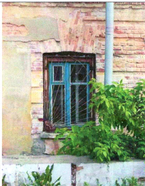
- перемычки – кирпичные клинчатые в уровне 1, оштукатурены;
