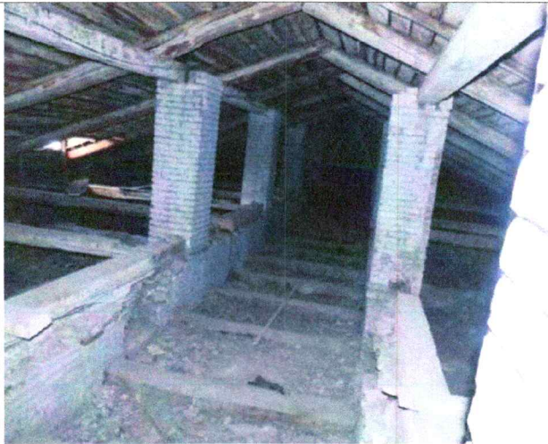
стропильные конструкции – деревянные, покрытие кровли – тонколистовая сталь;
