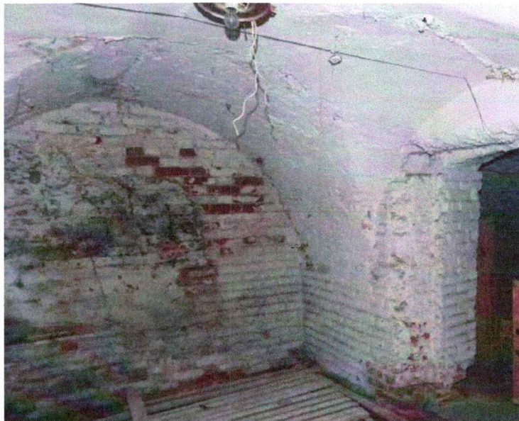
- своды в подвале – кирпичные, выполнены на известковом растворе, оштукатурены, побелены; - перемычки – кирпичные клинчатые, оштукатурены;
