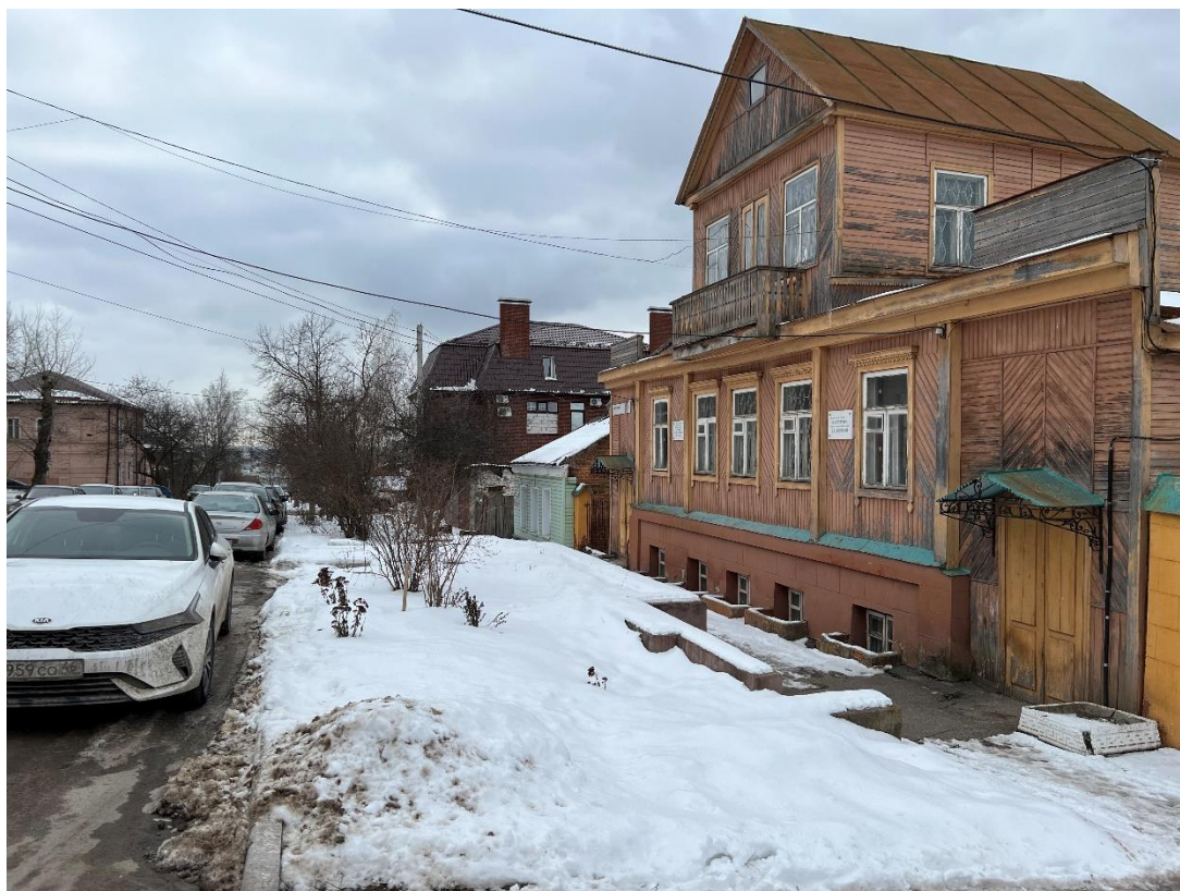
Фотография № 11. Вид с северо-востока на Объект.
