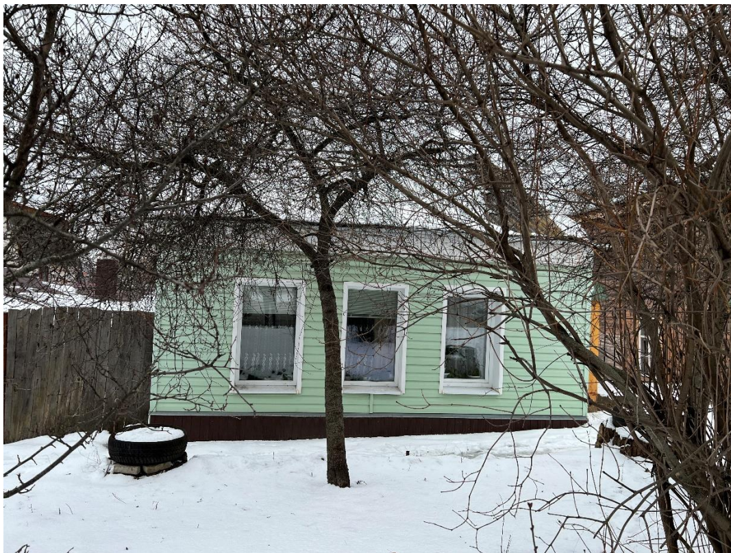
Фотография № 7. Вид с востока на Объект.
