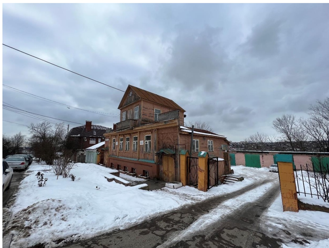
Фотография № 12. Вид с северо-востока на Объект.
