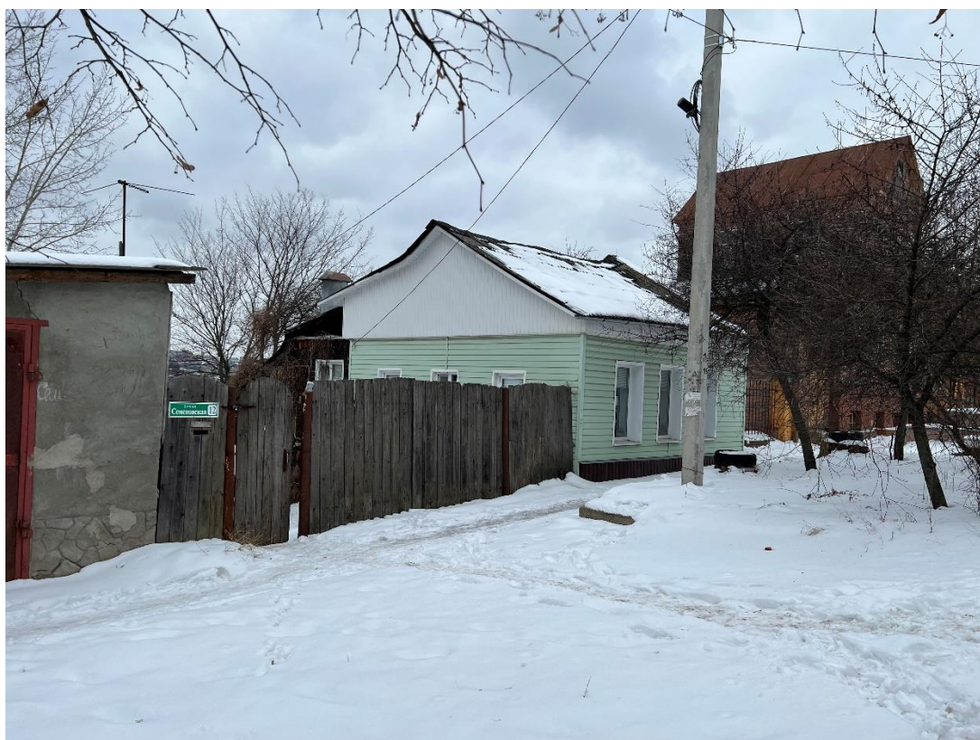
Фотография № 4. Вид с юго-востока на Объект.
