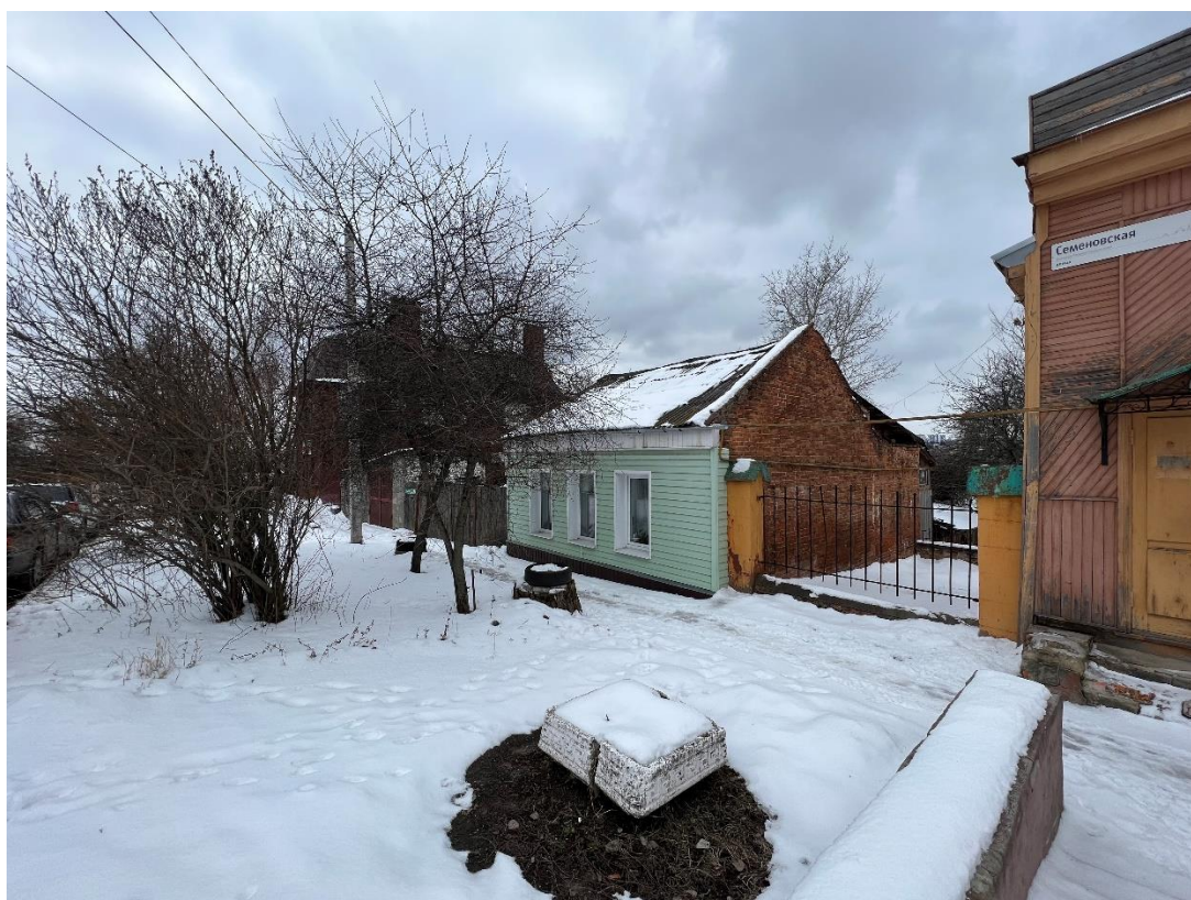
Фотография № 10. Вид с северо-востока на Объект.
