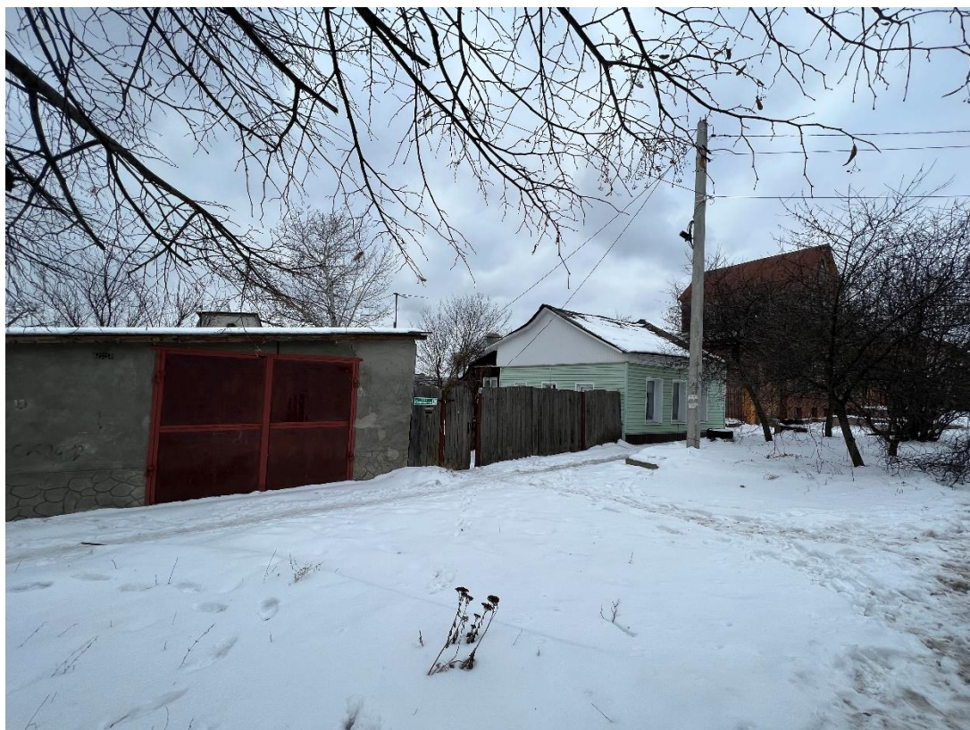
Фотография № 3. Вид с юго-востока на Объект.
