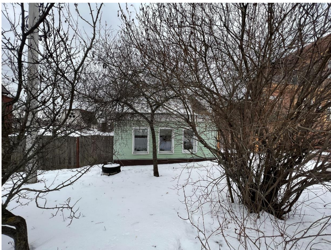
Фотография № 6. Вид с востока на Объект.
