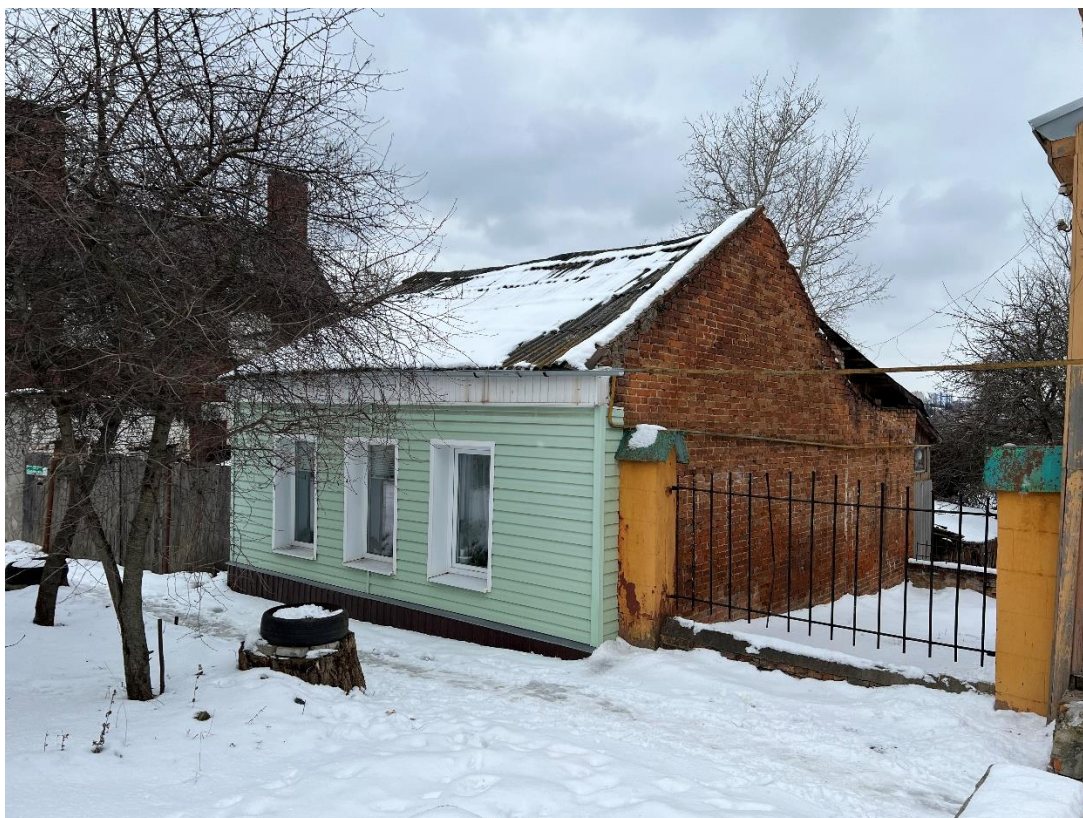
Фотография № 9. Вид с северо-востока на Объект.
