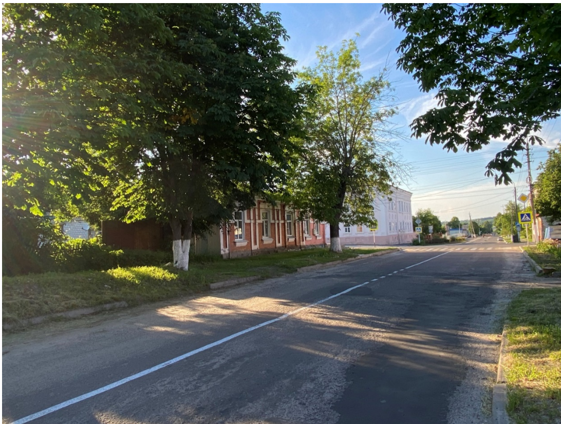
Фотография № 11. Вид с юго-востока на Объект.
