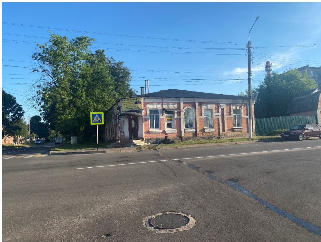
Фотография № 5. Вид с северо-востока на Объект.
