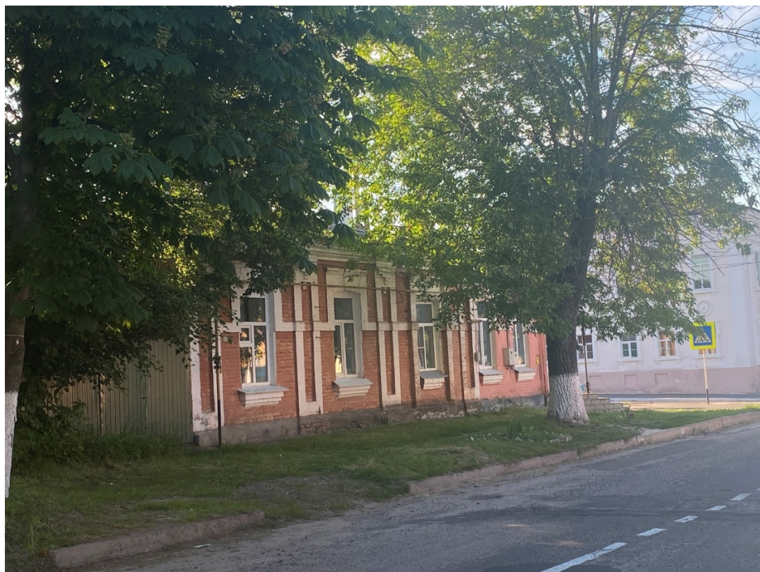
Фотография № 10. Вид с юго-востока на Объект.
