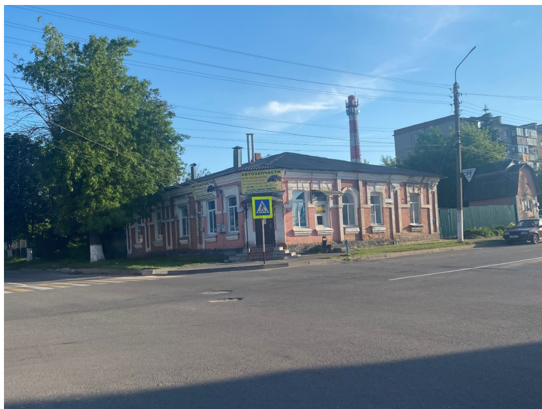
Фотография № 6. Вид с северо-востока на Объект.
