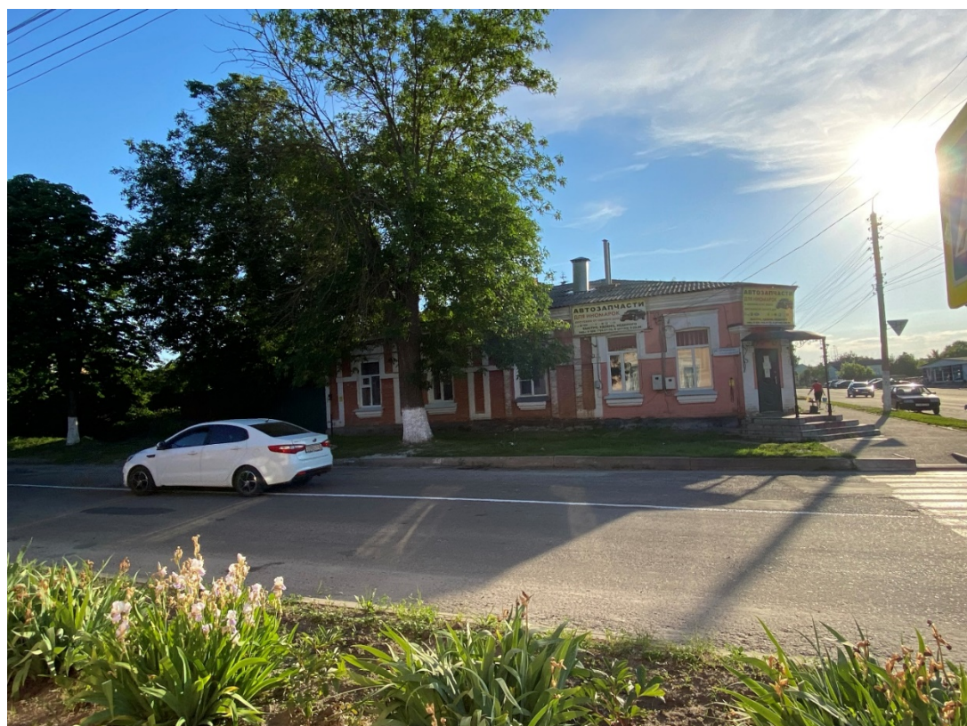
Фотография № 8. Вид с востока на Объект.
