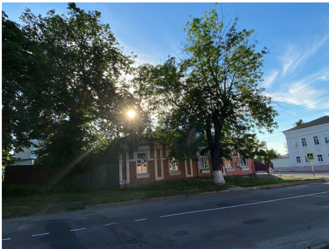
Фотография № 9. Вид с юго-востока на Объект.
