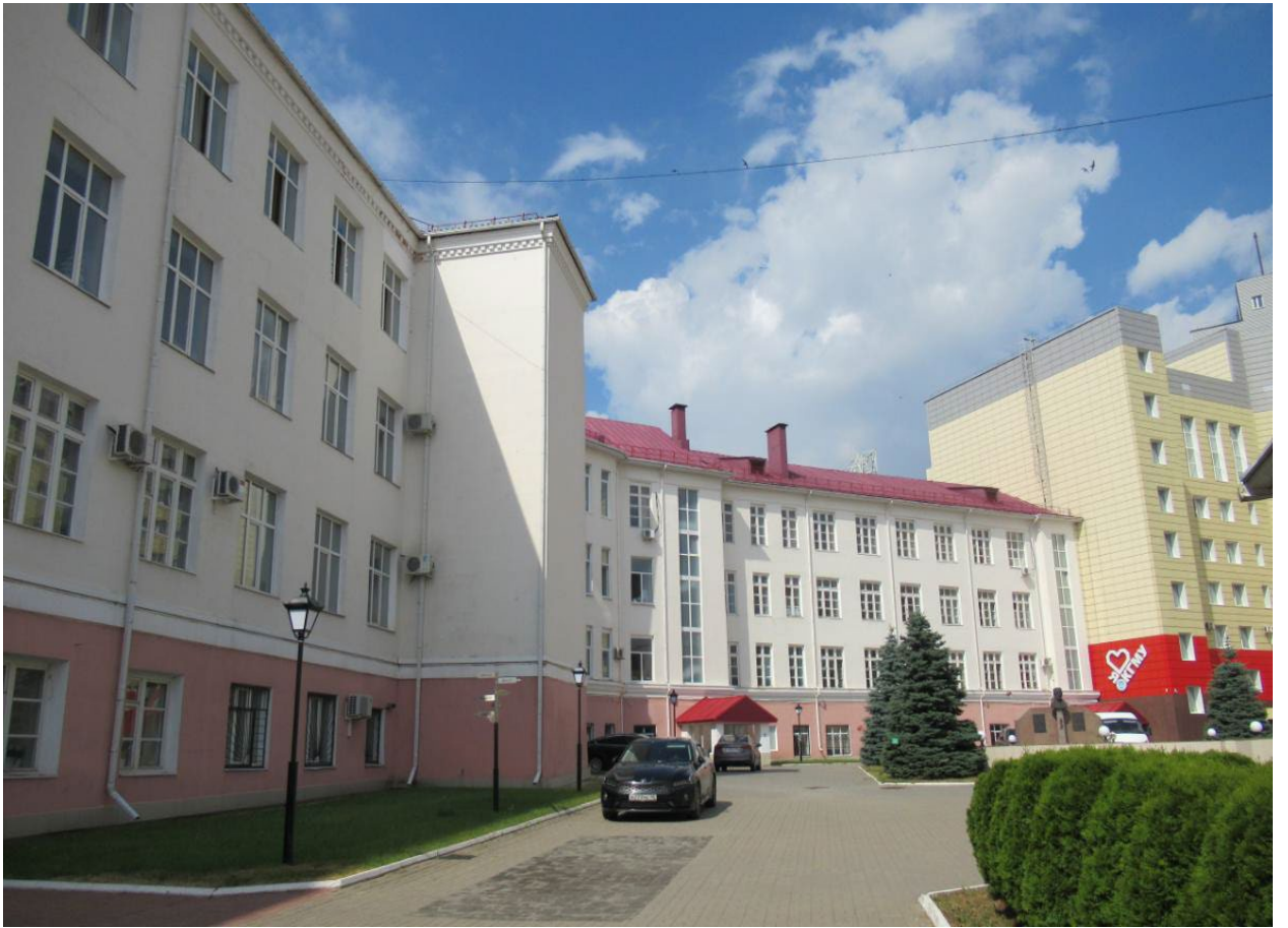
Фото 3. Общий вид дворового фасада Объекта.
