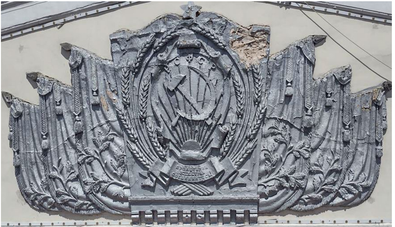
Фото 5. Декоративный элемент на главном фасаде здания.
