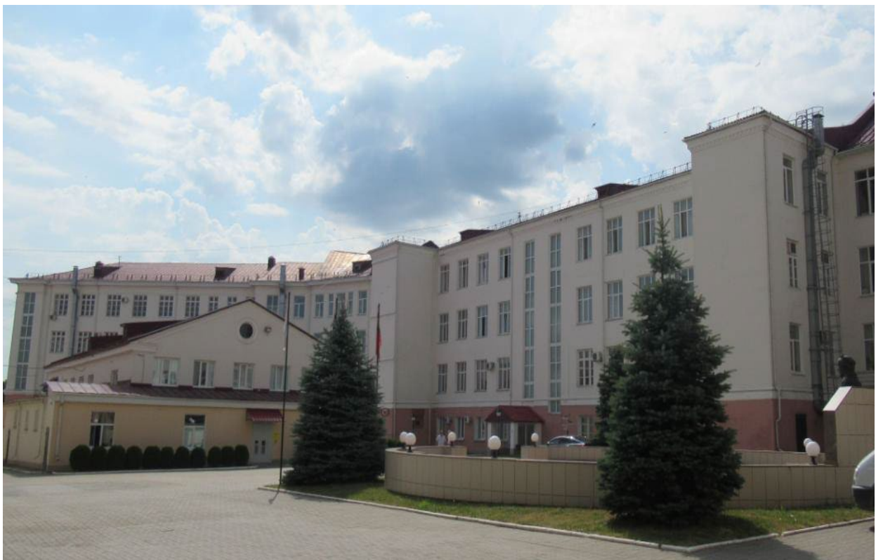
Фото 4. Общий вид дворового фасада Объекта.
