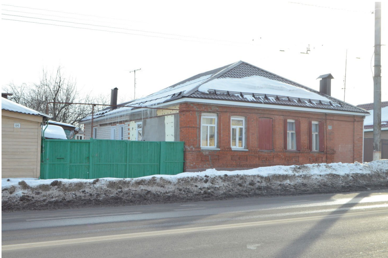
Т.ф. 3. Вид с севера со стороны ул. Красной Армии на главный и дворовой фасады Объекта
