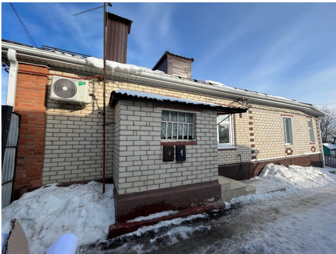
Т.ф. 7. Вид с запада на юго-западный фасад Объекта
