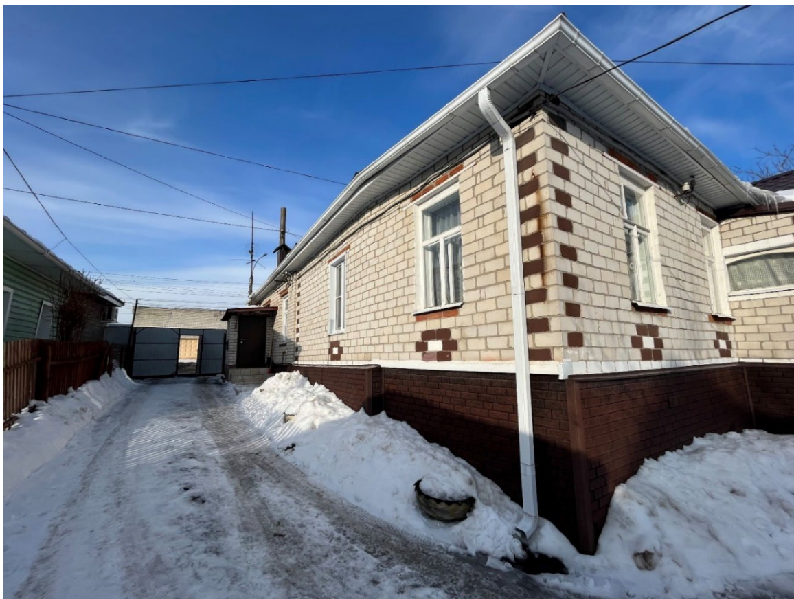
Т.ф. 5. Вид с юга в сторону ул. Красной Армии на угол пересечения юго-западного и юго-восточного фасадов Объекта
