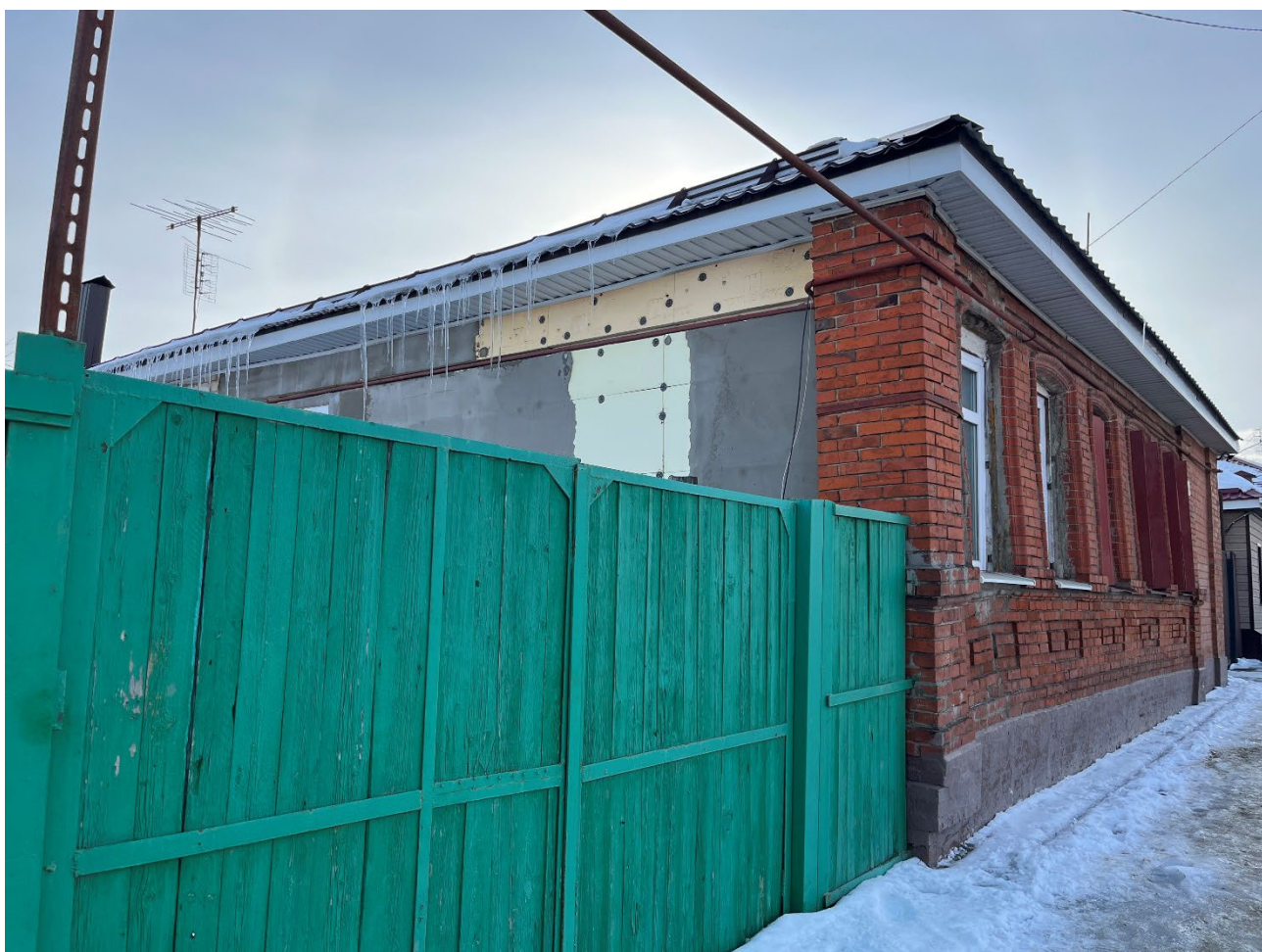
Т.ф. 12. Вид с северо-востока со стороны ул. Красной Армии на угол пересечения главного и бокового фасадов Объекта
