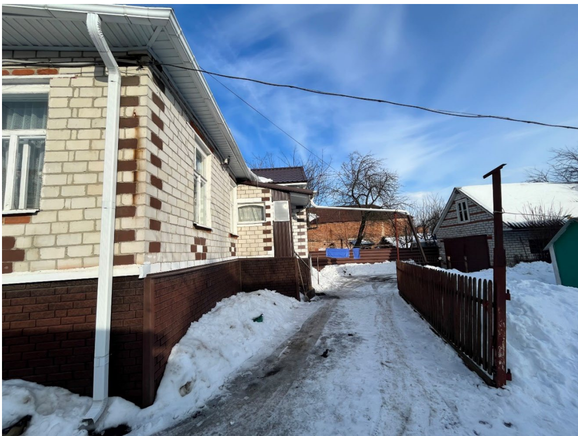
Т.ф. 6. Вид с юга на юго-восточный фасад и двор Объекта
