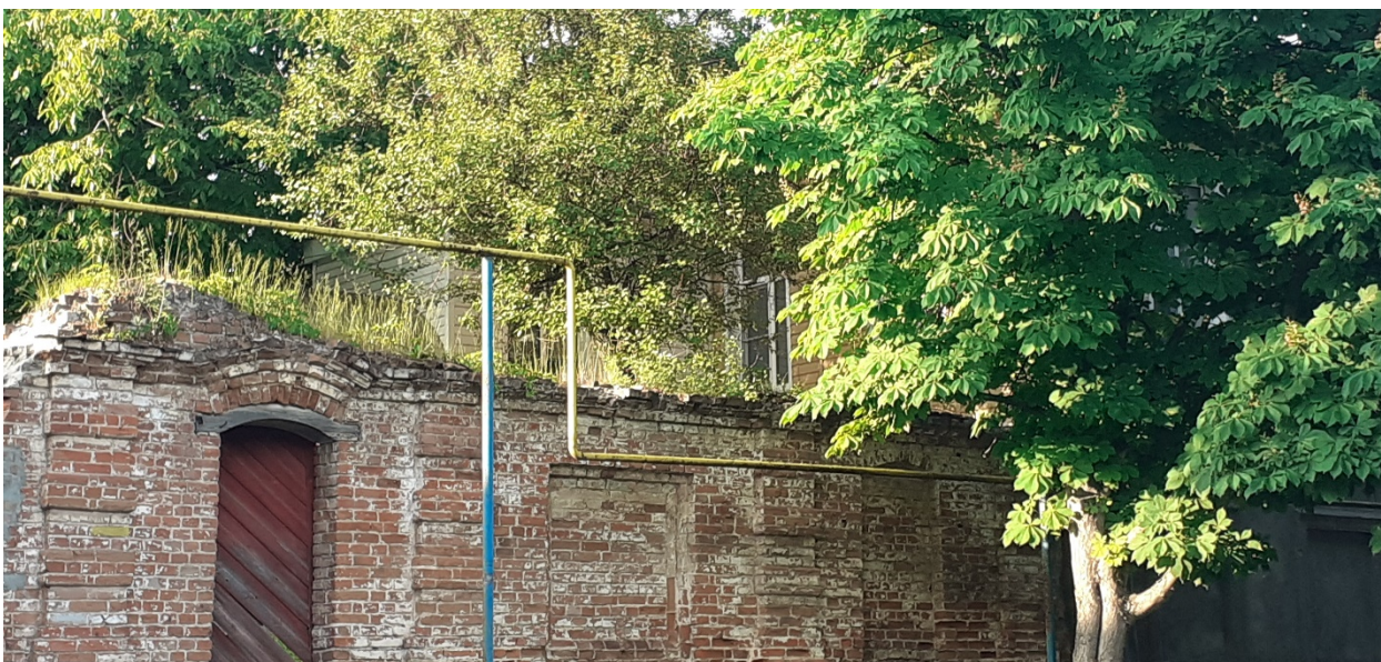
Фотография № 8. Вид с юго-запада на Объект.
