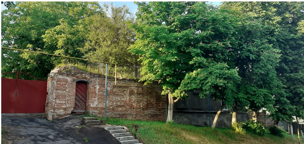
Фотография № 9. Вид с юго-запада на Объект.
