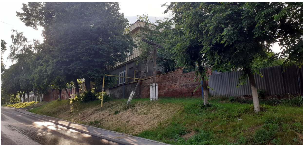
Фотография № 2. Вид с юго-востока на Объект.
