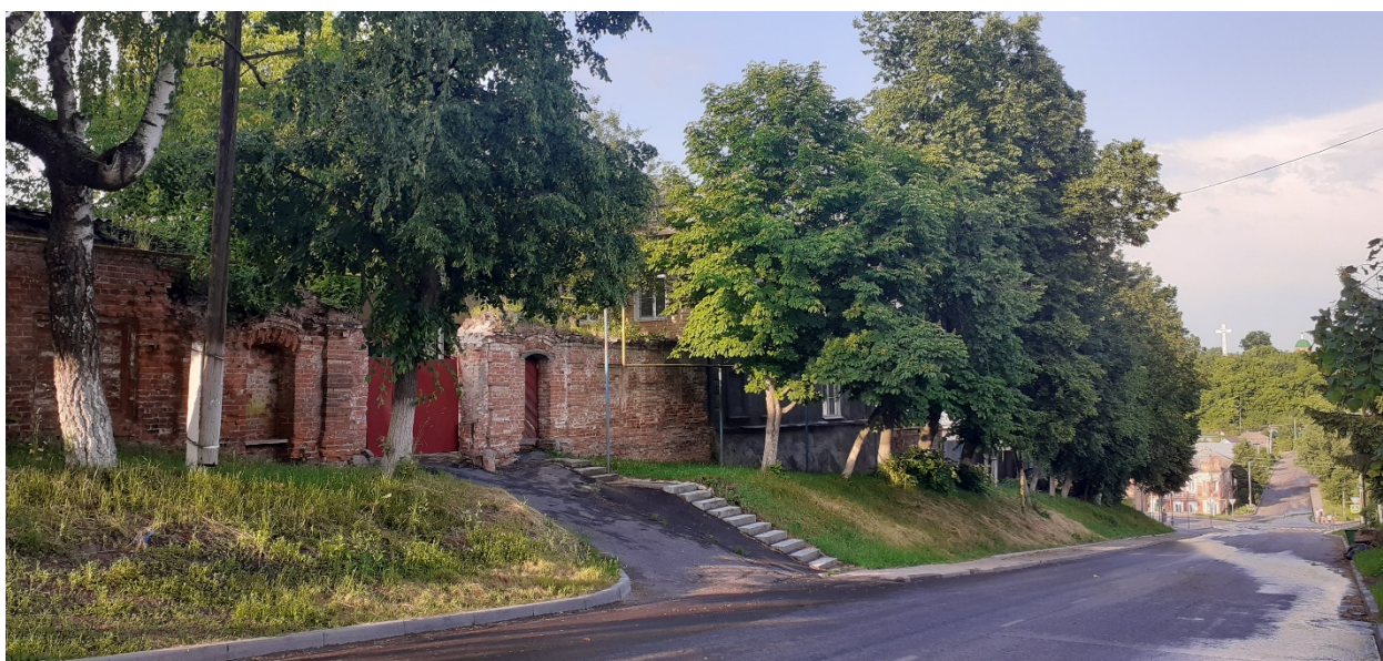
Фотография № 10. Вид с юго-запада на Объект.
