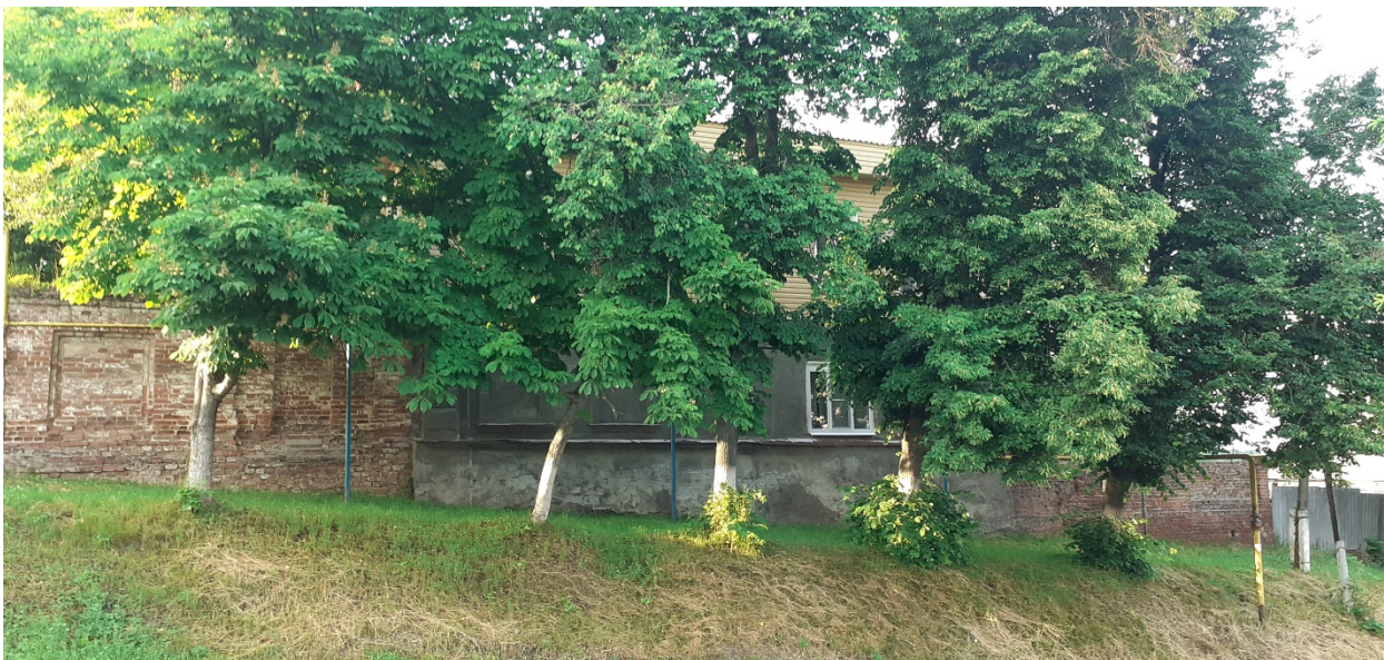
Фотография № 7. Вид с юго-запада на Объект.
