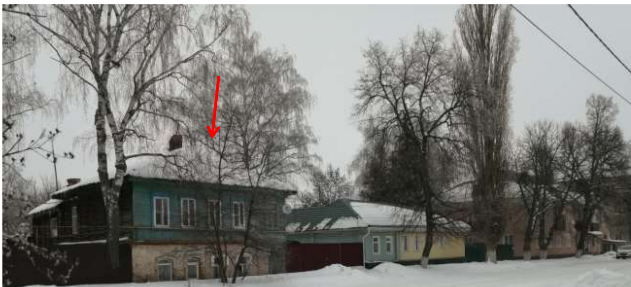
Выявленный объект культурного наследия «Дом жилой, кон. XIX – нач. XX вв.» по адресу: Курская обл., г. Щигры, ул. Комсомольская, д.18. Общий вид в существующей застройке четной стороны улицы Комсомольской. Объект указан стрелкой. Фото Т.С.Старцевой, февраль, 2022 года.
