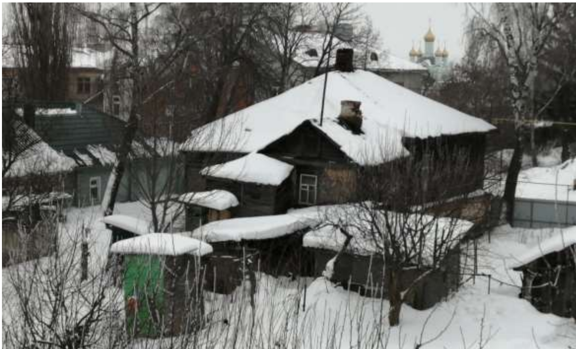
Выявленный объект культурного наследия «Дом жилой, кон. XIX – нач. XX вв.» по адресу: Курская обл., г. Щигры, ул. Комсомольская, д.18. Торцевой западный и дворовый фасады. Фото Т.С.Старцевой, февраль, 2022 года.
