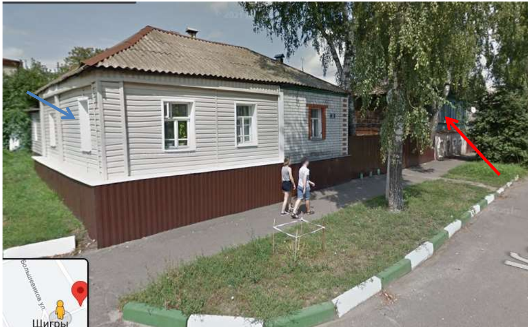
Город Щигры. Фрагмент застройки четной стороны улицы Комсомольской. Красной стрелкой указан Объект исследования - дом № 18, синей стрелкой – дом № 20. Фото с сайта https://www.google.com/maps/place/Комсомольская+ул.,+13,+Щигры,+Курская+obl
