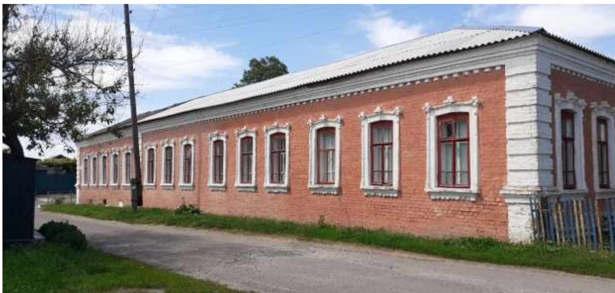
Фотография № 7. Вид с юго-востока на Объект.
