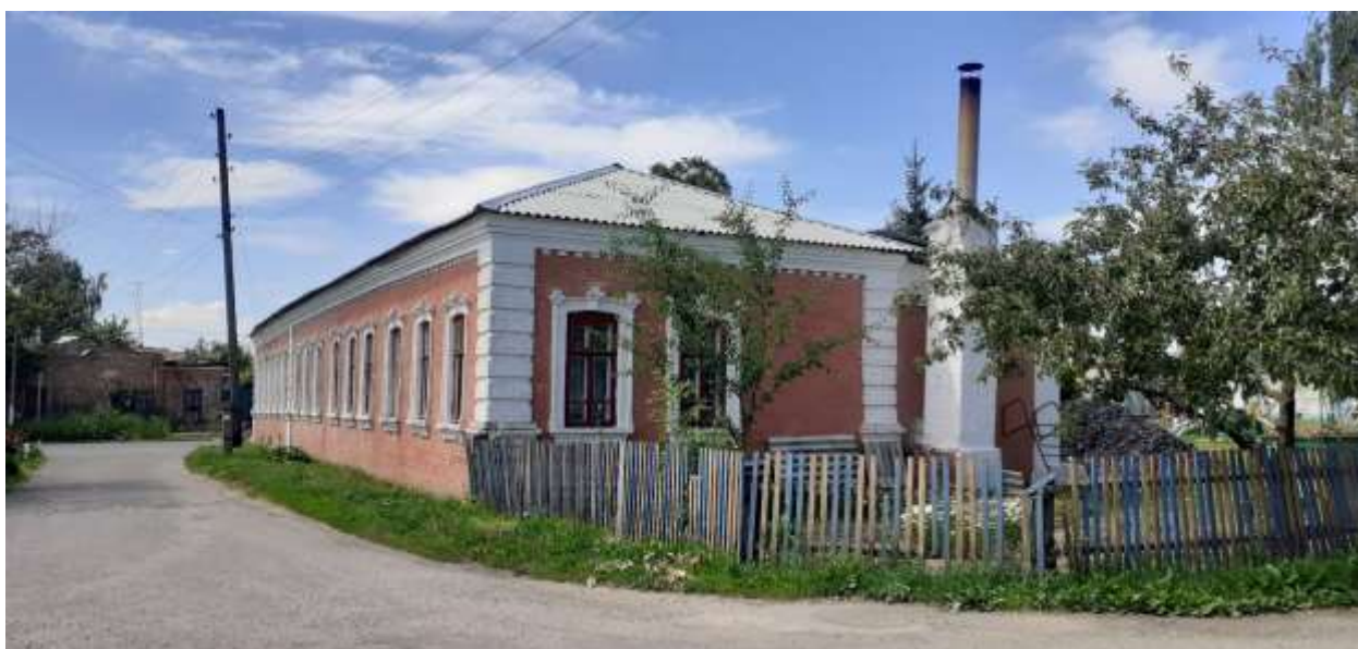
Фотография № 8. Вид с юго-востока на Объект.
