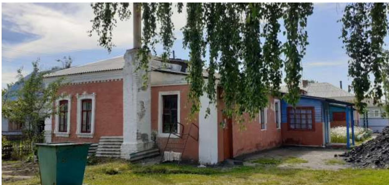
Фотография № 11. Вид с северо-востока на Объект.
