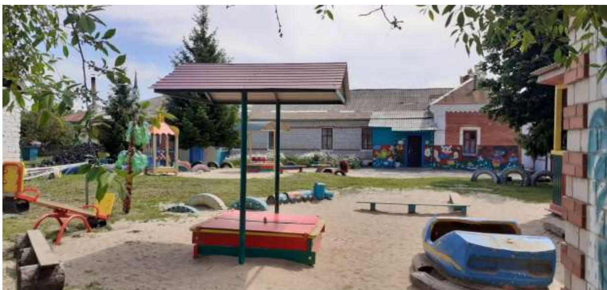
Фотография № 12. Вид с севера на Объект.
