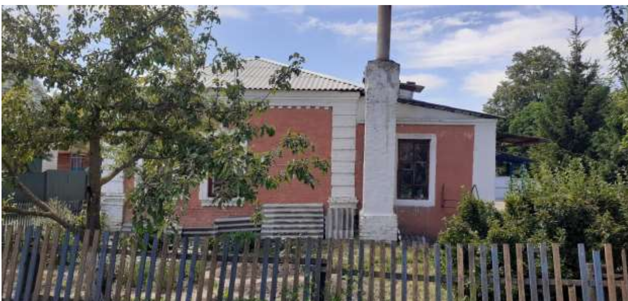
Фотография № 10. Вид с востока на Объект.
