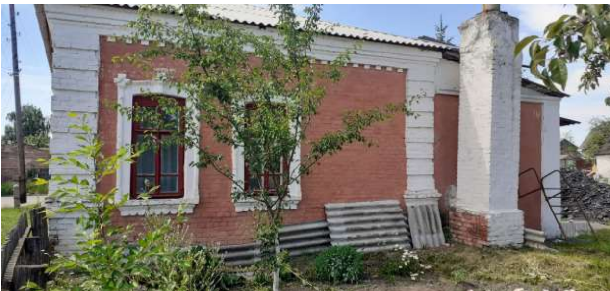
Фотография № 9. Вид с востока на Объект.
