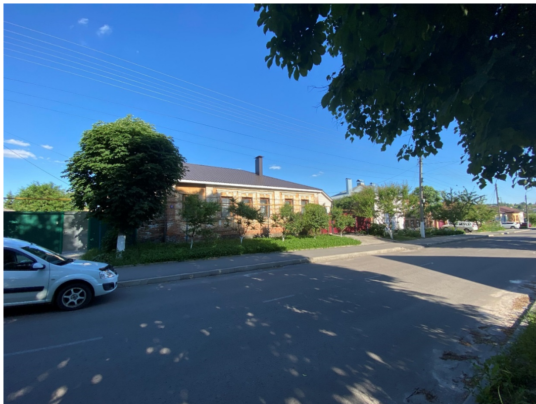
Фотография № 4. Вид с северо-запада на Объект.
