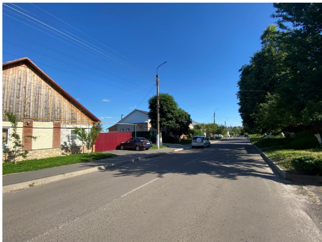
Фотография № 2. Вид с северо-запада на Объект.
