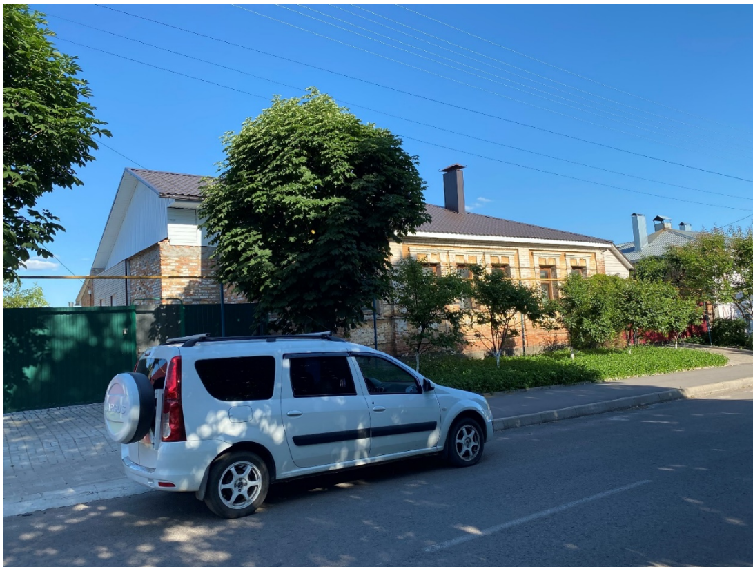
Фотография № 5. Вид с северо-запада на Объект.
