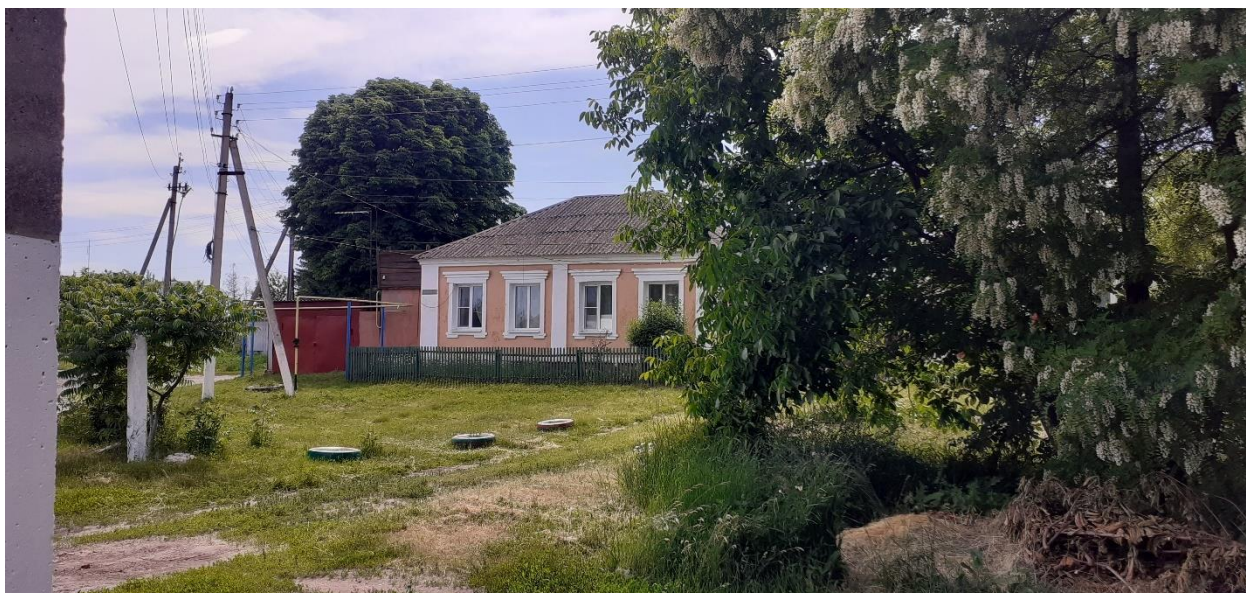
Фотография № 1. Вид с северо-востока на Объект.
