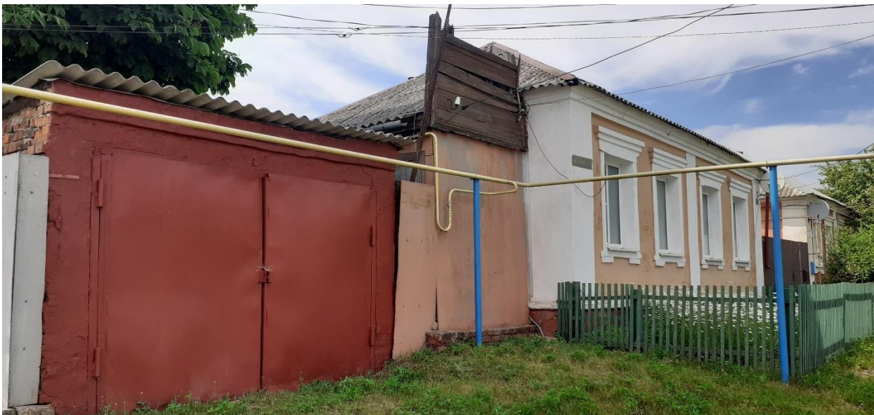
Фотография № 7. Вид с юго-востока на Объект.
