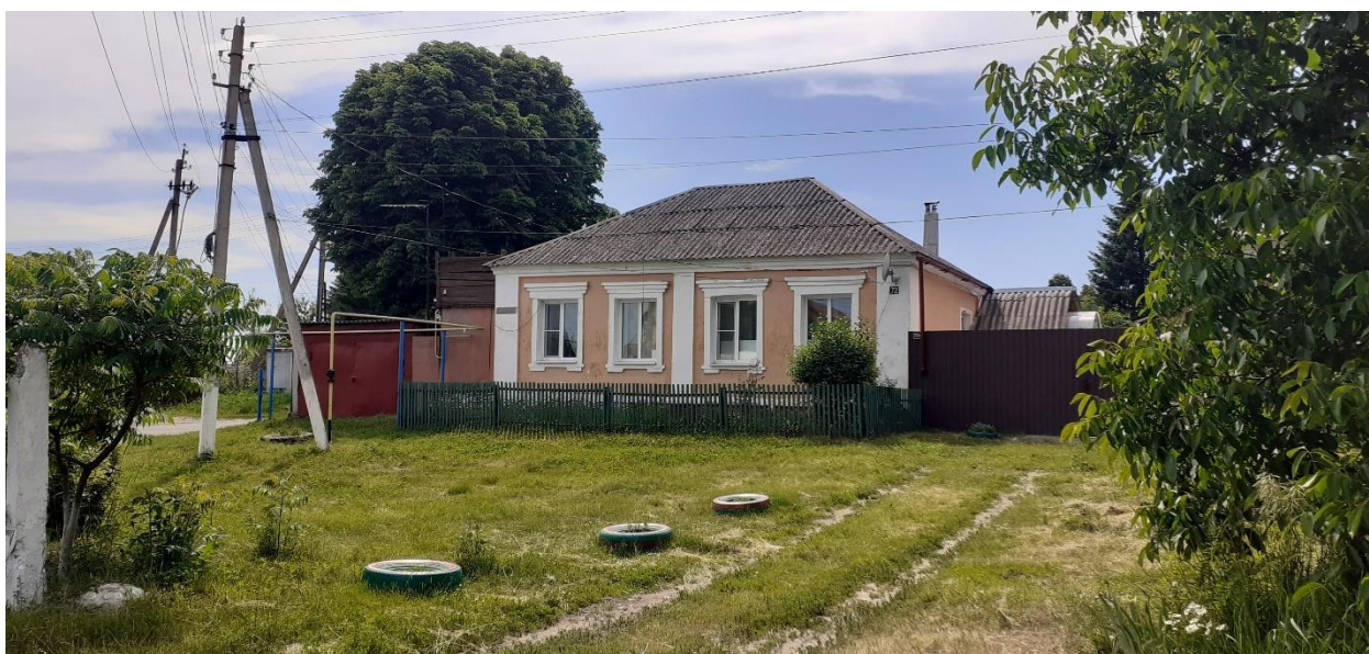
Фотография № 2. Вид с востока на Объект.
