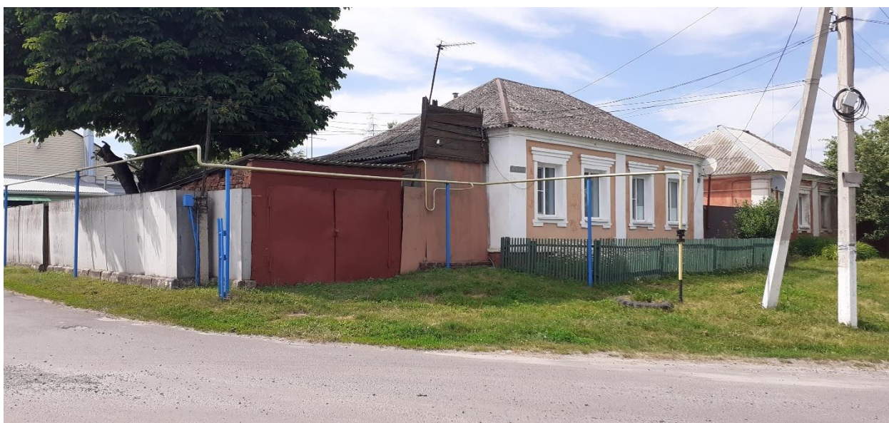
Фотография № 6. Вид с юго-востока на Объект.
