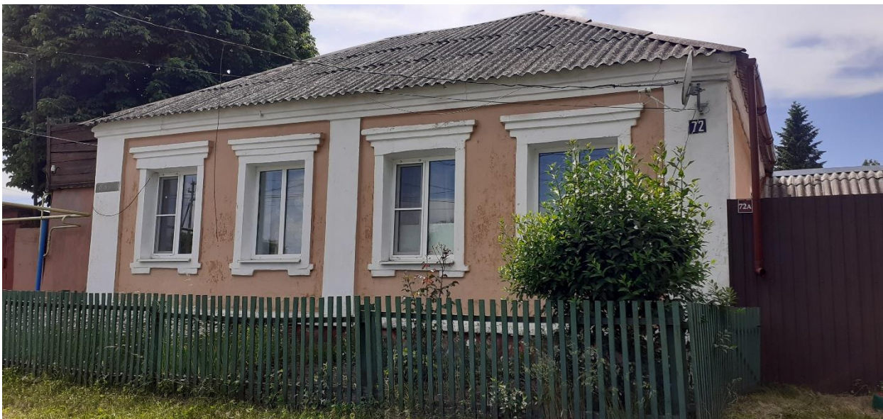
Фотография № 3. Вид с востока на Объект.
