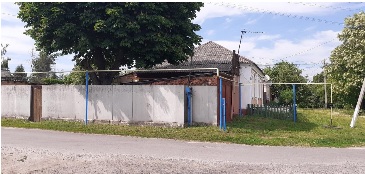
Фотография № 8. Вид с юга на Объект.
