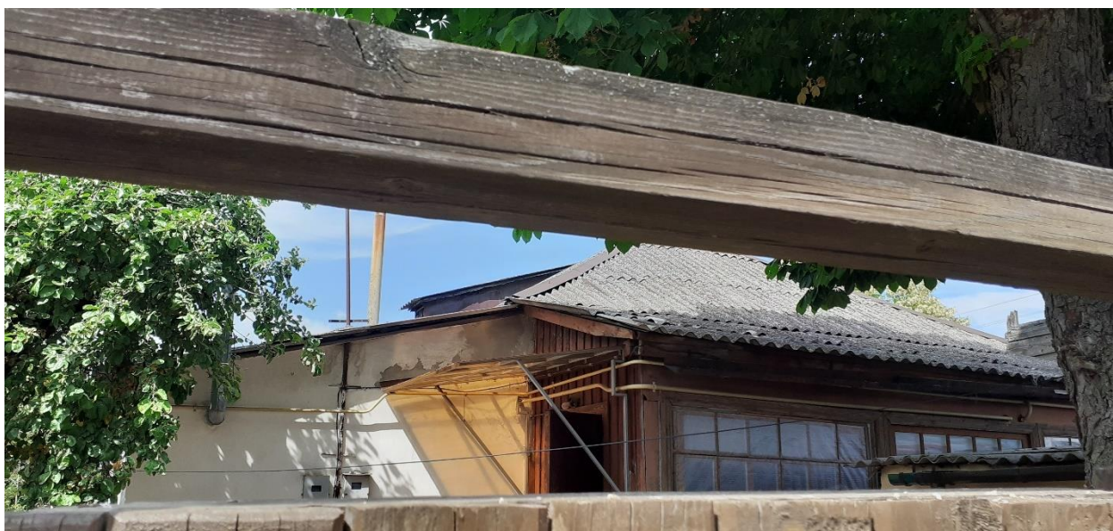
Фотография № 10. Вид с юго-запада на Объект. Южный фасад. Фрагмент.
