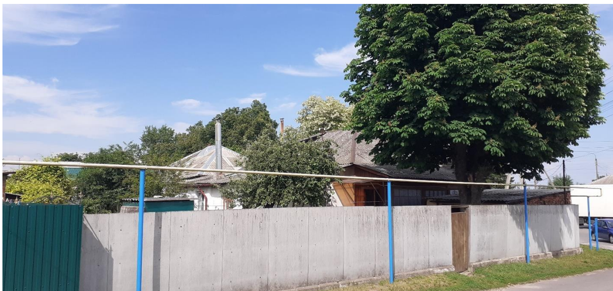
Фотография № 9. Вид с юго-запада на Объект.
