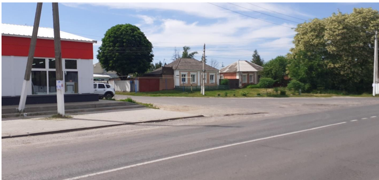
Фотография № 5. Вид с юго-востока на Объект.
