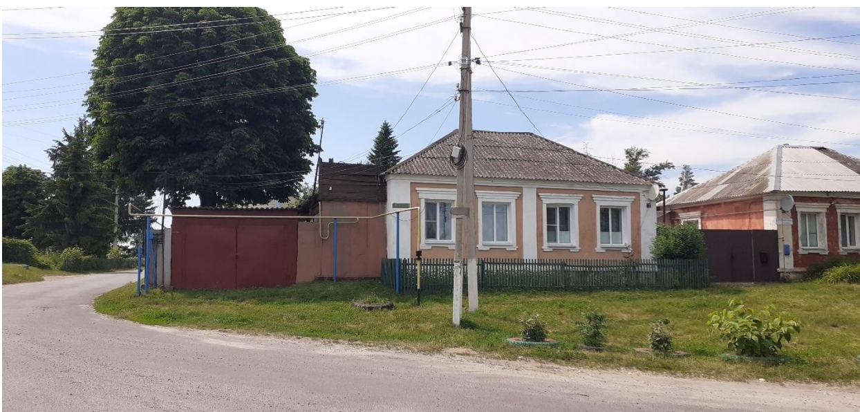
Фотография № 4. Вид с востока на Объект.
