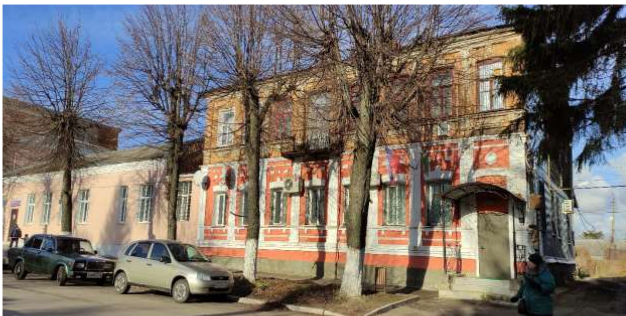
Фотография № 8. Вид с юго-востока на Объект.
