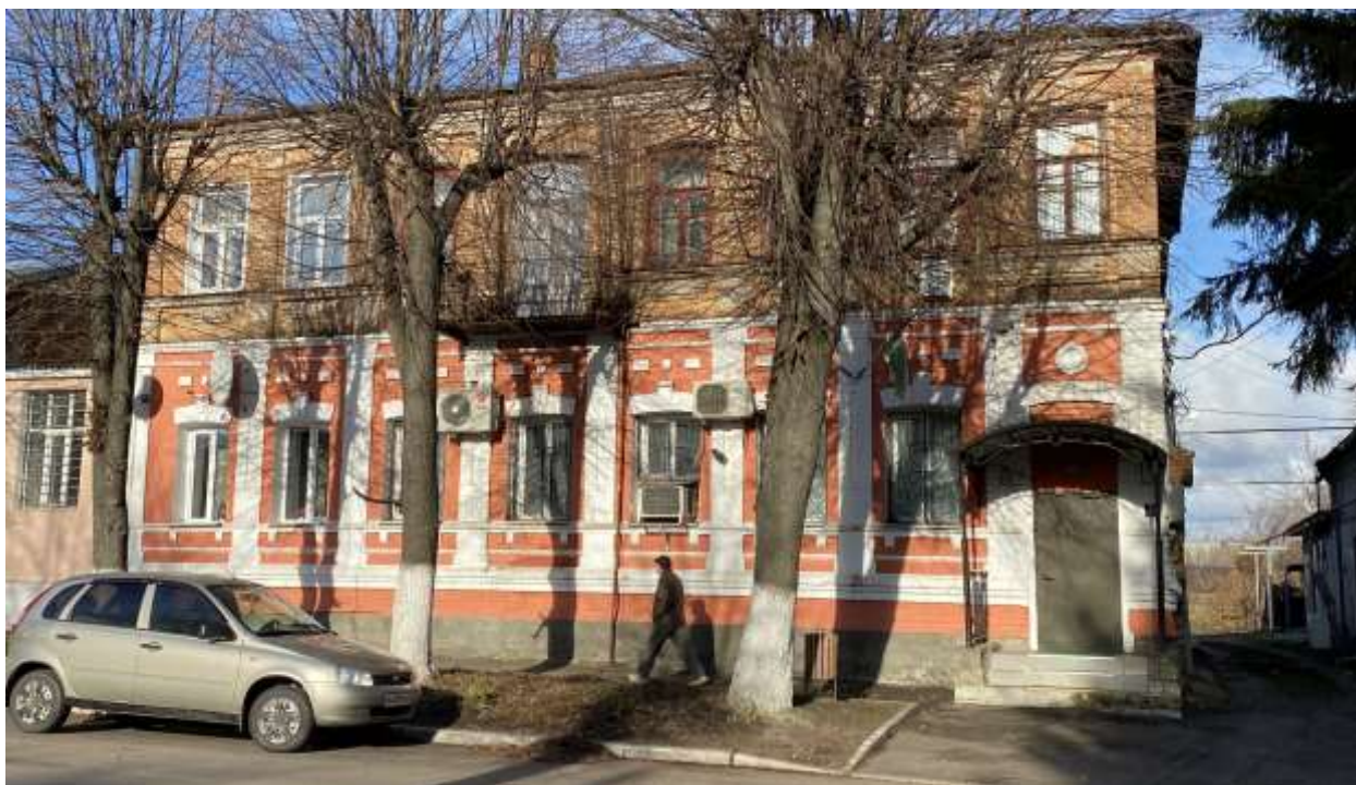
Фотография № 5. Вид с юга на Объект.
