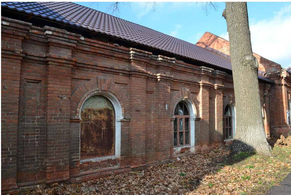
Фото1. ноябрь 2019. Фрагмент главного фасада по ул. Димитрова
