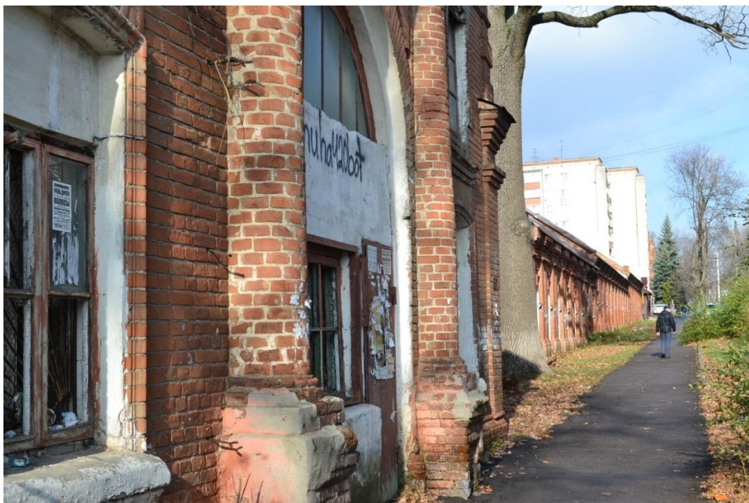
Фото 7. ноябрь 2019. Фрагмент входной группы (бывший вход в манеж)
