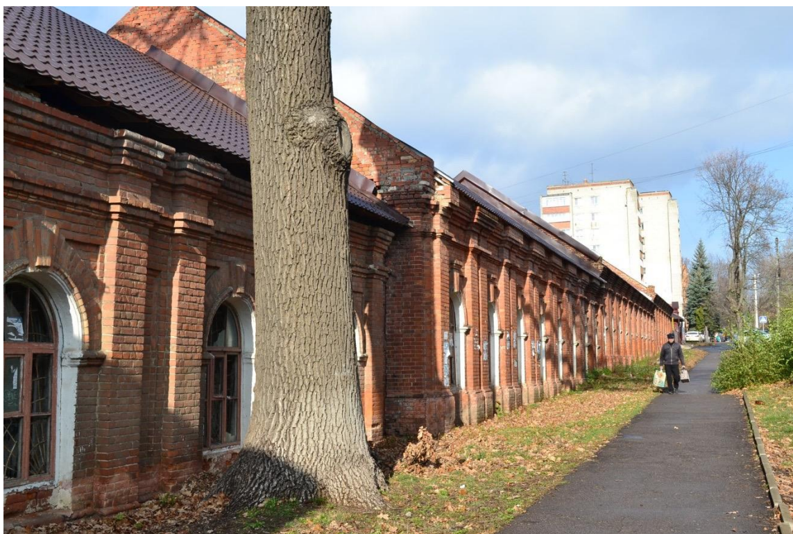
Фото2. ноябрь 2019. Фрагмент главного фасада по ул. Димитрова
