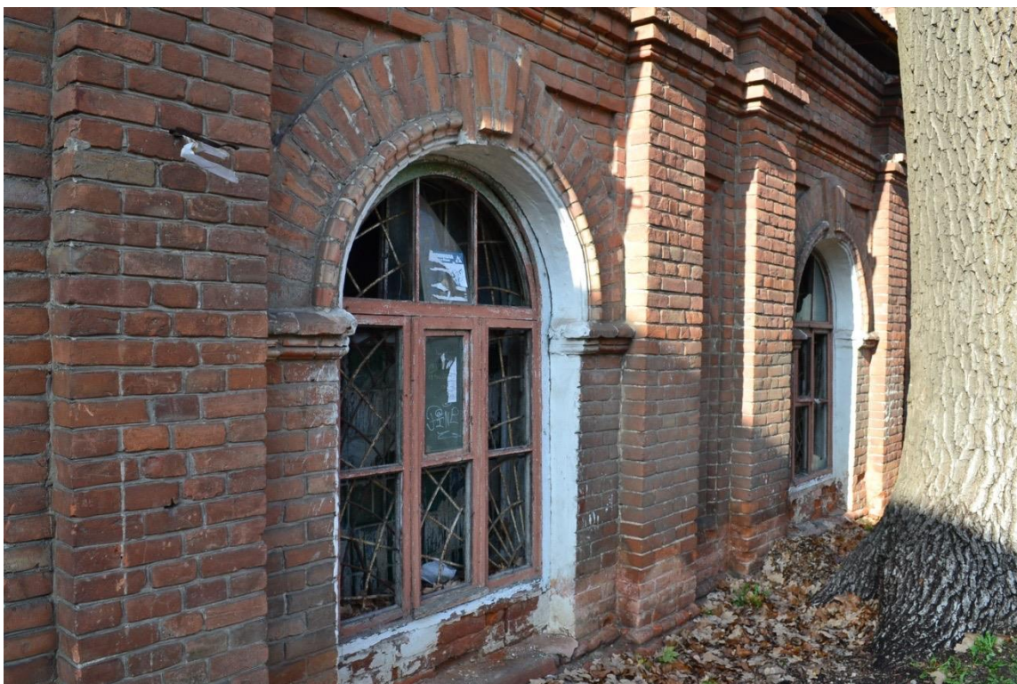
Фото 3. ноябрь 2019. Фрагмент главного фасада по ул. Димитрова
