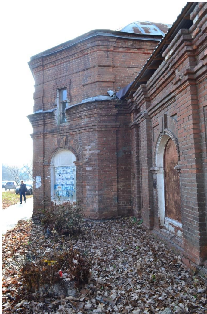
Фото 5. ноябрь 2019. Фрагмент главного фасада с северной стороны
