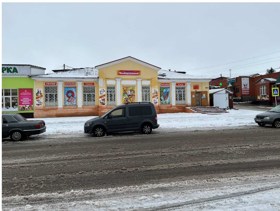
Фотография № 4. Вид с севера на Объект.
