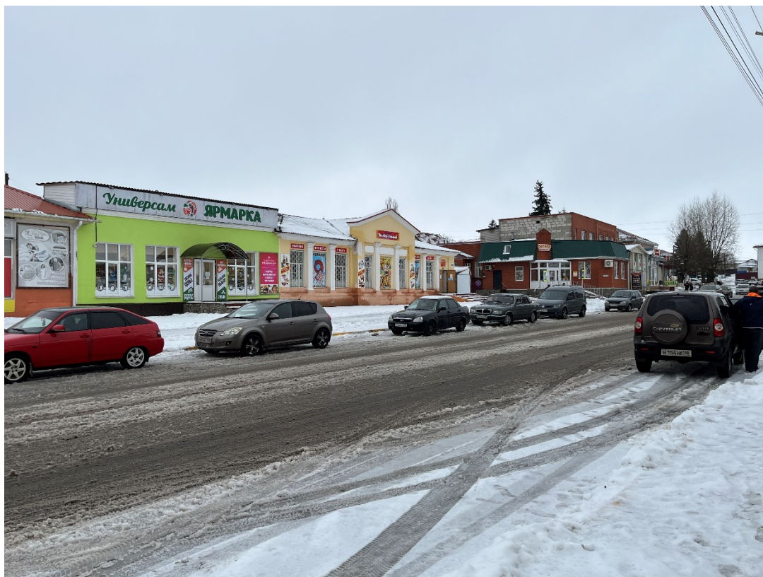
Фотография № 1. Вид с северо-востока на Объект.
