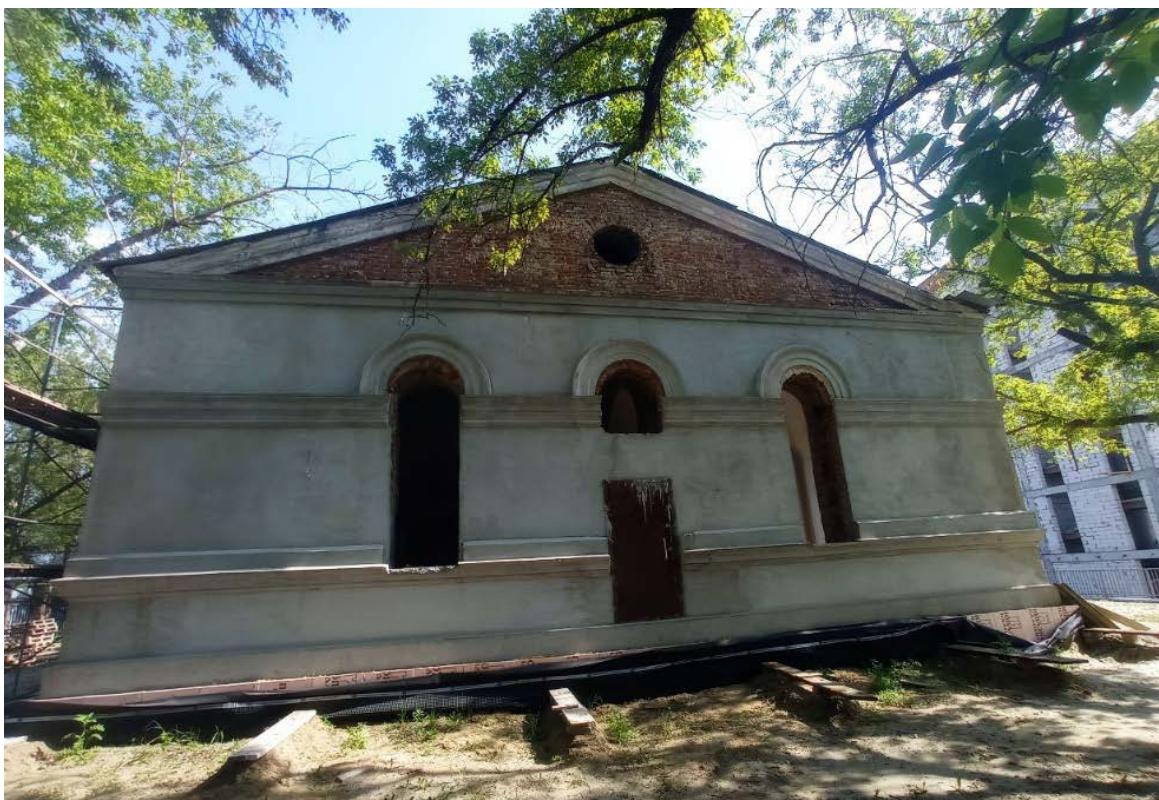
Фото 2. Общий вид Объекта со стороны бокового фасада.
