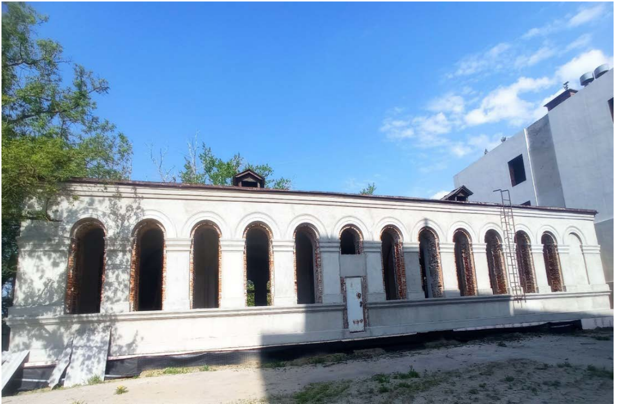
Фото 3. Общий вид Объекта со стороны дворового фасада.
