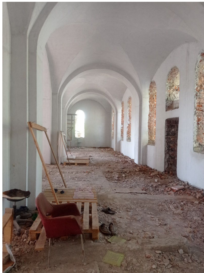
Фото 4. Интерьеры Объекта. помещения первого этажа.
