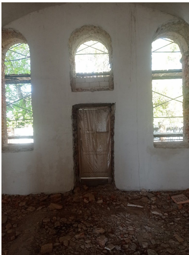
Фото 6. Интерьеры Объекта. помещения первого этажа.
