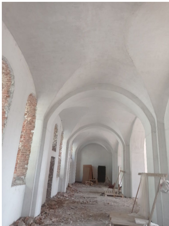
Фото 5. Интерьеры Объекта. помещения первого этажа.
