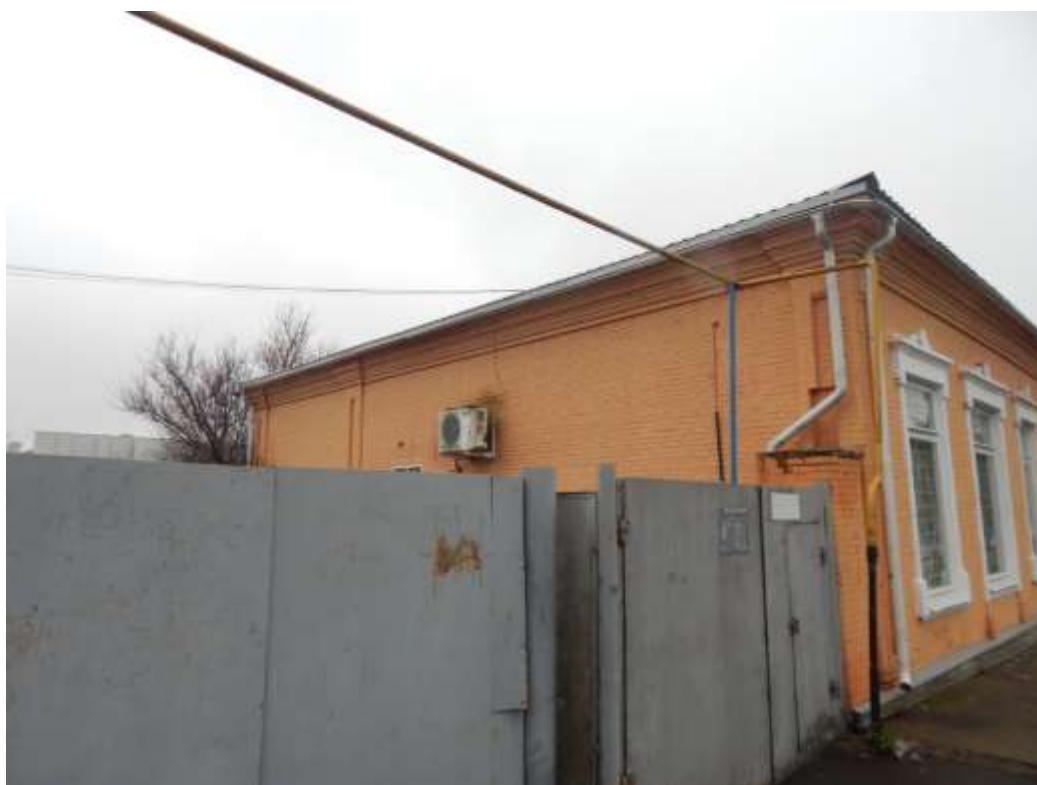
Т.ф. 2. Общий вид бокового фасада Объекта со стороны ул. Розы Люксембург.
