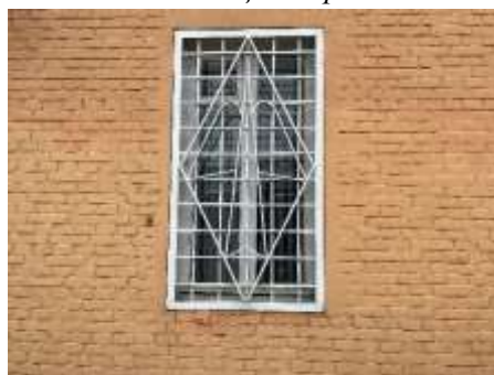
Оконный проем северного фасада
