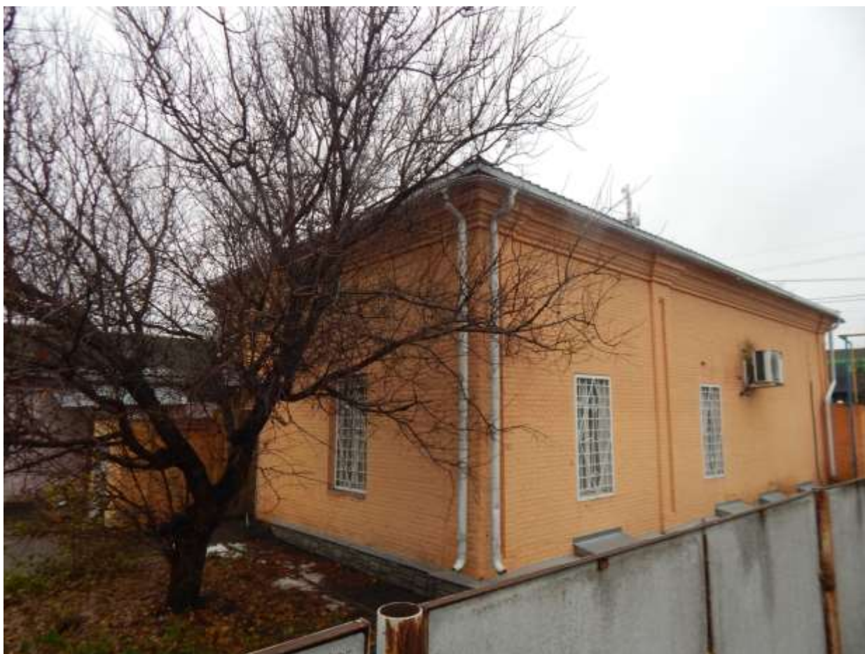
Т.ф. 4. Общий вид Объекта со стороны ул. Розы Люксембург.
