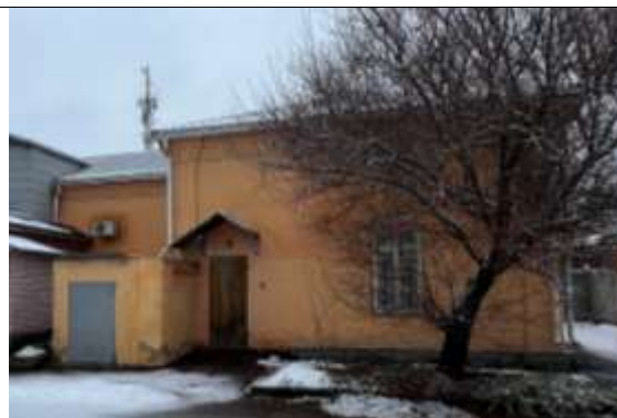
композиция восточного фасада
