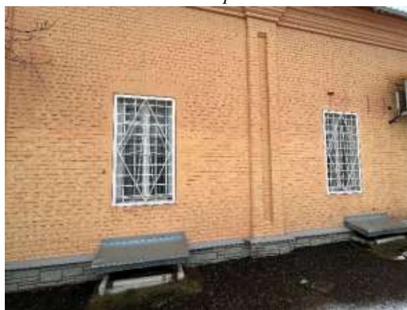
Световые прямки подвала, лопатка
