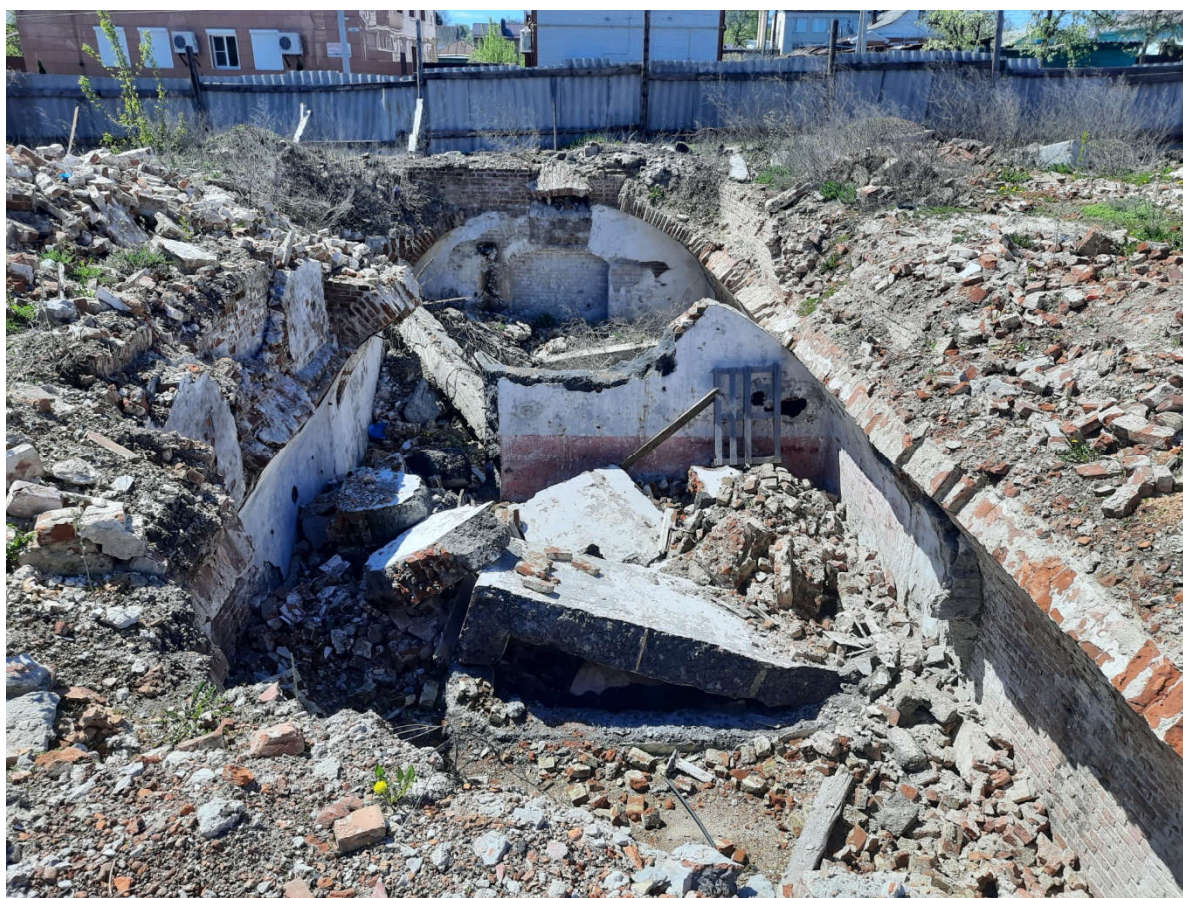
Фото 12. Сохранившиеся фрагменты арочных погребов, расположенных в северо-западной части земельного участка.
