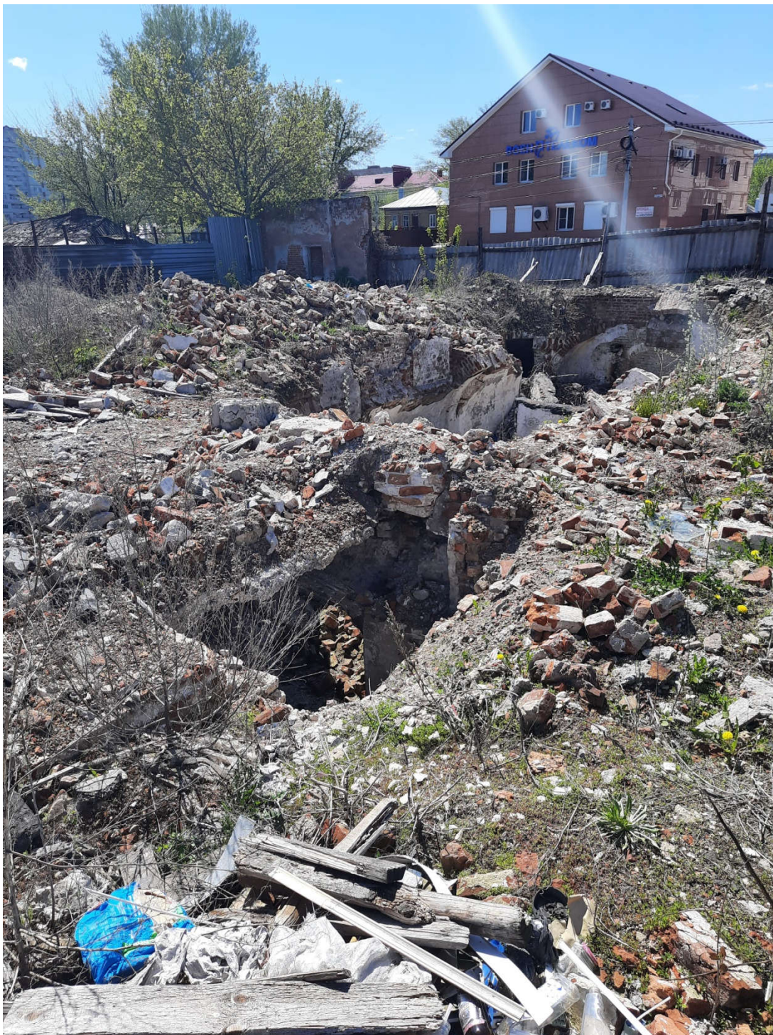
Фото 13. Сохранившиеся фрагменты арочных погребов, расположенных в северо-западной части земельного участка.
