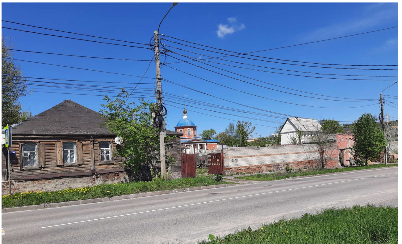
Фото 4. Общий вид с юго-запада, со стороны перекрёстка ул. Большевиков и Карла Либкнехта.
