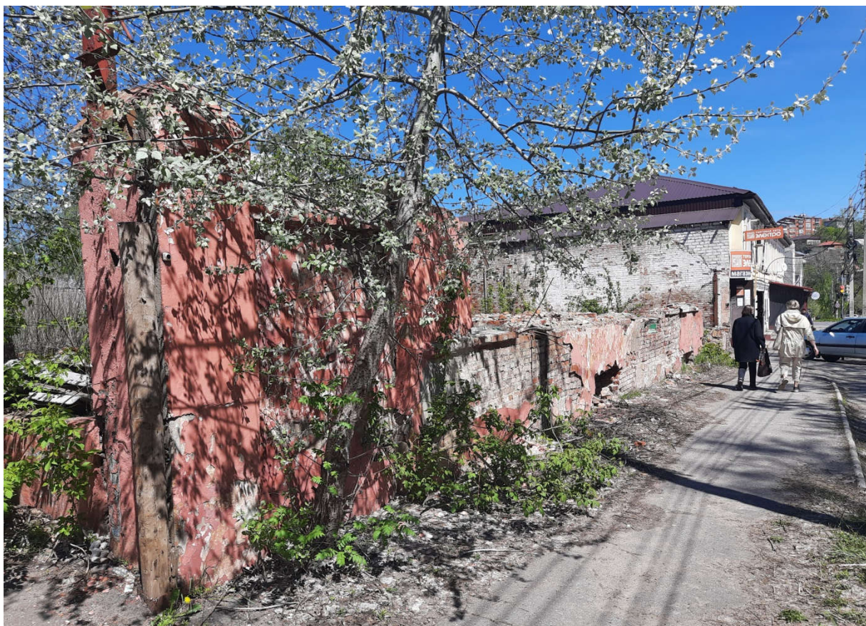
Фото 2. Общий вид с юго-запада со стороны ул. Большевиков.
