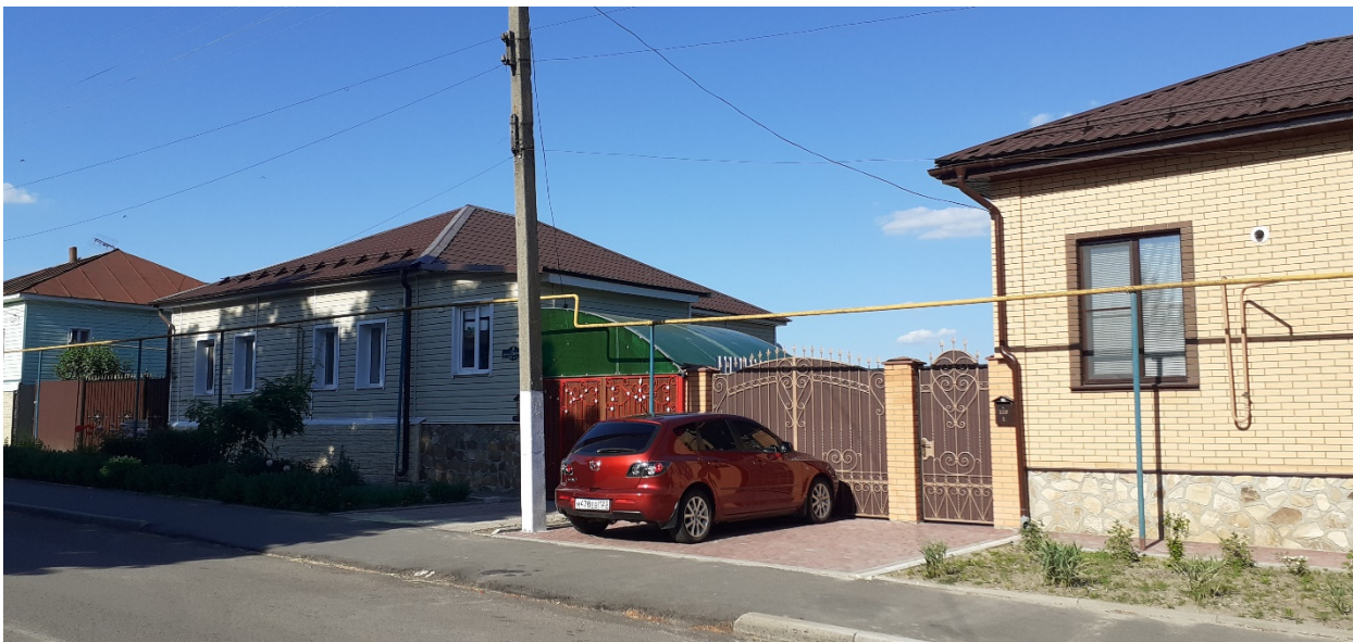
Фотография № 9. Вид с юго-запада на Объект.
