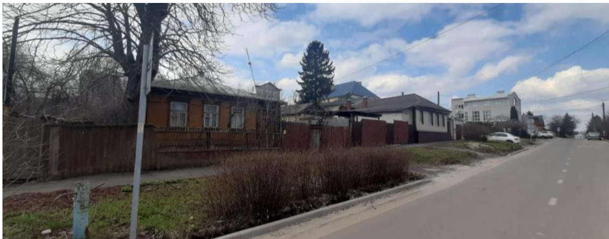
Рис. 16. Жилой дом по ул. Ломоносова, 54, 54А На переднем фоне – дом № 54А, далее – дом № 54. Фото Оболенской Н.С. 04.04.2023 г.
