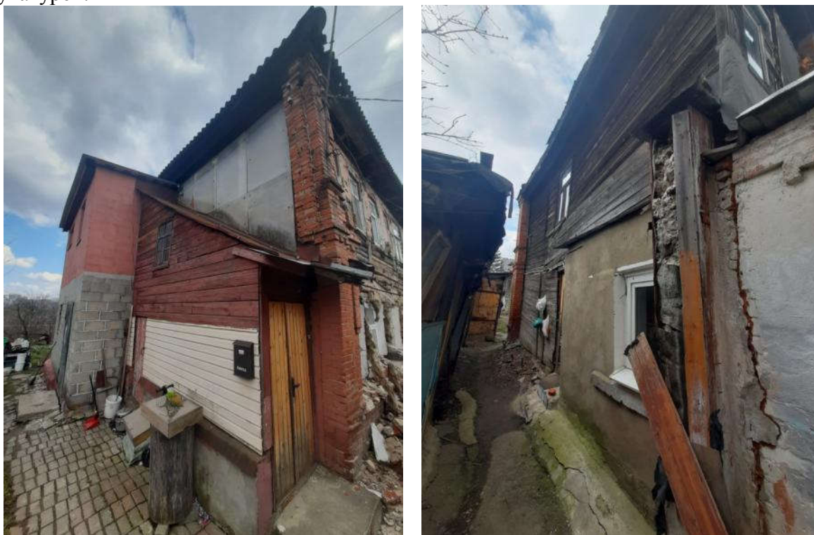
Рис. 25. Выявленный объект культурного наследия «Дом жилой, 1907 г.» Курская обл., г. Курск, ул. Ломоносова, 39 Слева – северо-западный торцевой фасад. Справа – юго-восточный торцевой фасад Фото Оболенской Н.С. 04.04.2023 г.
