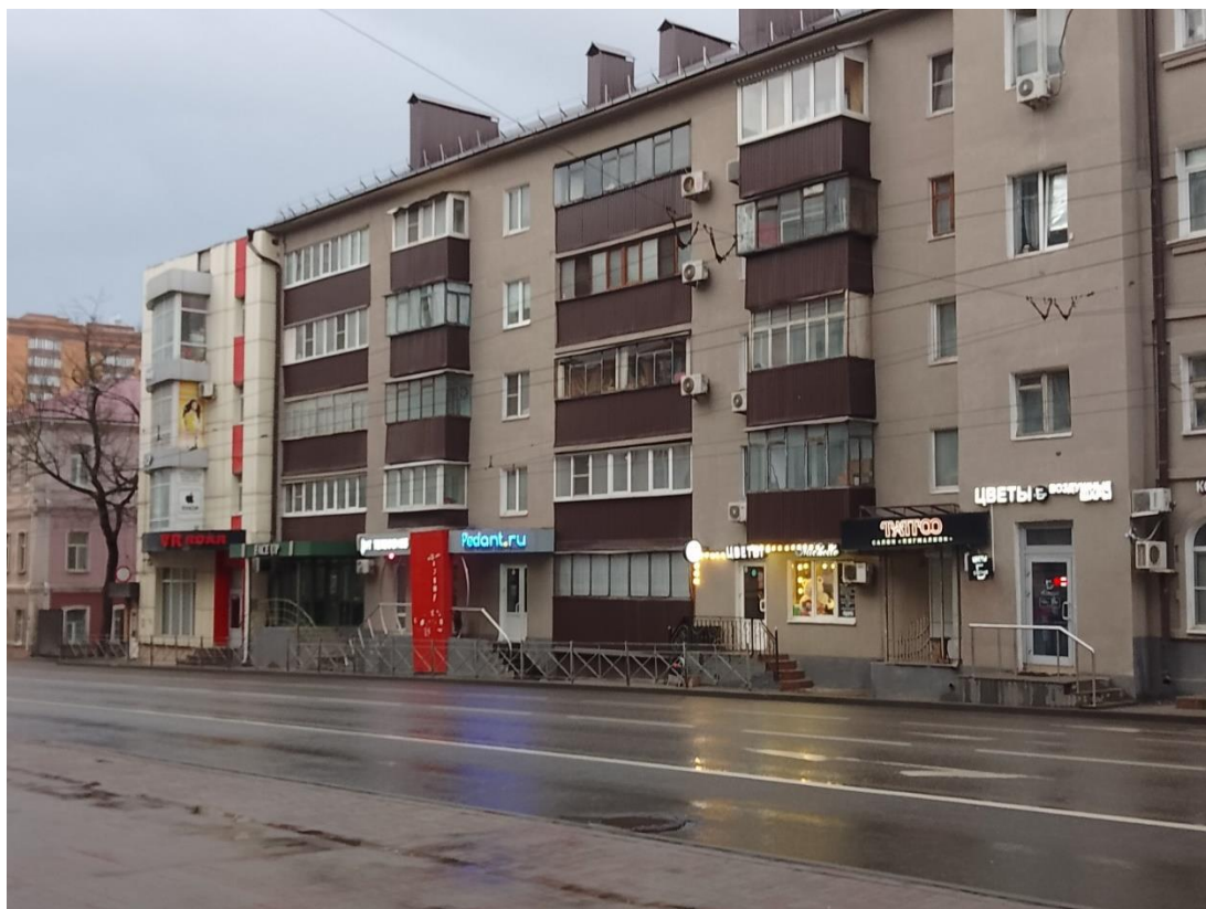
Фотография № 3. Вид с северо-востока на территорию расположения Объекта.
