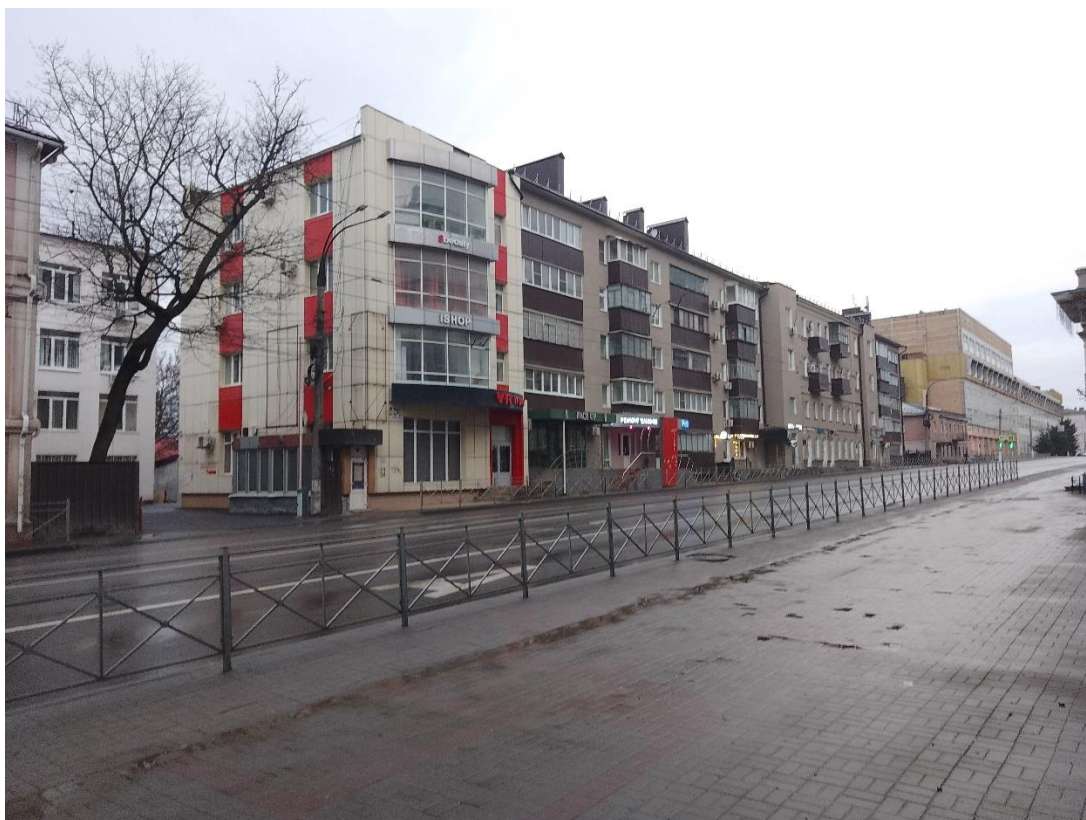
Фотография № 5. Вид с юго-востока на территорию расположения Объекта.
