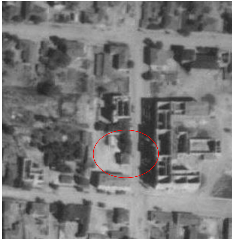
Территория объекта на выкопировке из аэрофотосъемки 1943 г.
