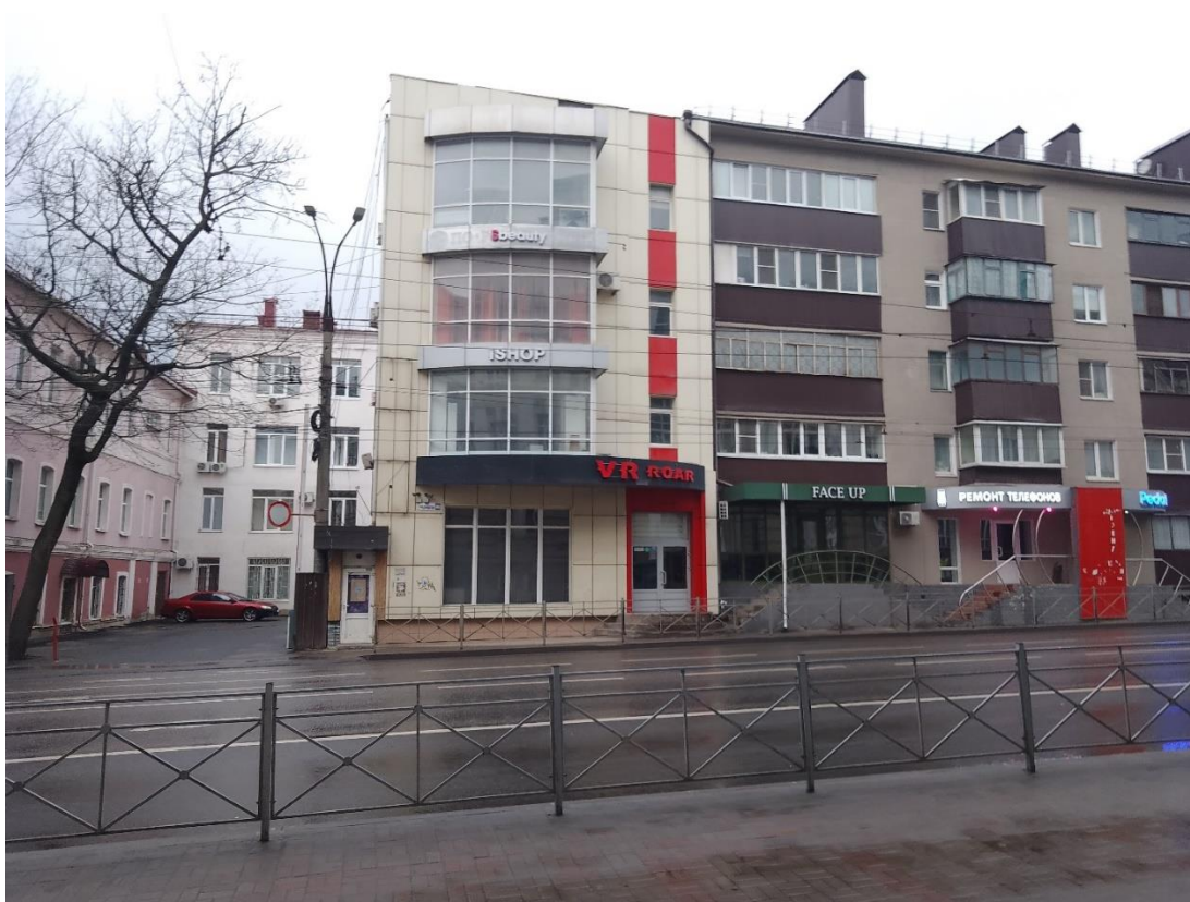
Фотография № 4. Вид с востока на территорию расположения Объекта.
