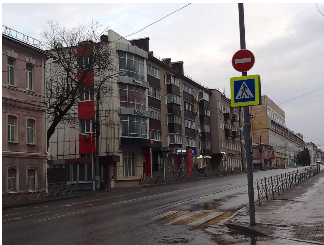
Фотография № 6. Вид с юго-востока на территорию расположения Объекта.
