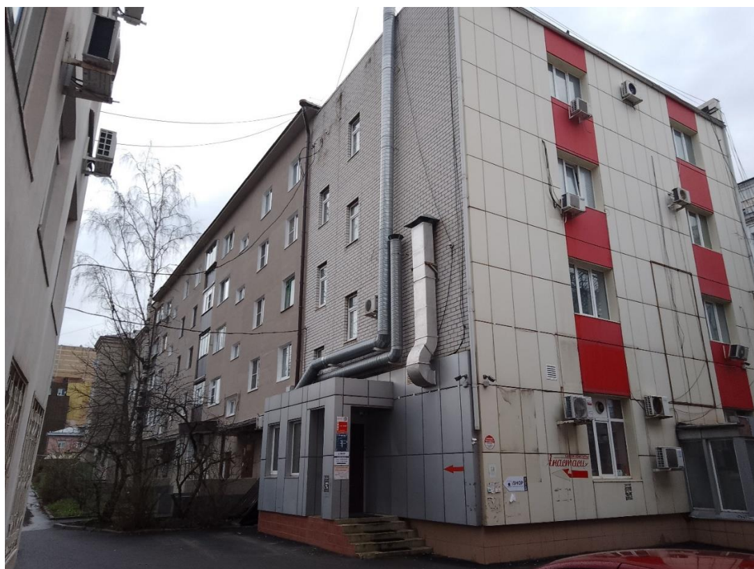
Фотография № 8. Вид с юга на территорию расположения Объекта.
