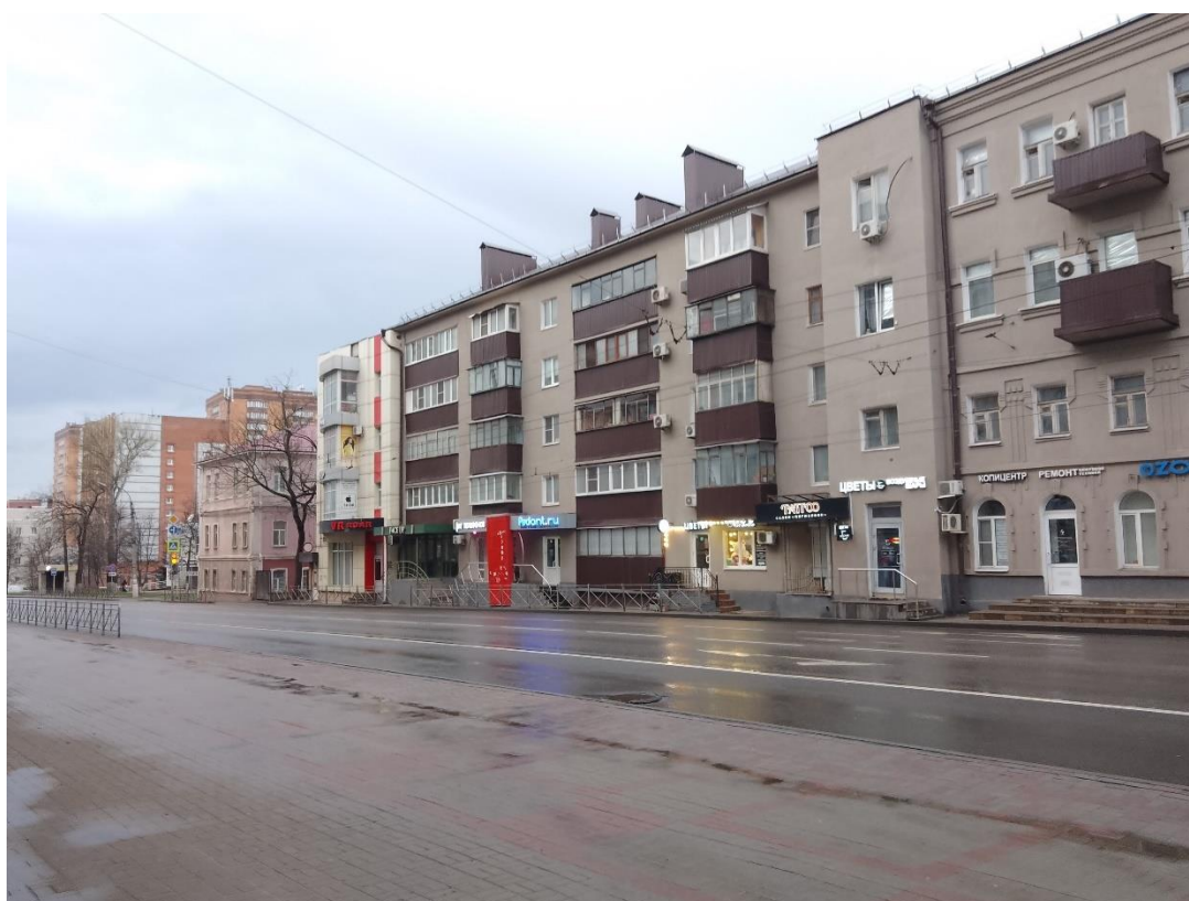
Фотография № 2. Вид с северо-востока на территорию расположения Объекта.
