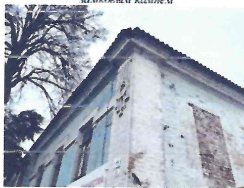
венчающий профилированный выступающий карниз, раскрепованный в уровне лопаток
