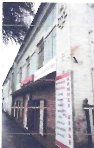
прямоугольные оконные проемы с клинчатыми перемычками второго этажа, украшенные «П»-образными сандриками
