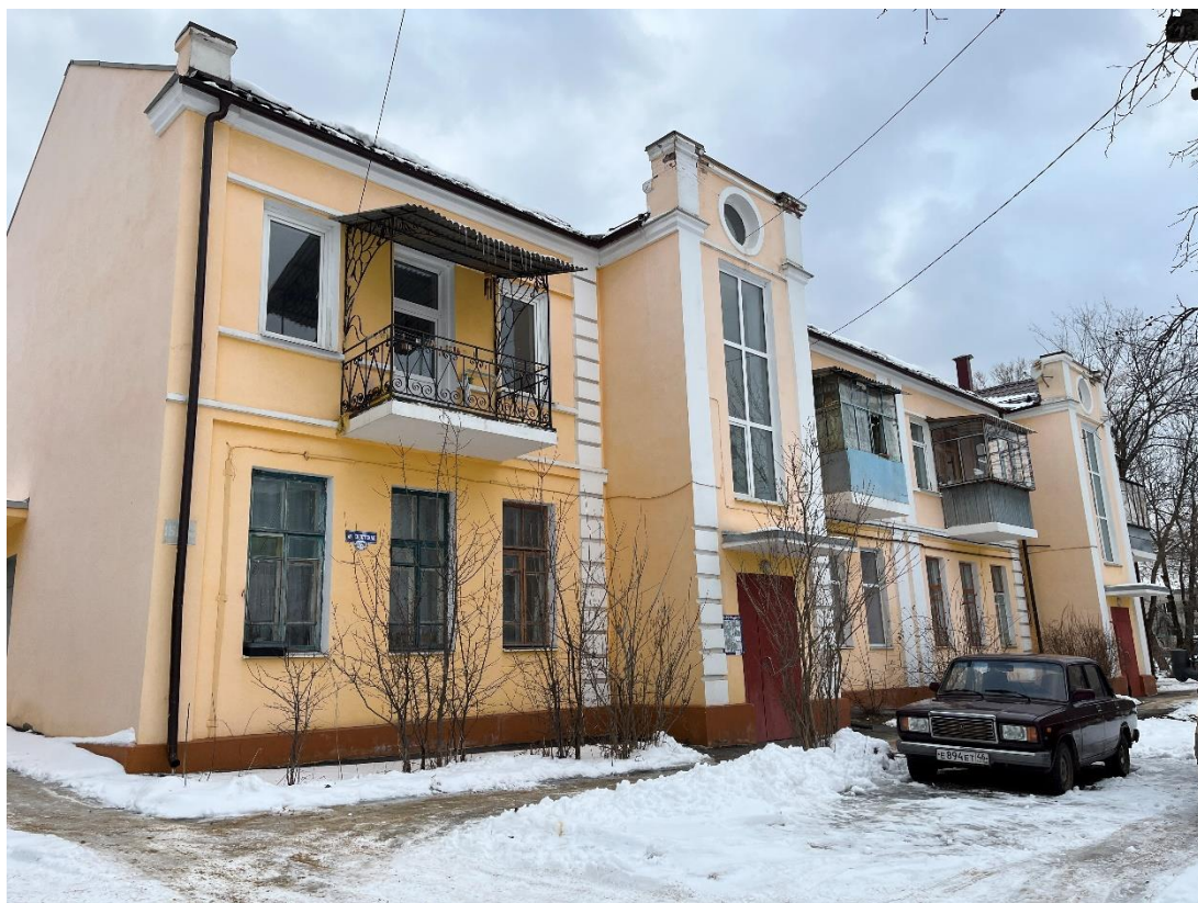
Фотография № 3. Вид с юго-востока на Объект.
