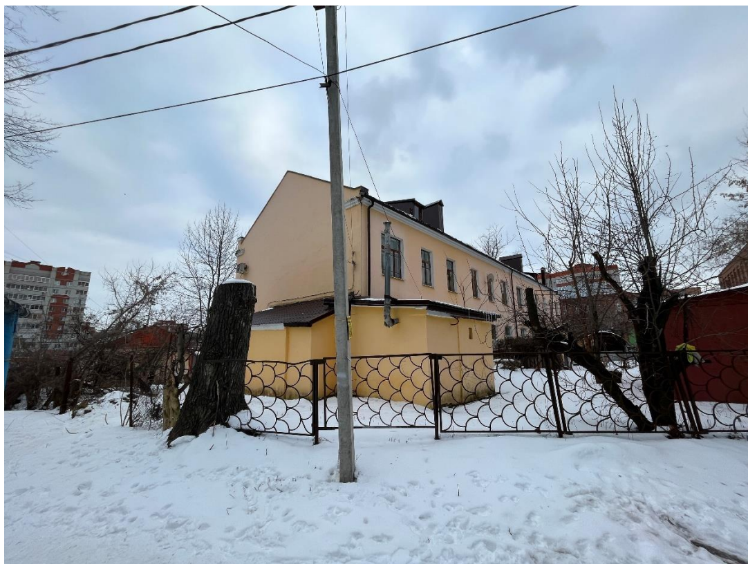
Фотография № 7. Вид с северо-запада на Объект.
