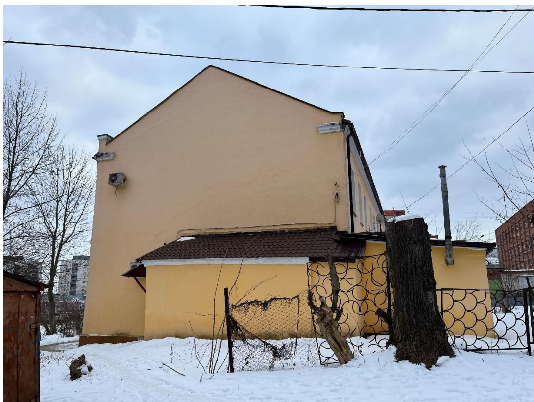
Фотография № 10. Вид с северо-запада на Объект.
