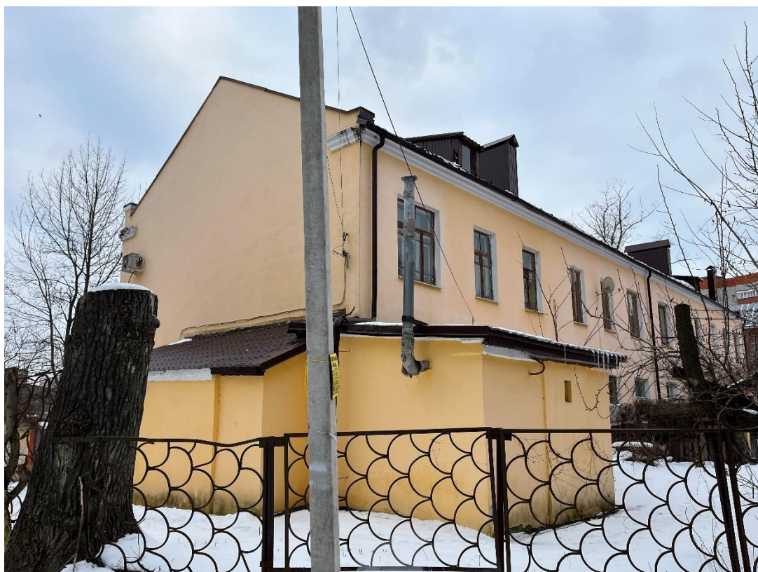
Фотография № 8. Вид с северо-запада на Объект.
