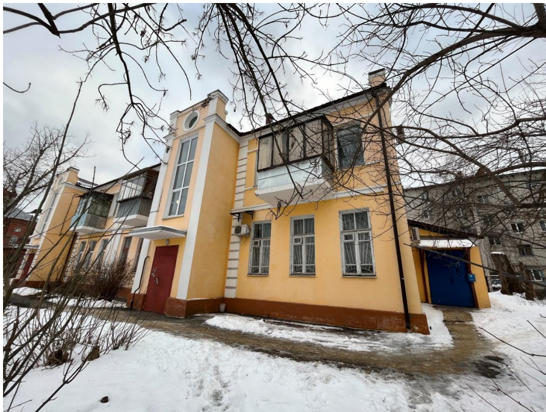
Фотография № 11. Вид с северо-востока на Объект.
