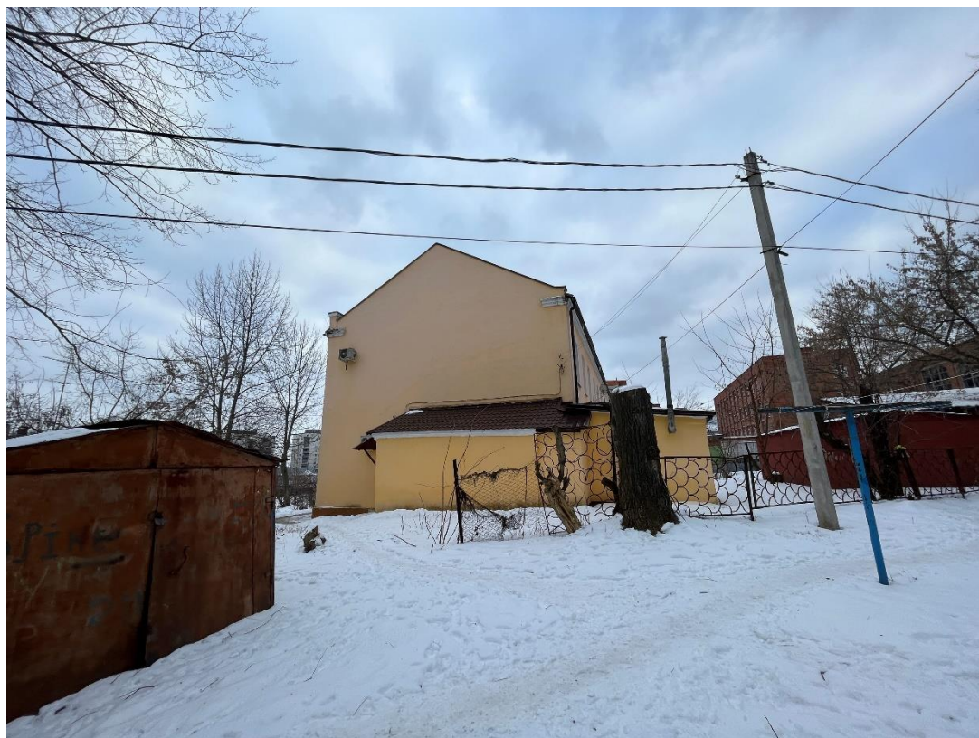
Фотография № 9. Вид с северо-запада на Объект.
